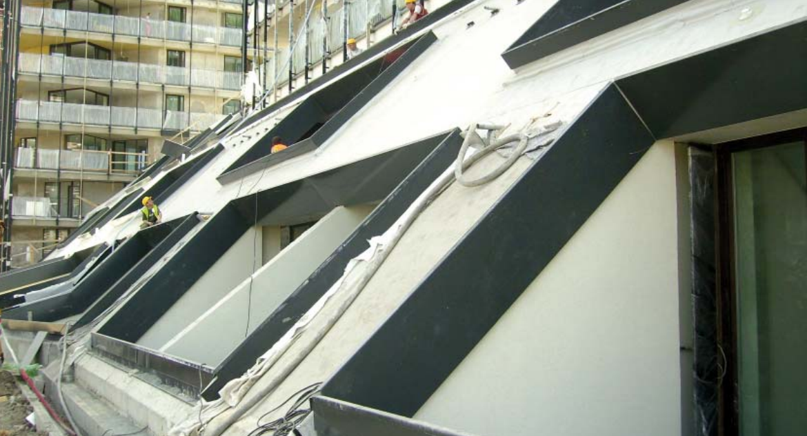
10 | Dokončený systém DUALDEK, krycí plechy okraje teras bytů
