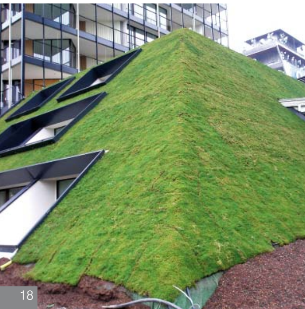
16| Na travní koberce šikmých střech ještě naváží sadové úpravy centrálního parku
