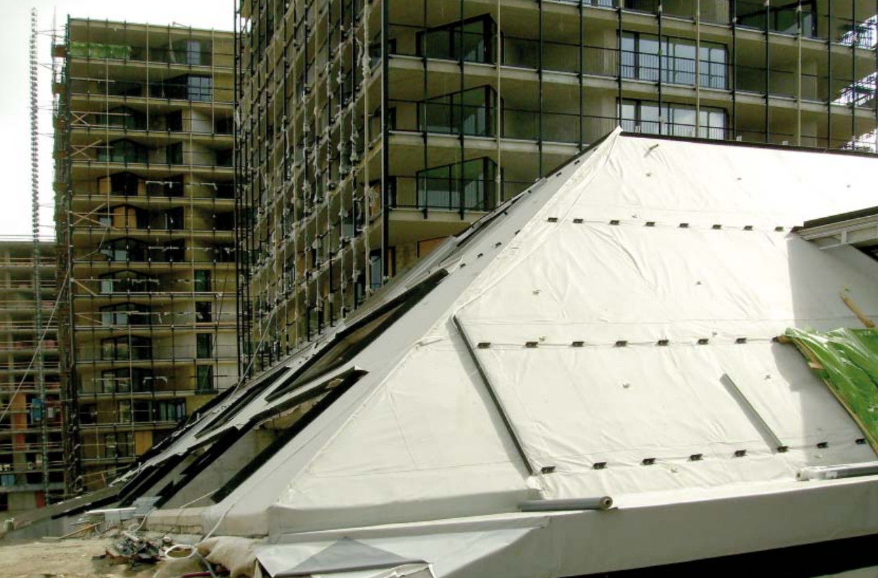
07| Dokončený systém DUALDEK, příprava stabilizačního systému pro vegetační souvrství skladby střechy.
