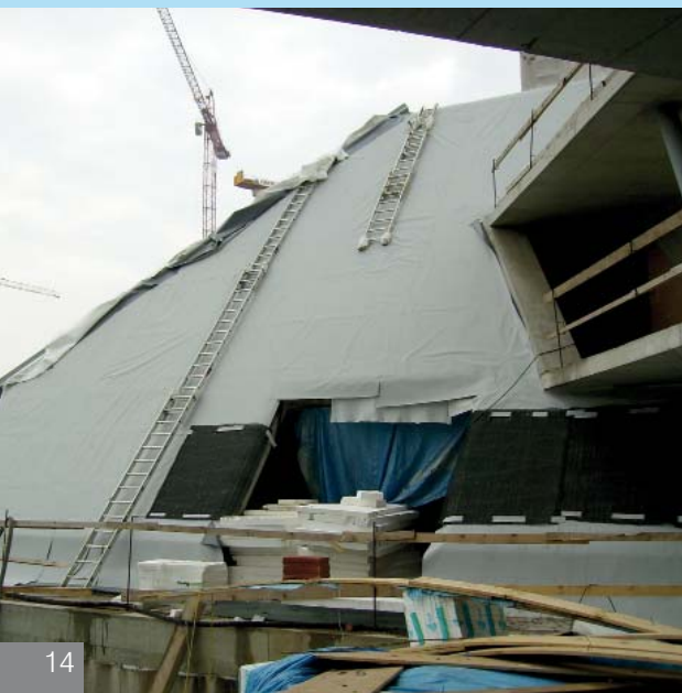
05| Pokládka drenážní vložky z černé smyčkové rohože z plastových vláken a druhé vrstvy hydroizolační fólie systému DUALDEK
