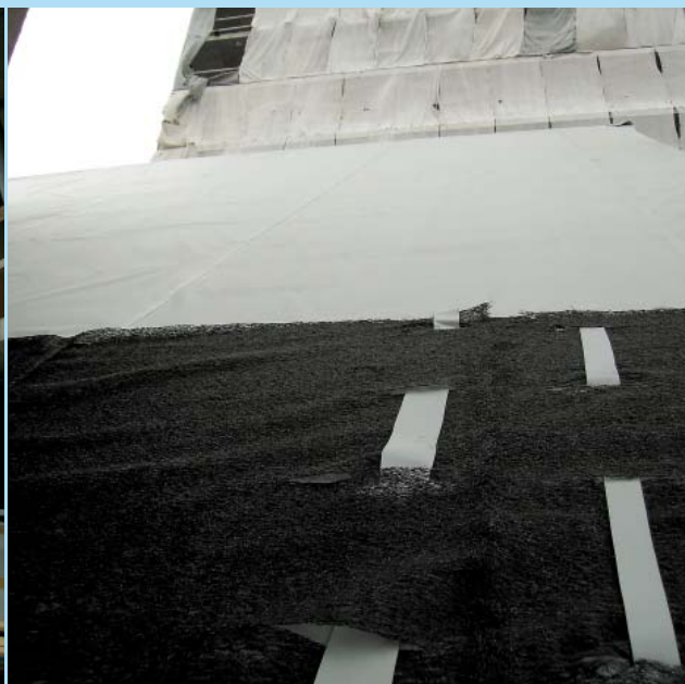
06| Detail fixace drenážní vložky z černé smyčkové rohože z plastových vláken. Vrstva je „prošita“ přířezy fólie natavenými k první vrstvě hydroizolace
