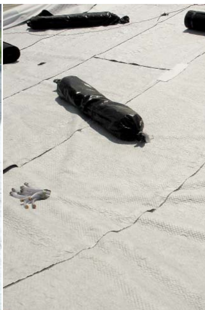
27 | Drenážní rohož provedena s integrovanou tkaninou na horním povrchu, aby beton mazaniny neomezil drenážní profil rohože. Hlavní funkcí drenážní vrstvy je vytvoření prostoru pro odvod vody z povrchu hydroizolace a omezení tvorby výluhů z ochranného betonu, které jinak rychle zanášejí odvodňovací prvky střechy
