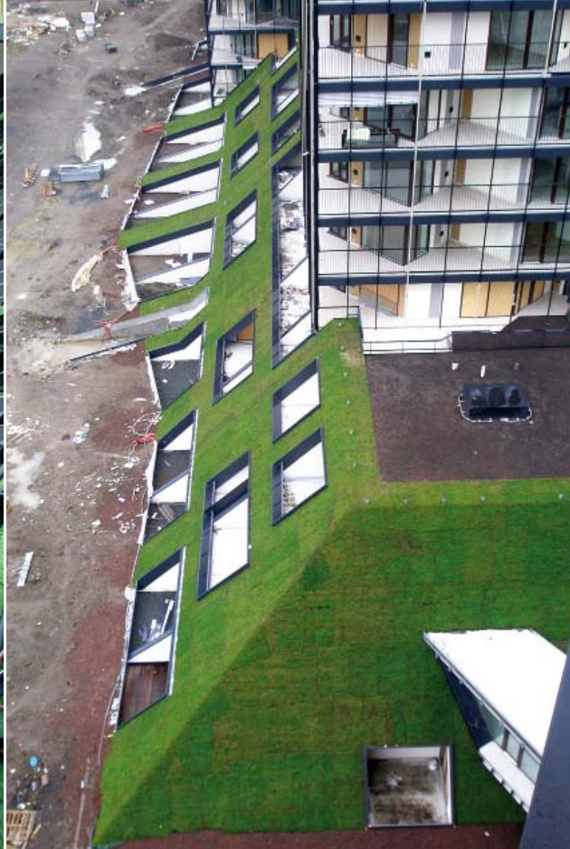
15| Pohled na šikmou střechu bytové části po pokládce substrátu a travních koberců
