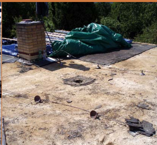
10, 11 | Odkryté hydroizolační souvrství z oxidovaných asfaltových pásů, pásy degradovány
