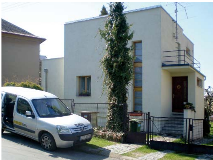
01 | Pohled na vilu před rekonstrukcí střechy
