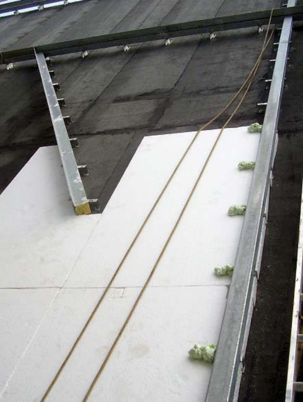
03| Pokládka tepelné izolace z EPS mezi ocelový stabilizační rošt
