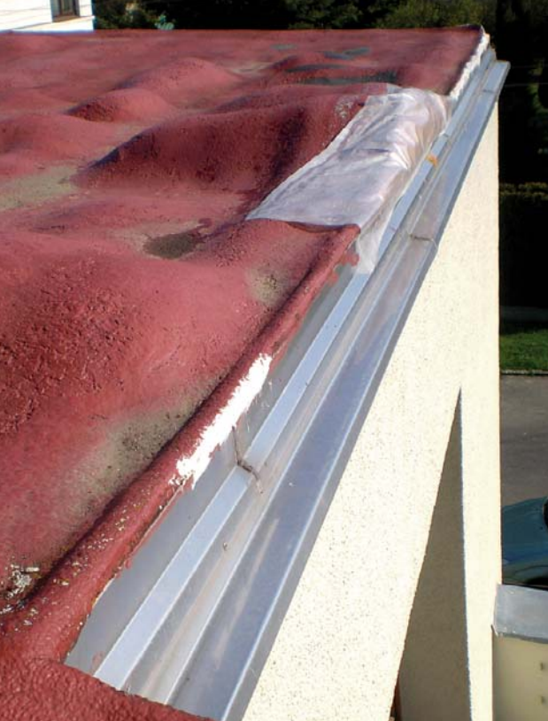
05| Okraj střechy ukončen závětrnou lištou. Klempířské konstrukce z ocelového pozinkovaného plechu z části opatřeny PUR nástřikem
