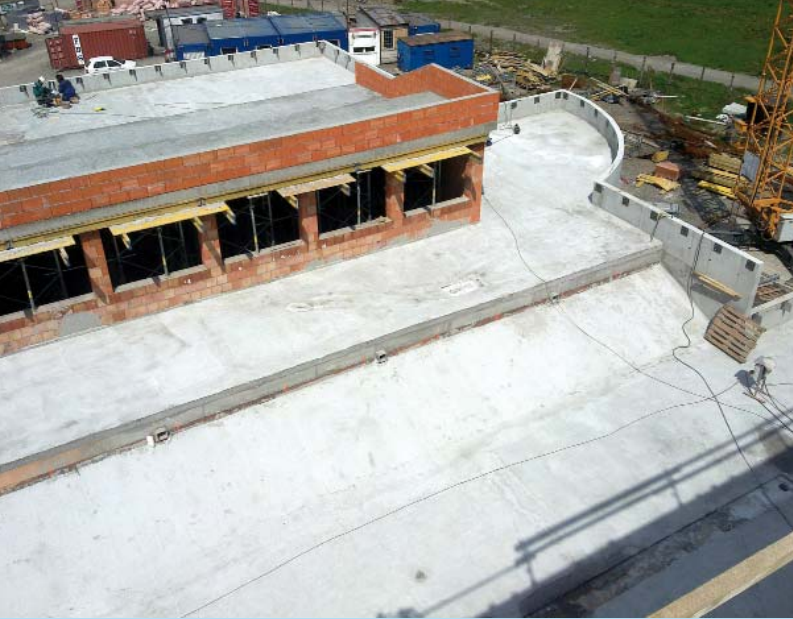
21 | Střecha nad bazénem před zahájením izolačních prací
