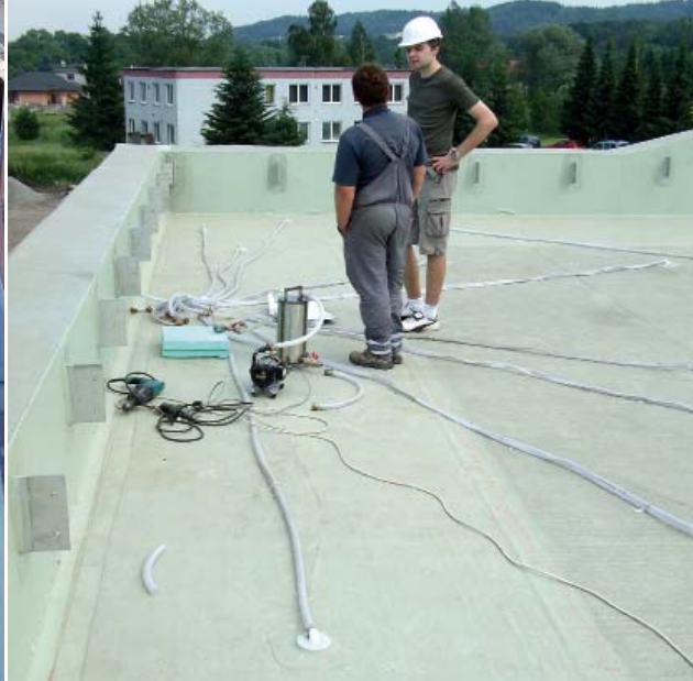
25 | Pracovník DEKPROJEKT provádí podtlakovou zkoušku těsnosti systému DUALDEK před provedením ochranných betonových konstrukcí. Ve 2 etapách bylo odzkoušeno 53 sektorů. Odhalené netěsnosti byly opraveny před zakrytím následnými vrstvami
