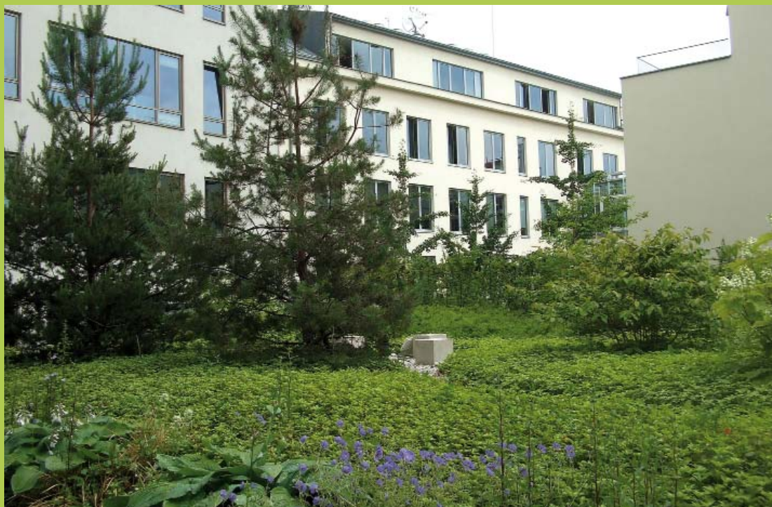
45| Stav v roce 2012. Vzrostlá vegetace na střeše nad 1. NP.
