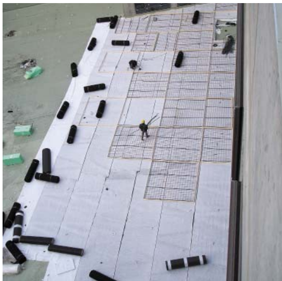
35| Pokládka separační textilie a nopové fólie na zkontrolovaný systém DUALDEK, pokládka ocelových sítí a vymezení polí latěmi před betonáží ochranné mazaniny.
