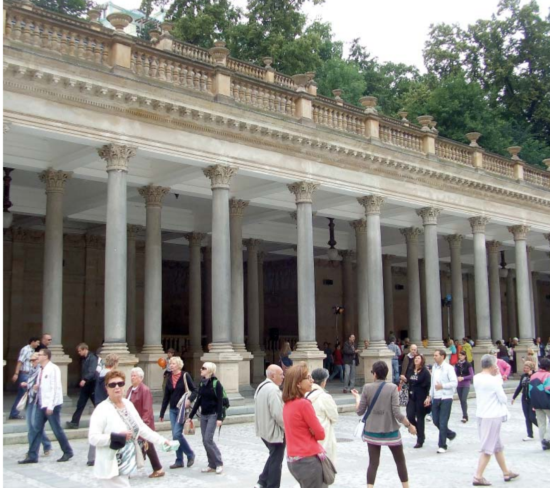
13| Stav terasy v létě 2012. Po prohlídce objektu lze konstatovat, že po 10 letech od dokončení rekonstrukce nedošlo k zatečení terasou do podstřeší. Nejsou zřejmé žádné projevy vlhkosti na kazetovém stropě.
