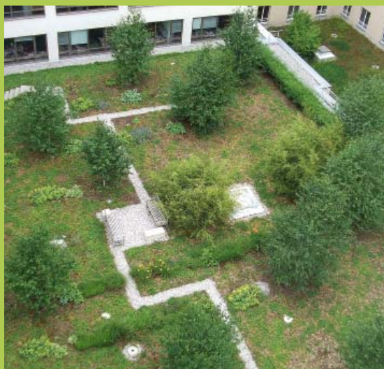
43| Stav v roce 2012. Pohled na vegetační střechu nad 1. NP.
