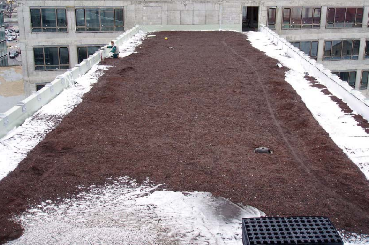
38 | Vegetační substrát dopravený na střechu pneumaticky a rozprostřený v ploše střechy nad 7. NP.
