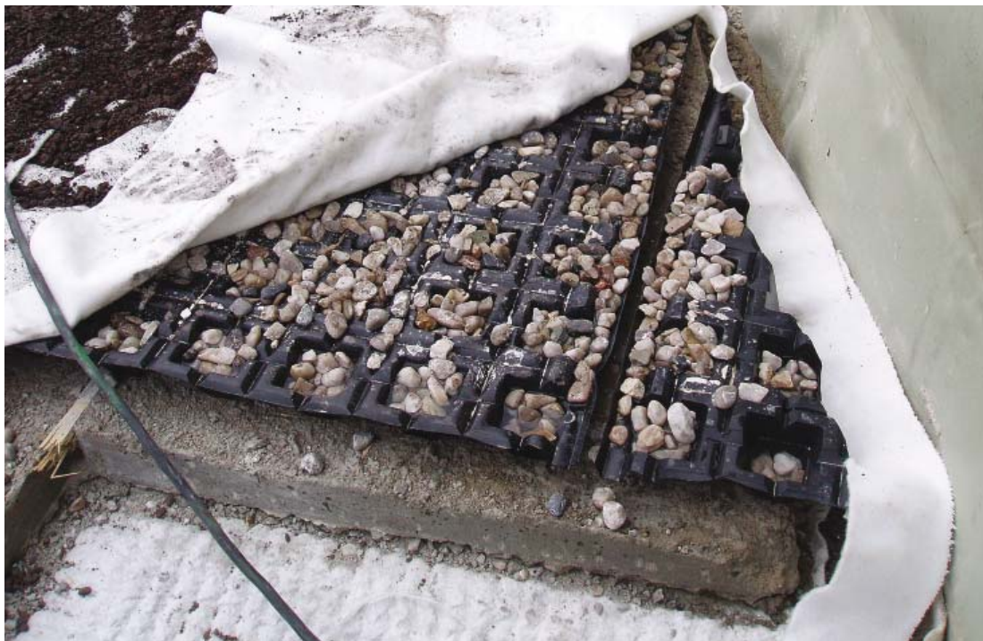
37| Drenážní vrstva z nopových desek vysypaných štěrčkem ukládaná na betonovou mazaninu.
