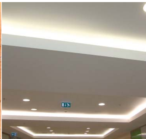
47| Stav v roce 2012. Pohled stropu pod vegetační střechou v komerčních prostorech bez jediné známky po zatékání.
