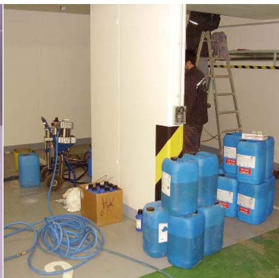
27| Injektáž – vlevo dvoupístová injektážní pumpa, vpravo barely s 2 složkami injektážní hmoty.
