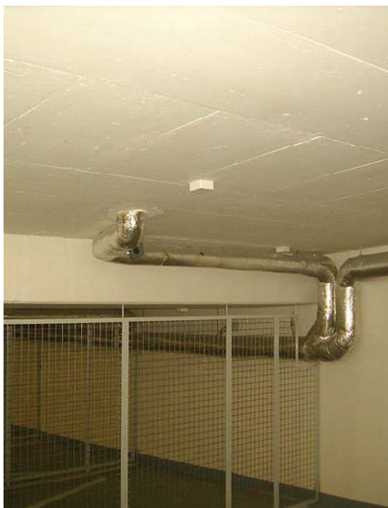
28| Stav v roce 2012 – pohled na střechu garáže po šesti letech užívání. Nedochozí k zatékání. Na stropě jsou stále přístupné kontrolní trubice hydroizolačního systému DUALDEK.
