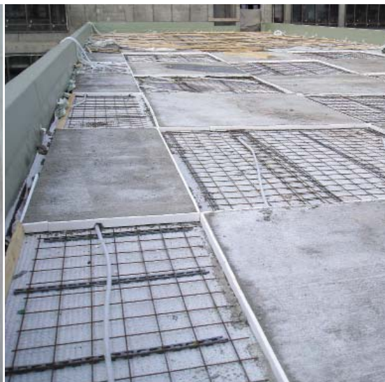
36| Šachovnicová betonáž ochranné mazaniny, pole cca 3×3m oddělena páskem z EPS pro umožnění dilatace vrstvy (latě po 1 osnově betonáže vyjmuty).
