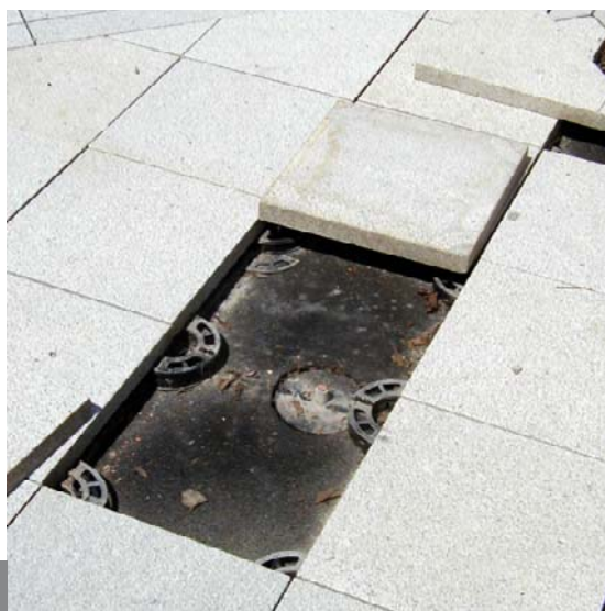
14| Stav terasy v létě 2012. Kontrolní trubice pod dlažbou na podložkách. I dnes by bylo možné ověřit těsnost systému vakuovou zkouškou, zatím k tomu však nebyl důvod.
