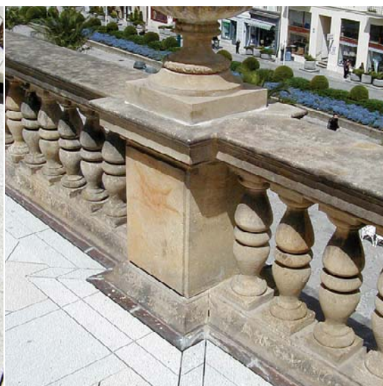
15| Stav terasy v létě 2012. Detail ukončení hydroizolace na balustrádě po 10 letech od opravy terasy.
