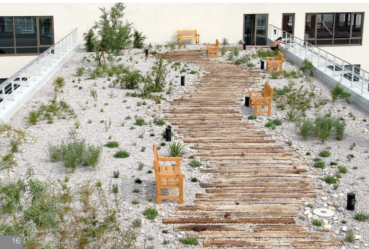
39 | Střešní zahrada nad 7. NP po dokončení stavby v roce 2007.
