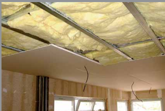
05| Pásy ze skleněných vláken jako tlumící výplň podhledu
