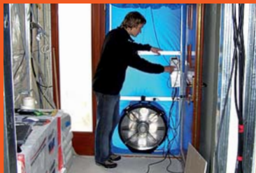
hledání netěsností anemometrem
