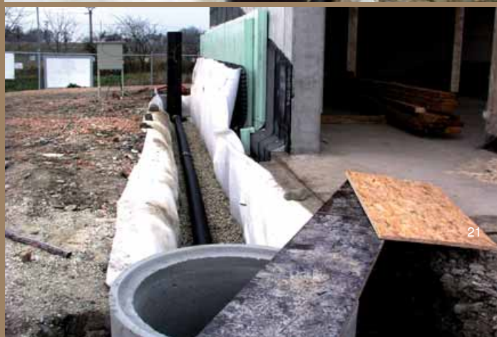
19 | Pohled na stěnu 20, 21 | Osazení šachtic, pokládka drenážního potrubí
