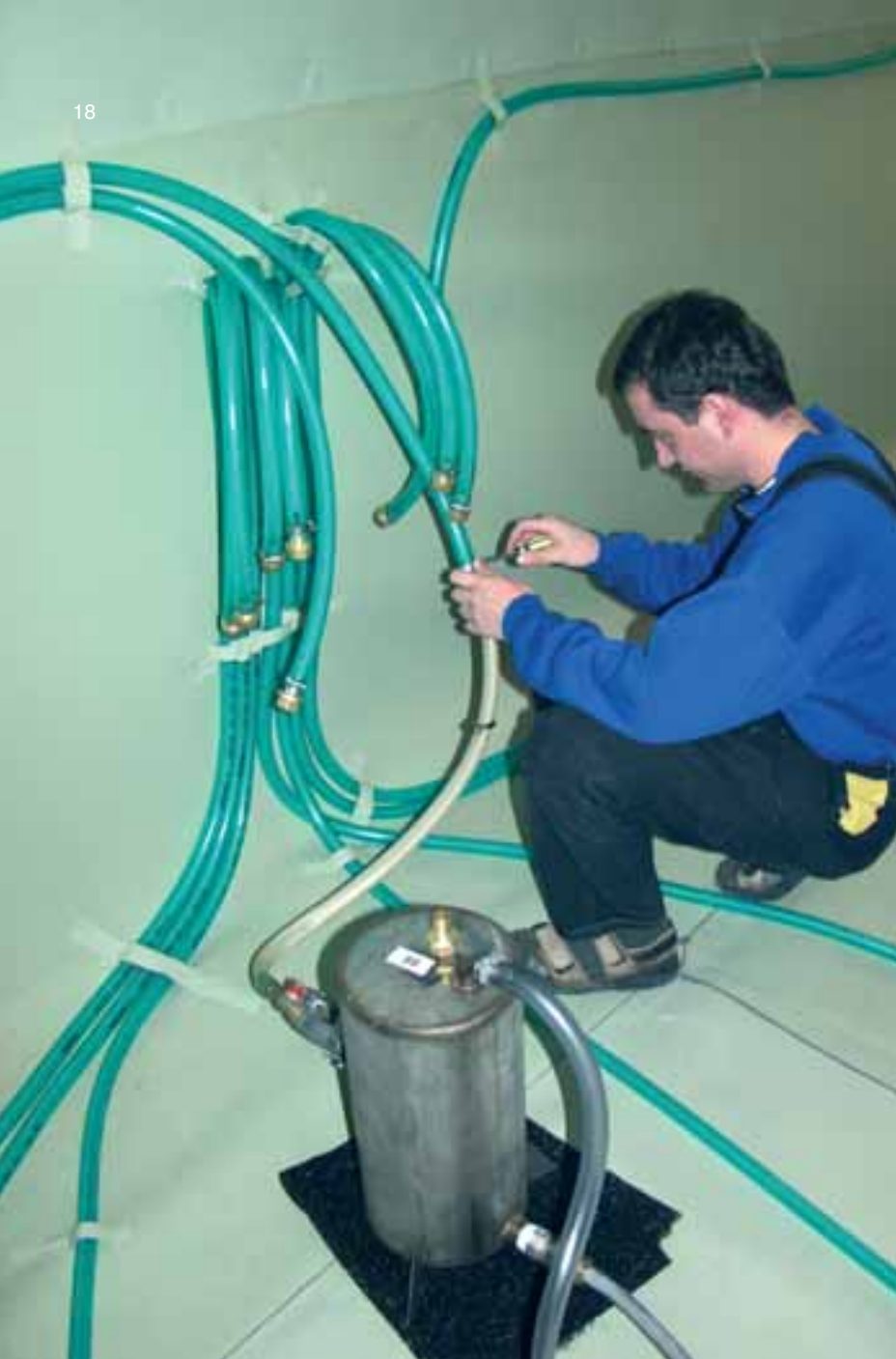
18 | Kontrola těsnosti systému vakuovou zkouškou po dokončení systému
