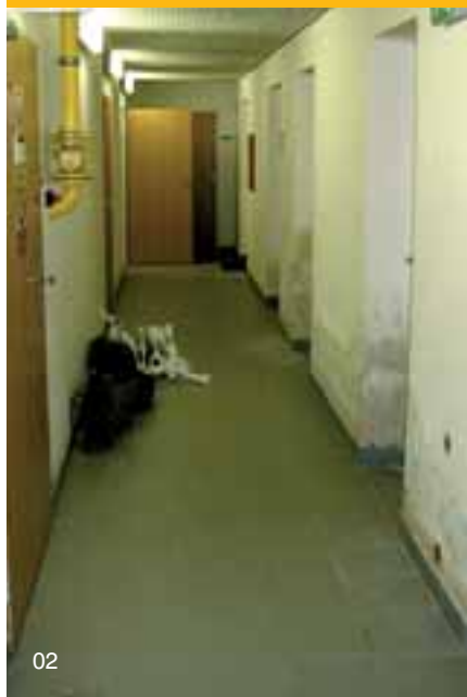
01 | Podsklepený objekt spojovacího krčku 02 | Vlhkostní poruchy v suterénu
