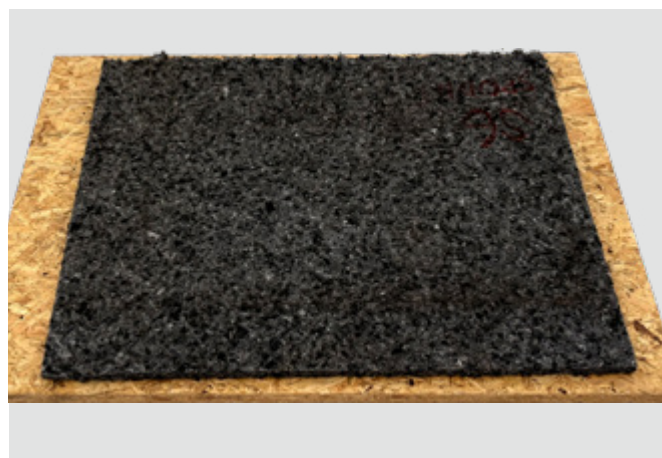
Stav hydroakumulačních desek po 3,5 letech od realizace vegetační skladby
