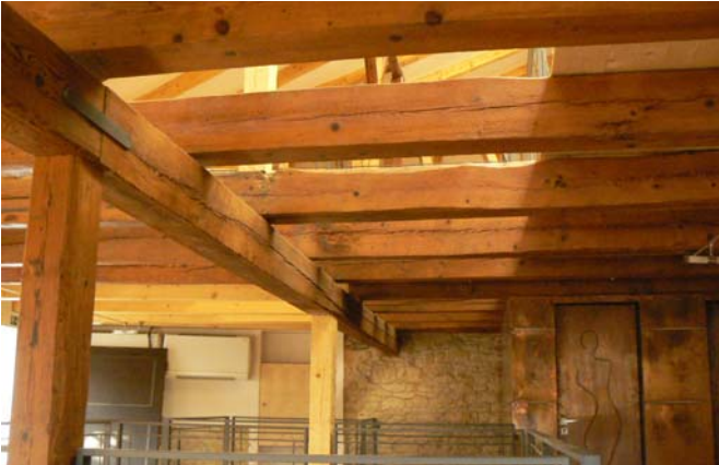
Realizace protipožárního nátěru FG700 FLAMGARD TRANSPARENT
