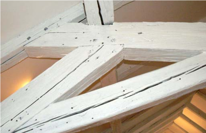
Realizace protipožárního nátěru FG500 FLAMGARD
