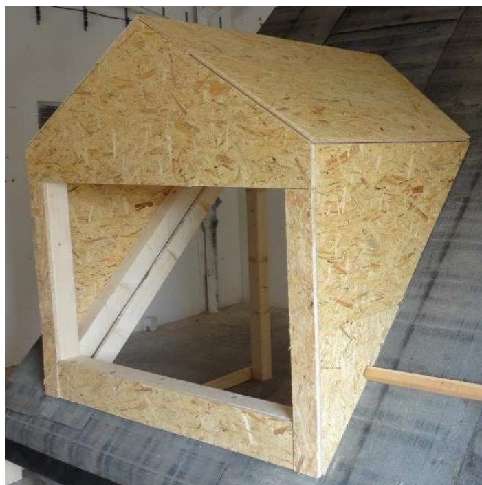
Obr. 29 - Dokončené opláštenie konštrukcie vikiera
