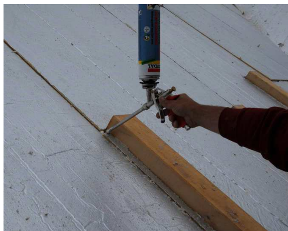
Obr. 11 - Vypenenie škáry medzi tepelnou izoláciou a podperou montážnou penou
