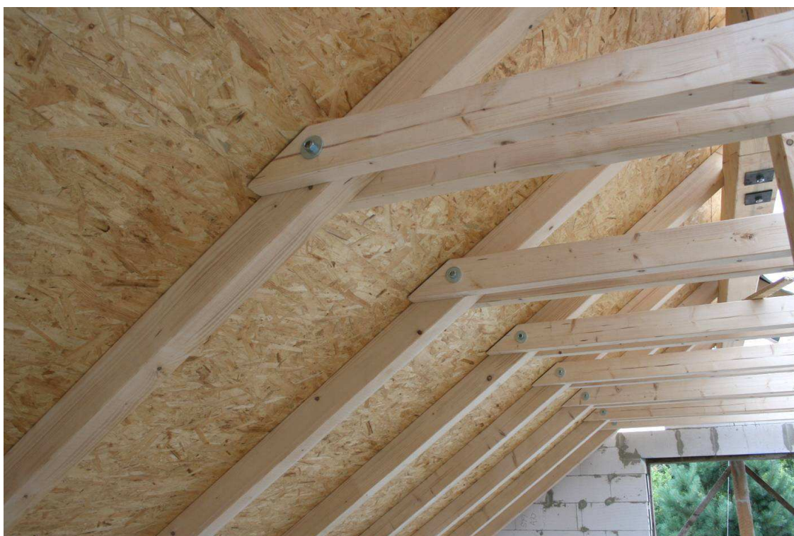
Obr. 3 - Montáž debnenia z OSB dosiek
