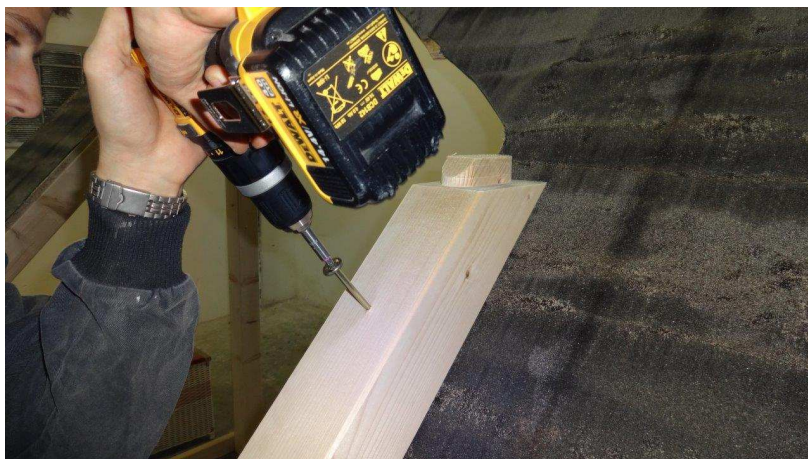
Obr. 26 - Upevnenie základných bočných dielov ku krokve
