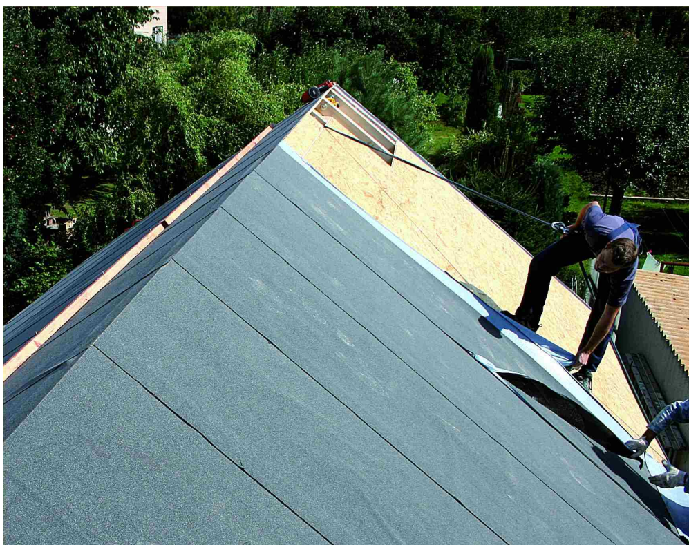
Obr. 6 - Pokládka parotesniacej a vzduchotesniacej vrstvy zo samolepiaceho asfaltovaného pásu TOPDEK AL BARRIER
