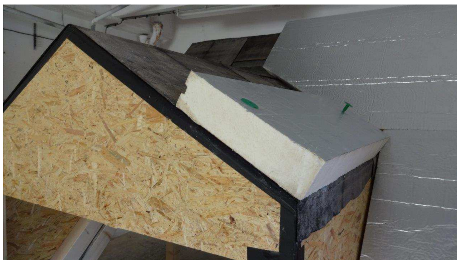
Obr. 31 - Pracovné upevnenie tepelnoizolačnej vrstvy pri odkvapovej hrane
