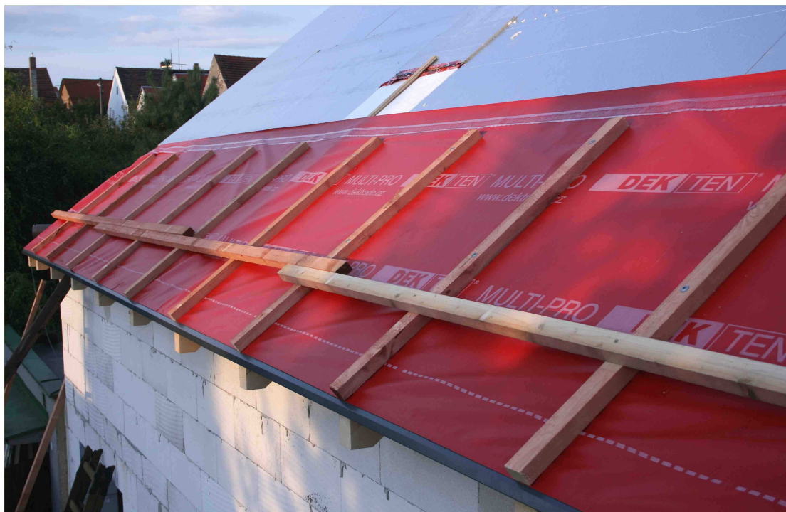
Obr. 12 - Pokládka poistnej hydroizolačnej vrstvy
