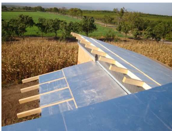
Obr. 10 - Pokládka tepelnoizolačných dosiek TOPDEK 022 PIR
