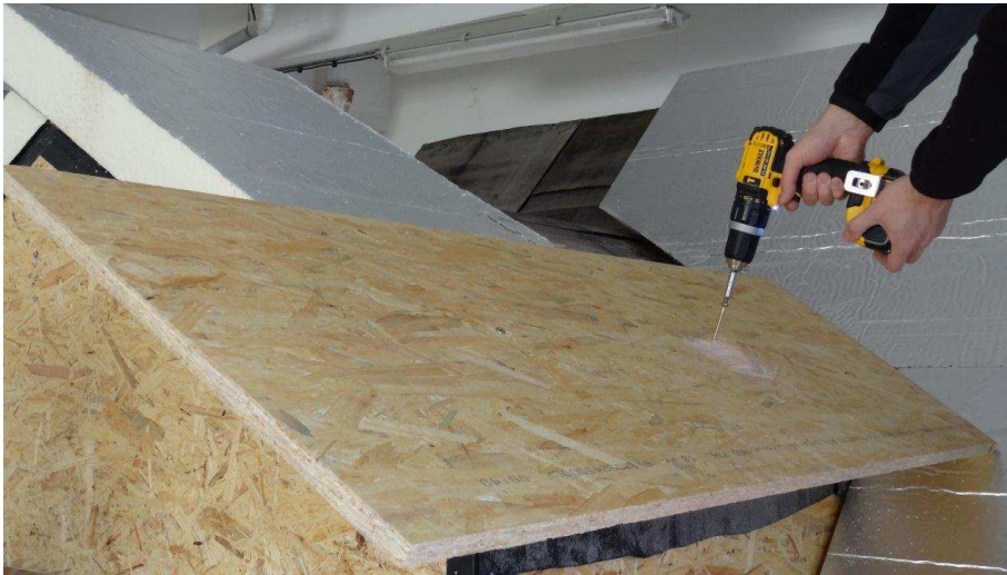
Obr. 34 - Upevnenie OSB dosky, vytvorenie presahu strechy vikiera
