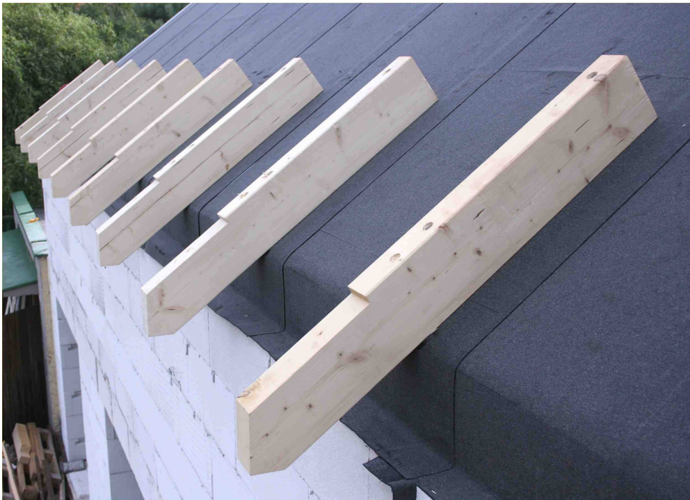
Obr. 7 - Upevnenie podpier presahu strechy pri odkvape
