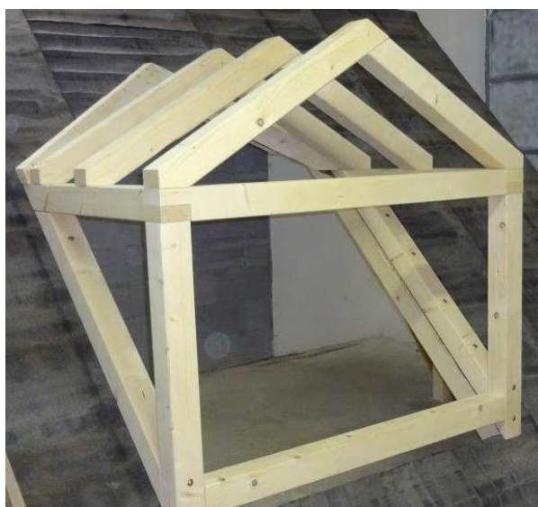
Obr. 27 - Postavená konštrukcia vikiera
