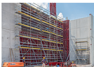
Pracovní lešení na staveništích
