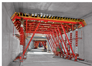
Bednění tunelů
