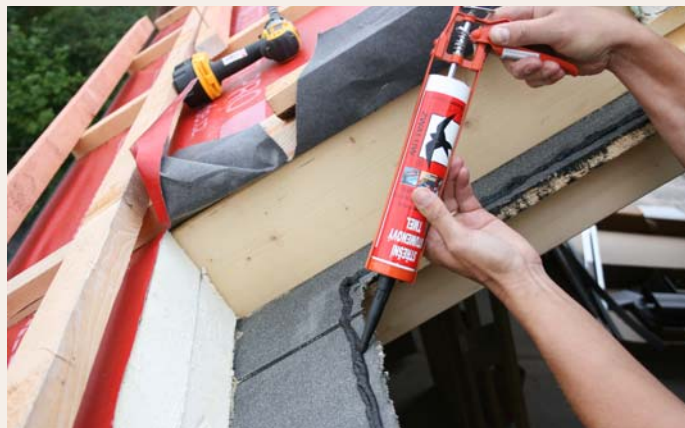
Vyplnění spár montážní pěnou
