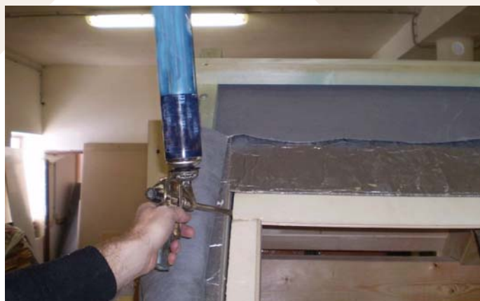
Napojení doplňkové hydroizolační vrstvy na rám okna
