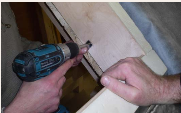
Ukončení pojistné hydroizolace na dílci
