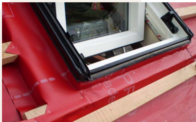
Napojení doplňkové hydroizolační vrstvy na rám okna
