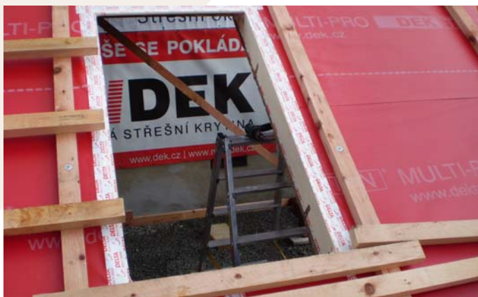
Ukončení pojistné hydroizolace na dílci
