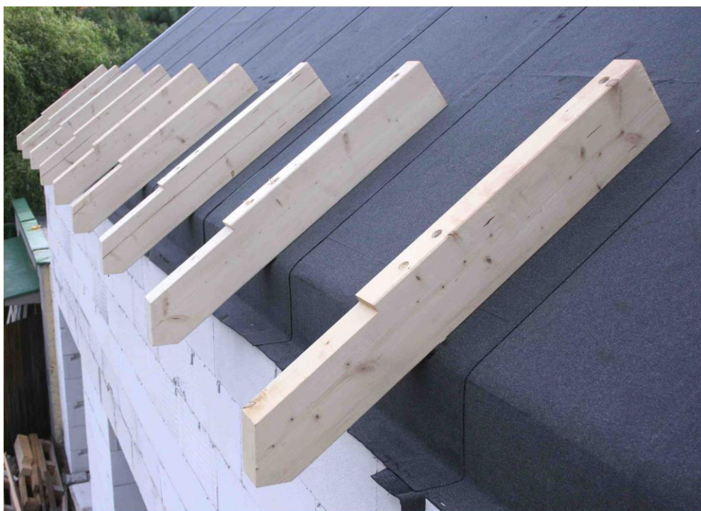
Obr 7. - Upevnění podpor přesahu střechy u okapu
