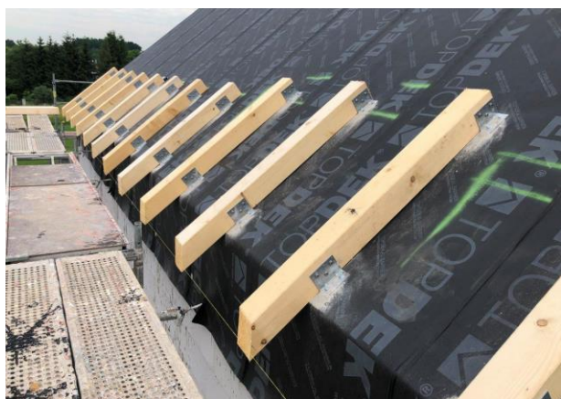
Obr. 37. Systém okapových podpor
