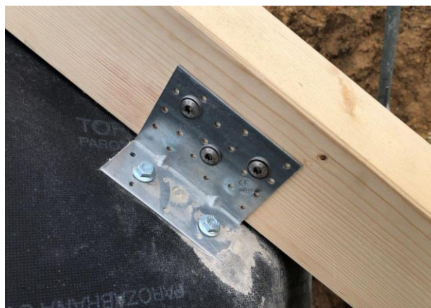
Obr. 38. Připevnění okapové podpory pomocí úhelníků
