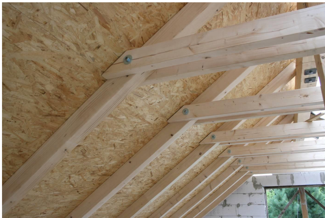
Obr 3. - Montáž bednění z desek OSB
