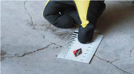
3. Přeměří se šířka spar, všechny nad 2 mm je potřeba vyspravit.
