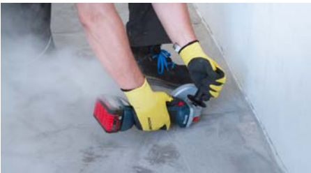
4. Spára se po celé délce prořízne.
