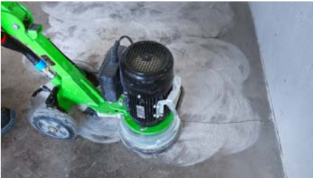
1. Povrch se celoplošně přebrousí bruskou s diamantovým kotoučem, aby bylo možné lépe identifikovat trhliny v ploše.
