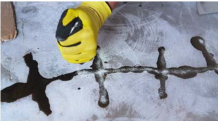
9. Provede se prosyp zásypovým pískem hrubým.
