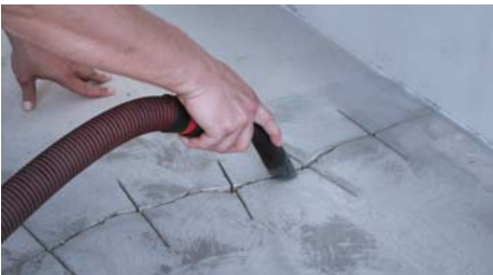
6. Důkladně se odstraní prach.
