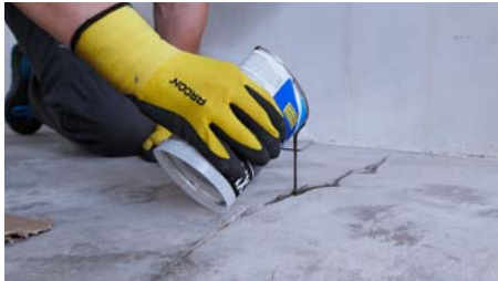
6. Trhlina se zalije promíchanou a natuženou hmotou HX110.
