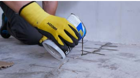
7. Trhlina se zalije promíchanou a natuženou hmotou HX100.
