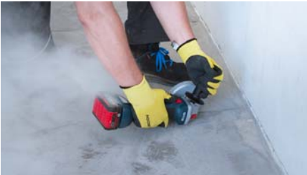
4. Spára se po celé délce prořízne.
