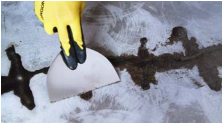
11. Na závěr se provede uhlazení, případně se odstraní přebytek záливkové hmoty. Před ošetřením nátěrem je vhodné plochu přebrousit.
