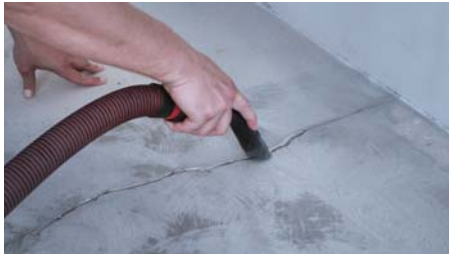
5. Důkladně se odstraní prach.
