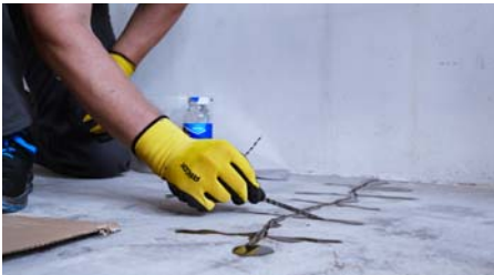
8. Do drážek se vloží pevnostní spony HX010.
