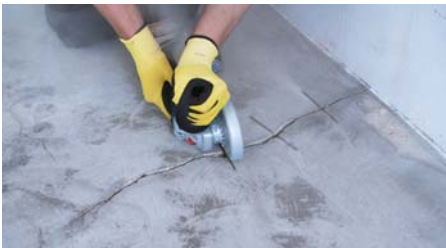
5. Vždy kolmo na trhlinu se v daném místě provede proříznutí příčných drážek, vzdálenost dle zátěže podlahy 5–20 cm.
