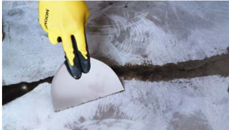
8. Na závěr se provede uhlazení, případně se odstraní přebytek záливkové hmoty. Před ošetřením nátěrem je vhodné plochu přebrousit.
