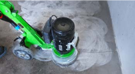
1. Povrch se celoplošně přebrousí bruskou s diamantovým kotoučem, aby bylo možné lépe identifikovat trhliny v ploše.
