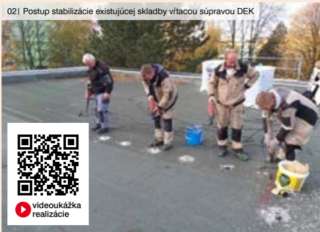
02 | Postup stabilizácie existujúcej skladby vrtacou súpravou DEK
