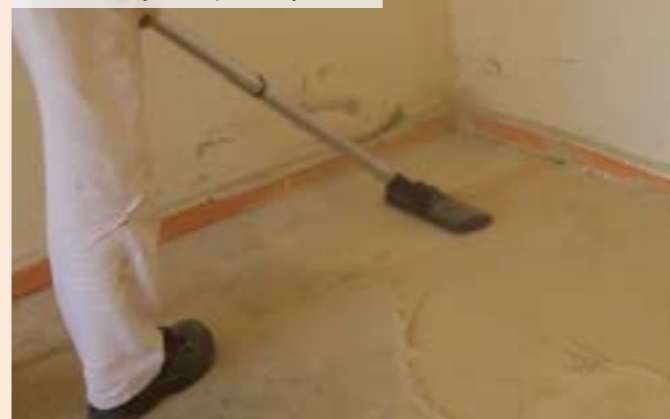
03 | Dôkladné vyčistenie povrchu vysávačom
