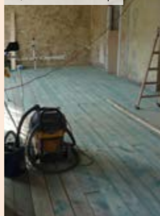
04 | Montáž nového záklopu
