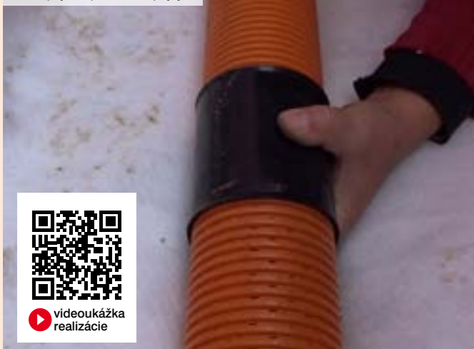
09 | Pokládka drenážnych rúr a ich spájanie pomocou spojky
