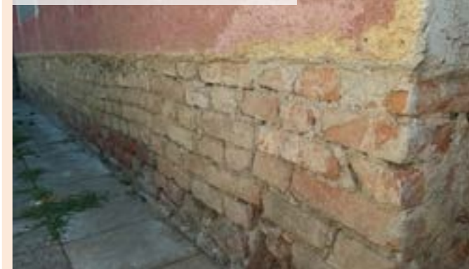
04 | Podrezanie muriva, vloženie prírezu asfaltovaného pásu, napr. GLASTEK 40 SPECIAL MINERAL
