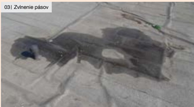
03 | Zvlnenie pásov
