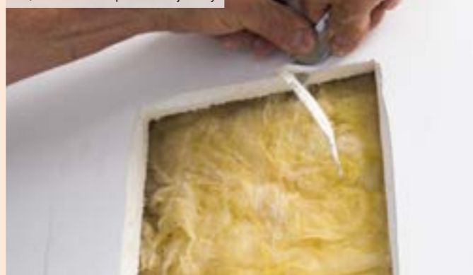
05 | Zrezanie hrán poškodenej dosky
