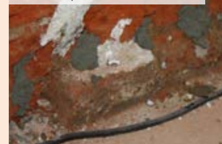
06 | Utesnenie otvoru po injektáži napríklad zmesou vodotesnej prísady Sika 1 s pieskom a cementom v pomere 3:1
