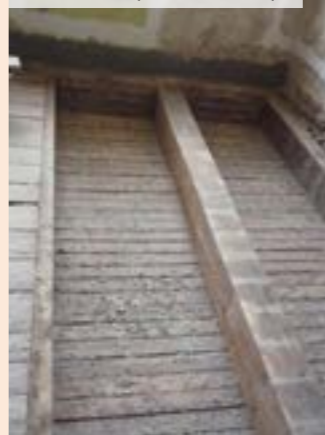
03 | Demontáž pôvodného záklopu
