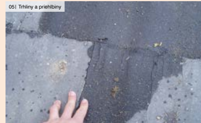
05 | Príklad vyrovnania lokálnej nerovnosti
