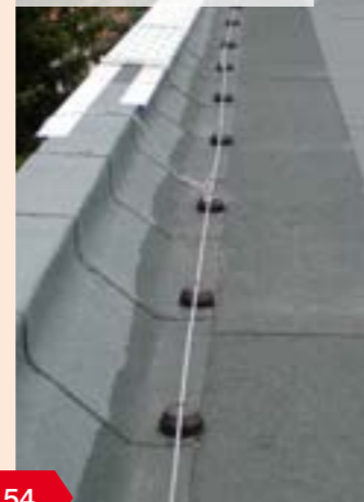
03 | Realizácia opravy povrchu atiky a príľahlých plôch
