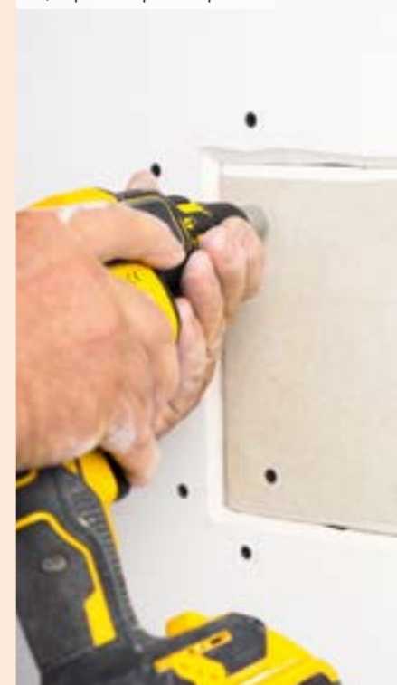
07 | Pripevnenie prírezu k profilom
