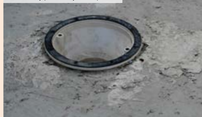
02 | Nutnosť vyspravenia a vyrovnanie podkladu
