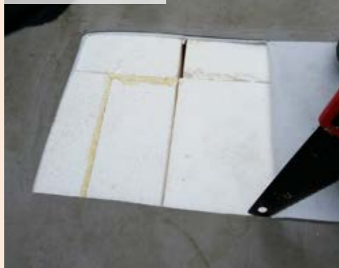
02 | Odhrnutie kameniva a realizácia sondy do skladby strešného plášťa
