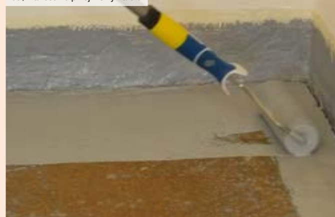
05 | Naniesenie prvej vrstvy náteru
