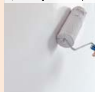
04 | Maľovanie vrchným náterom s prísadou FungiSAN bezchlórový
