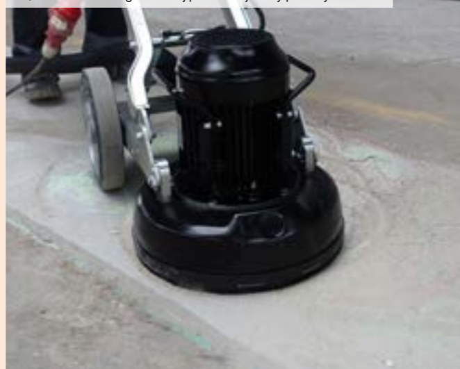
02 | Odstránenie zdegradovanej povrchovej vrstvy podlahy brúsením
