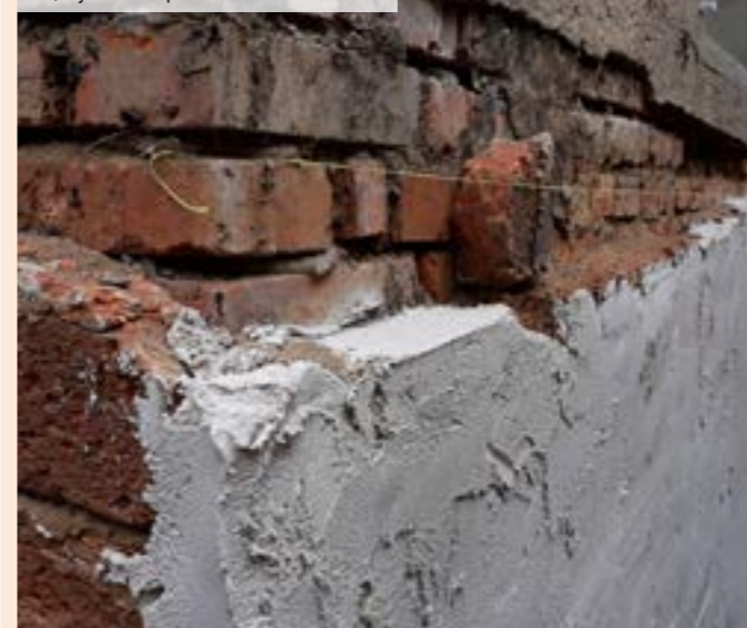
04 | Vyrovnanie povrchu muriva omietkou
