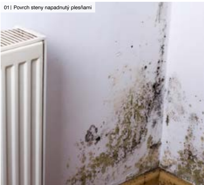
01 | Povrch steny napadnutý plesňami
