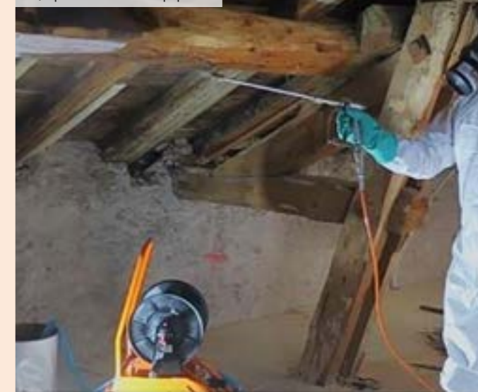
03 | Aplikácia sanačného prípravku
