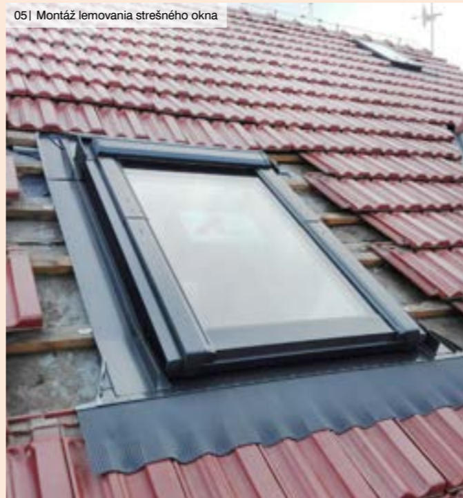
05 | Montáž lemovania strešného okna
