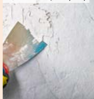
03 | Odstránenie napadnutej maľby
