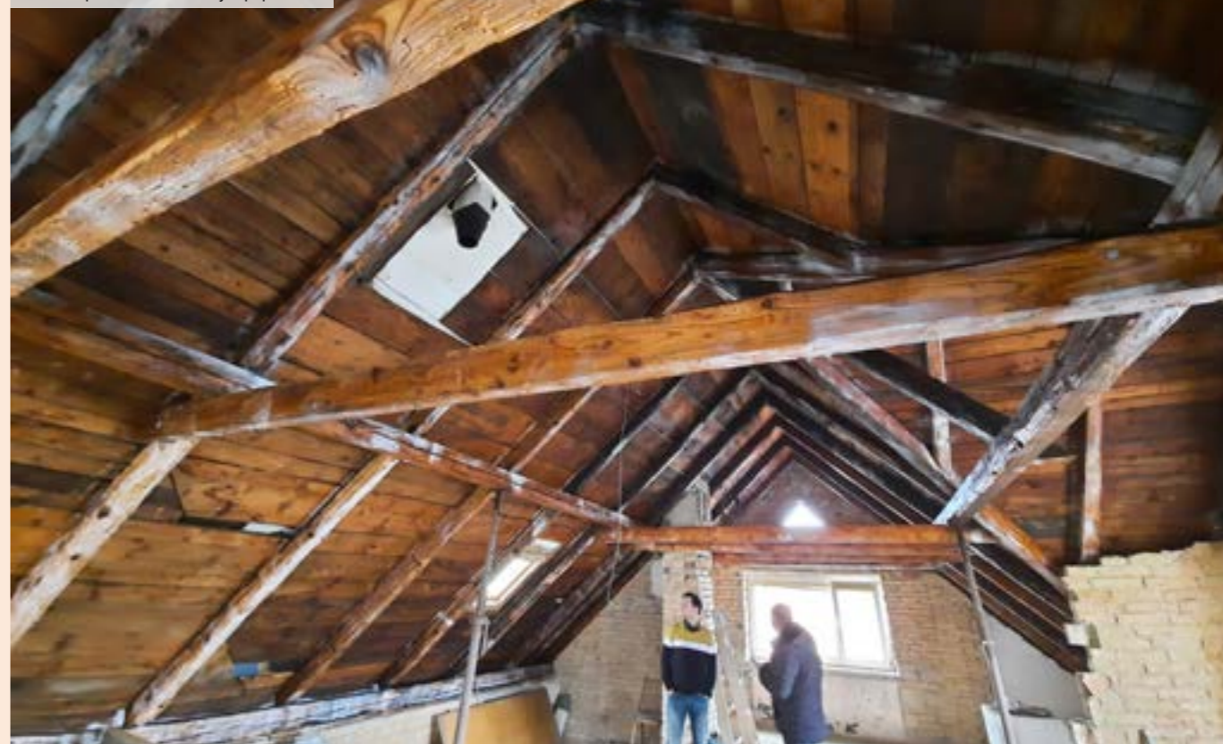
04 | Krov po ošetrení biocídnym prípravkom
