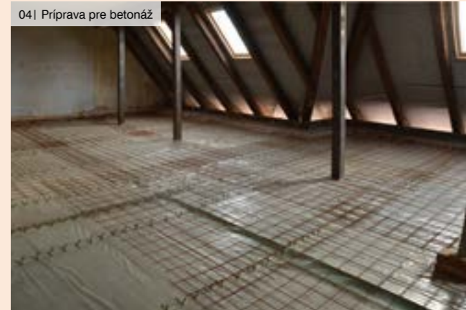
04 | Príprava pre betonáž
