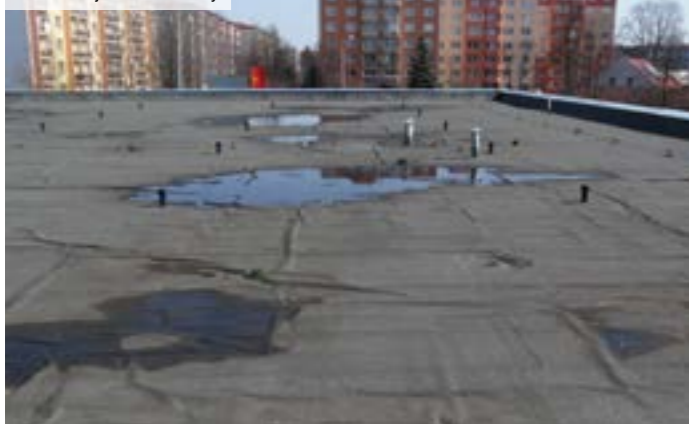
01 | Existujúci stav strechy
