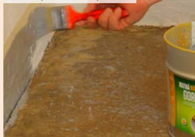
04 | Naniesenie penetračného náteru na podlahu a sokel
