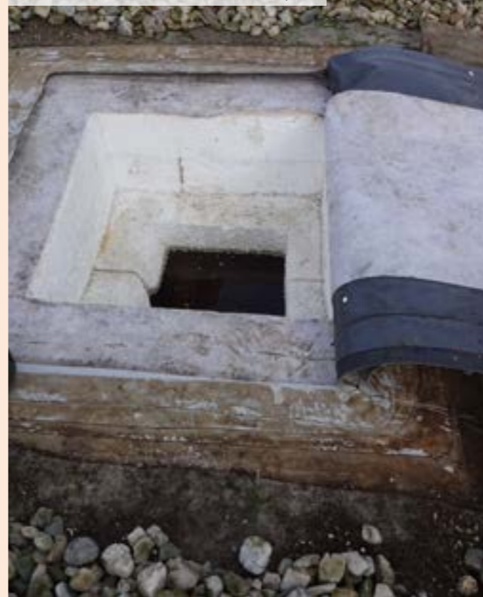
03 | Pohľad na zrealizovanú sondu do strešného plášťa
