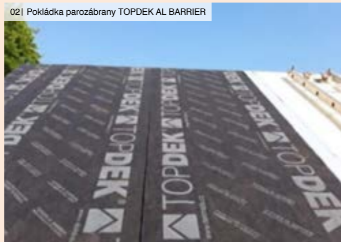
02| Pokládka parozábrany TOPDEK AL BARRIER
