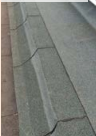
04 | Nový povrch na zvislej ploche svetlíka a príľahlých plochách
