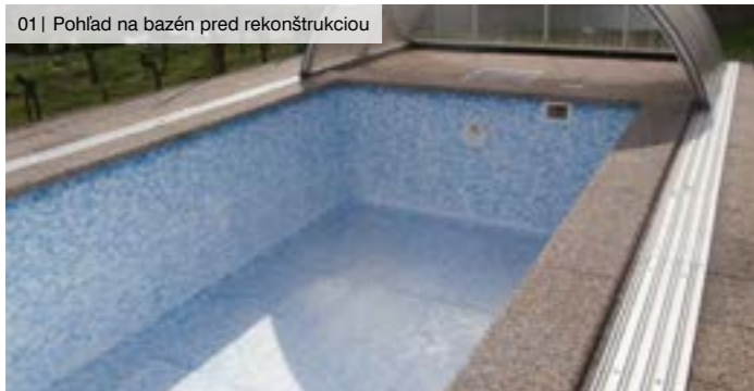
01 | Pohľad na bazén pred rekonštrukciou
