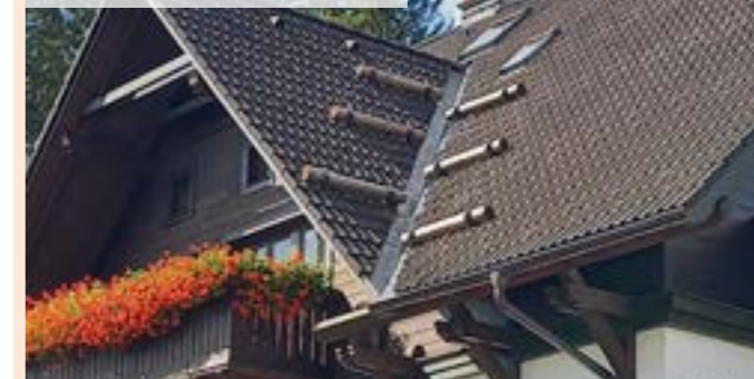
04 | Zadržanie snehu pomocou guľatiny, riešenie vhodné pre horské lokality
