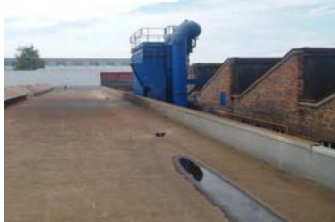
01 | Pohľad na strechu pred rekonštrukciou
