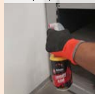
02 | Aplikácia prípravku FungiSPRAY bezchlórový na napadnuté miesta
