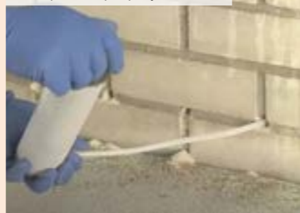
07 | Injektážny prípravok vytvorí v murive hydrofóbnu zábranu
