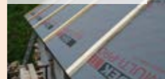
02 | Pokládka prvého pásu PHV, zašifovaná kontratami
