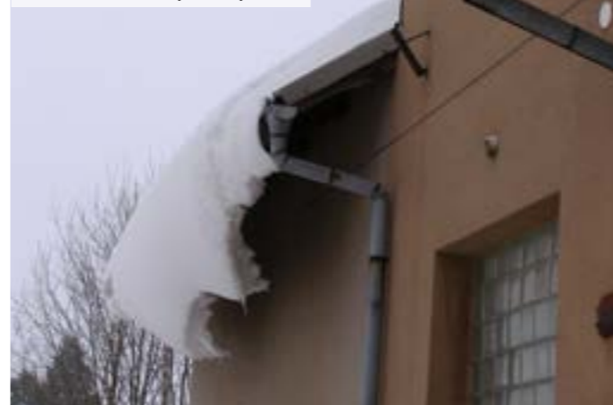
01 | Nekontrolovateľný pohyb snehu na streche bez snehových zachytávačov
