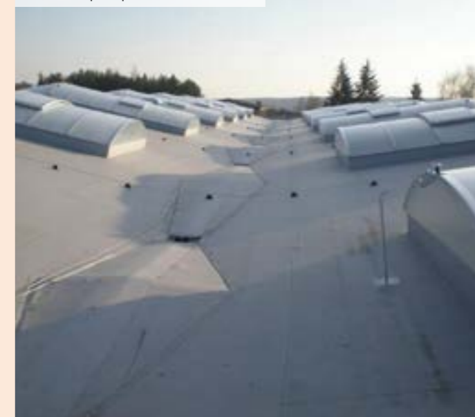
05 | Strecha po doplnení rozháňacích klinov
