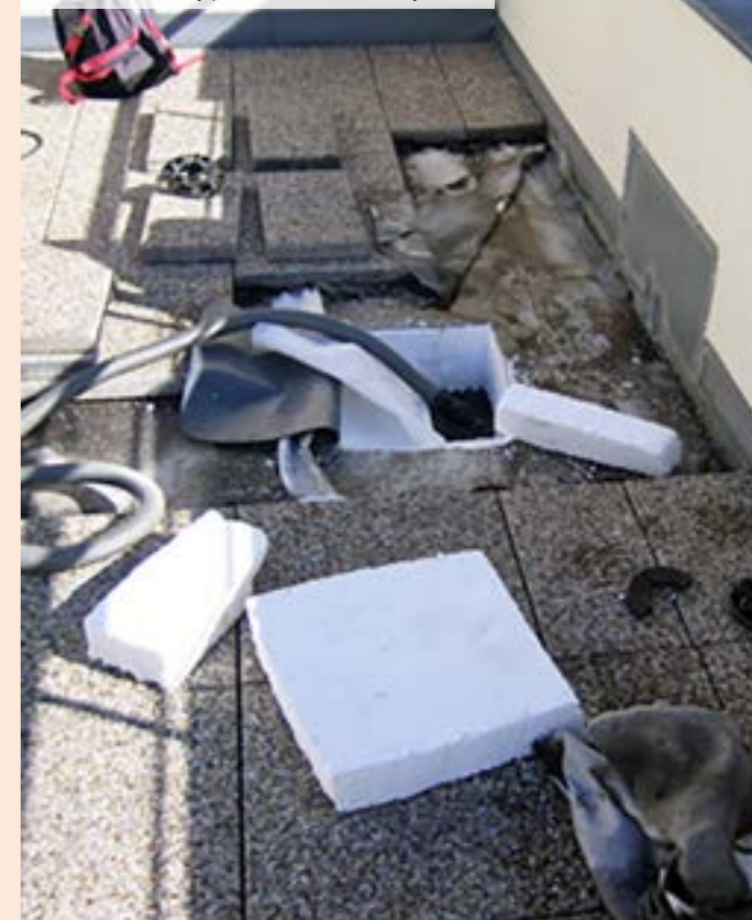
04 | Odsávanie vody pomocou stavebného vysávača
