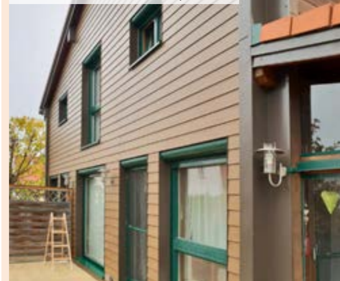
04| Dokončená fasáda s vláknocementovým obkladom
