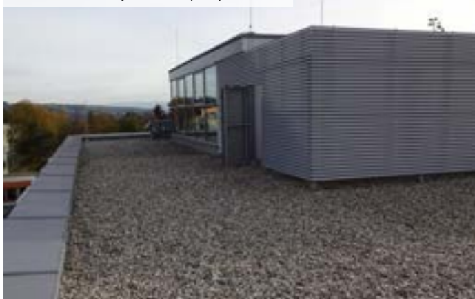
01 | Pohľad na existujúcu strechu pred prieskumom
