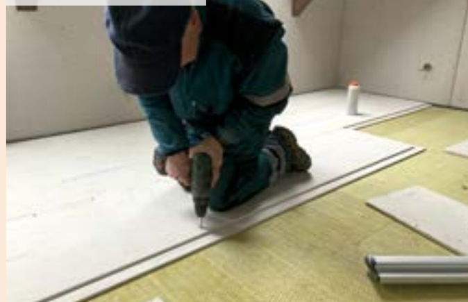
08 | Pokládka podlahových dosiek
