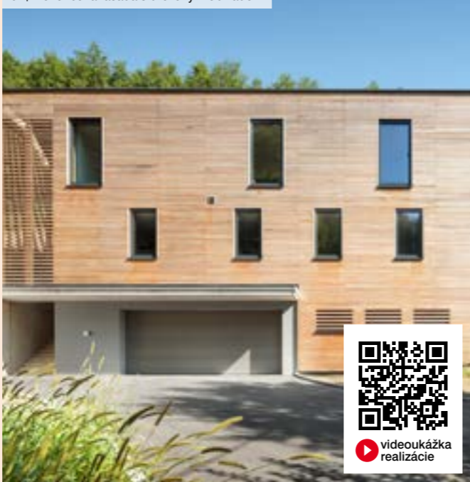
02| Dokončená fasáda s dreveným obkladom
