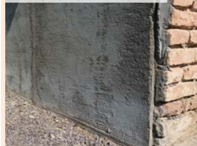
05 | Realizácia jadrovej omietky pre dosiahnutia rovinnosti podkladu
