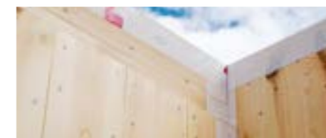
Polodrážka v paneli pre osadenie stropného prievlaku
