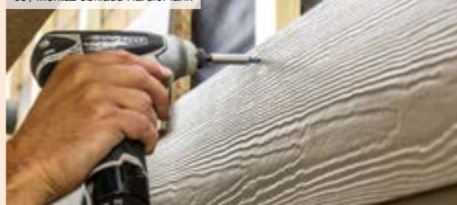
03| Montáž obkladu HardiePlank
