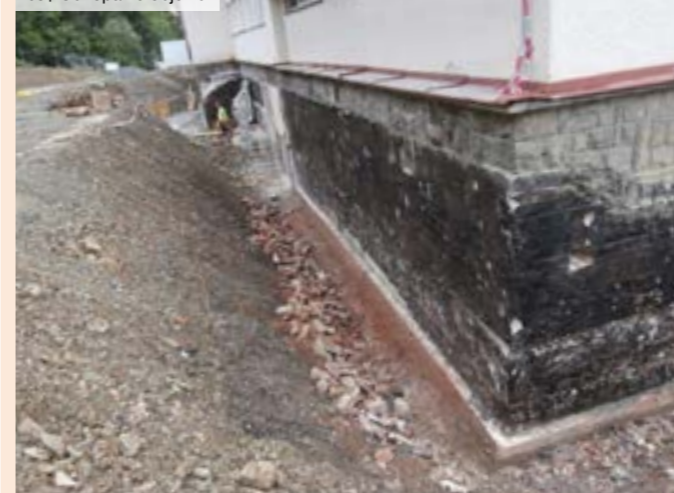
04 | Vyrovnanie povrchu muriva omietkou
