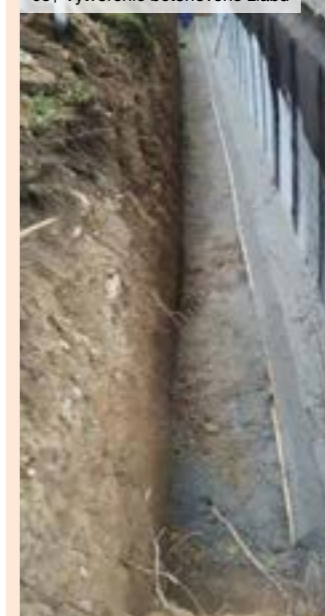
05 | Vytvorenie betónového žlabu
