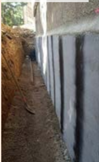
08 | Natavenie asfaltovaného pásu Elastek 40 Special Mineral
