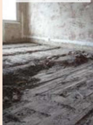
02 | Odstránenie pôvodného zásypu
