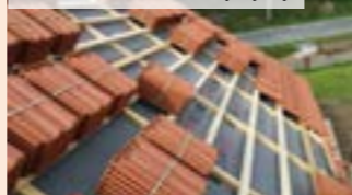
05 | Pokládka keramickej krytiny
