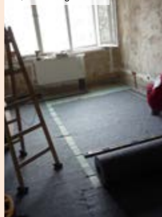
05 | Pokládka geotextílie
