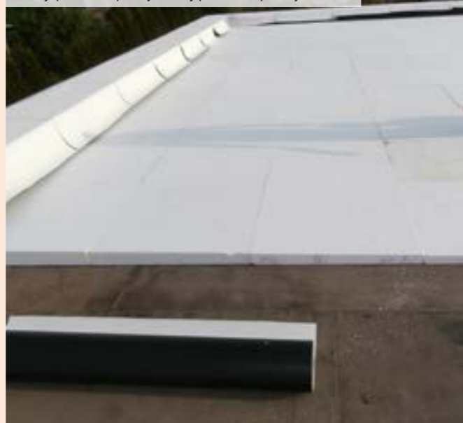
02 | Vyspádovanie plochy strechy pomocou spádových klinov
