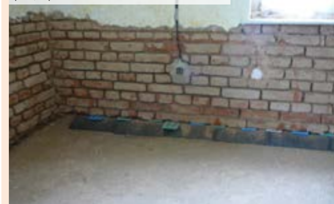
04 | Podrezanie muriva, vloženie prírezu asfaltovaného pásu, napr. GLASTEK 40 SPECIAL MINERAL
