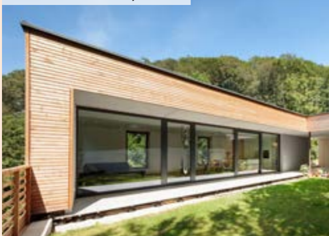
01| Dokončená fasáda s dreveným obkladom
