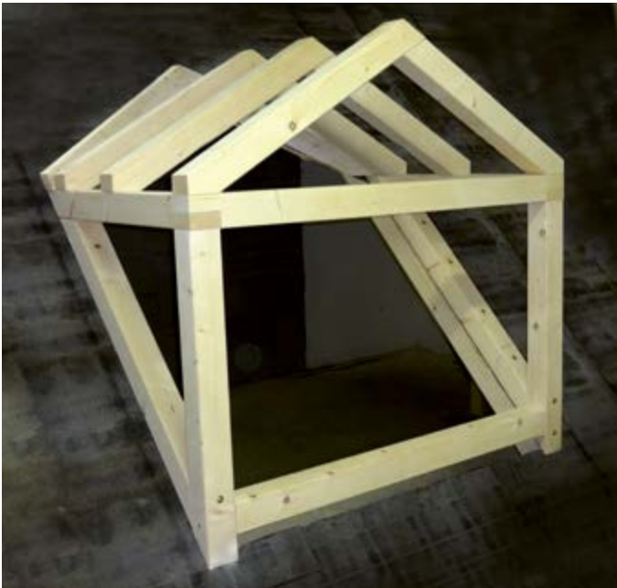
Obr. 2.5.2 – 1 Postavená konštrukcia sedlového vikiera
