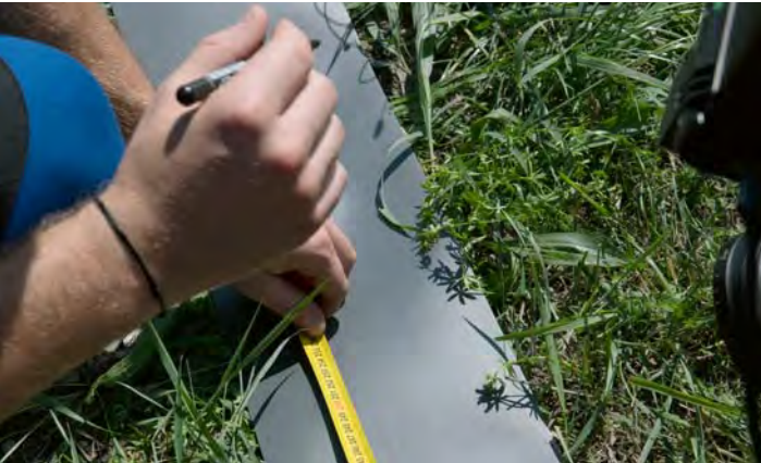
1 Stínicí plotovou výplň si rozvineme a ustříháme na šířku pletiva.
