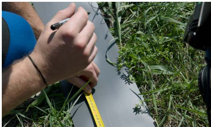
1 Stínicí plotovou výplň si rozvineme a ustříheme na šířku pletiva.
