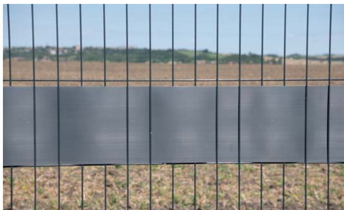
3 Vypleteme od první řady po celé délce plotu, ideálně po dvou okách.
