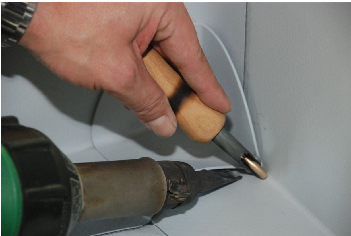
Obrázek 15.: Postup opracování hydroizolace v koutu
