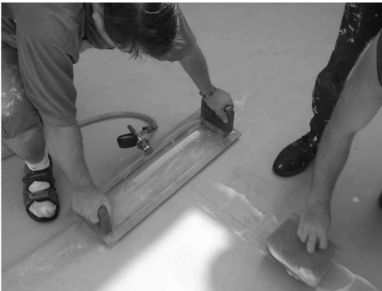
Obrázek 25.: Zkoušení těsnosti spojů vakuovou zkouškou
