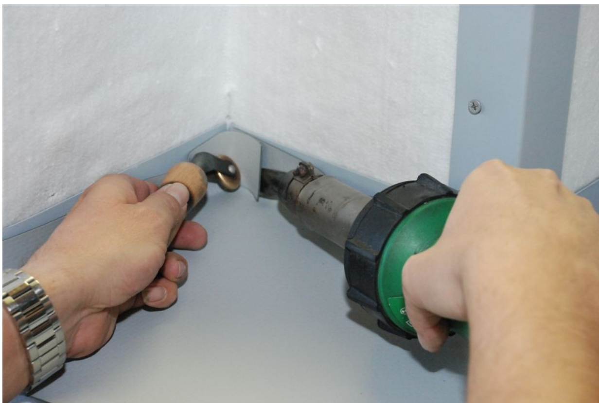
Obrázek 9.: Postup opracování hydroizolace v koutu
