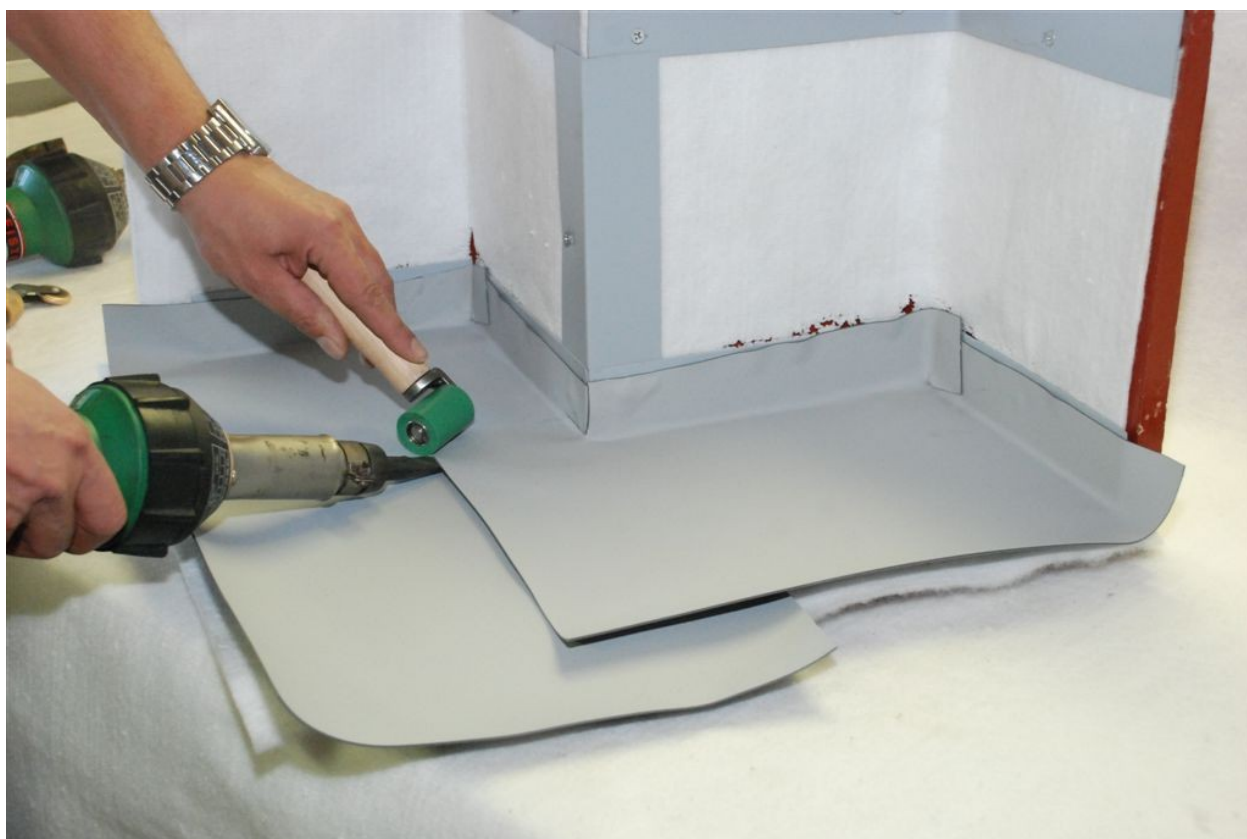
Obrázek 10.: Postup opracování hydroizolace na rohu
