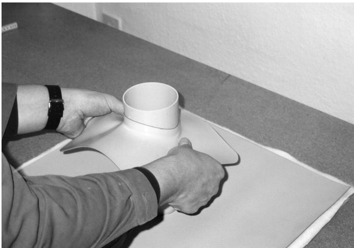
Obrázek 20.: Opracování prostupu - nasazení manžety na prostup
