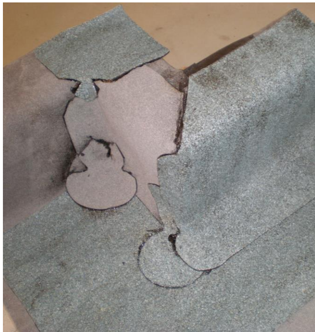
Obrázek /21/ Natavení upraveného asfaltového pásu s posypem přivedeného po atice k detailu vnějšího rohu
