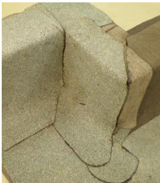
Obrázek /11/ Natavení koutové tvarovky 4b upravené zprava na tvar rohové tvarovky 2b a natavení koutové tvarovky 4a, obě s posypem
