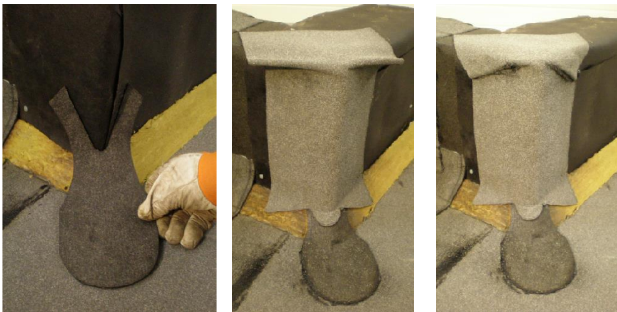
Obrázek /7/ Natavení univerzální tvarovky 1 a 2
