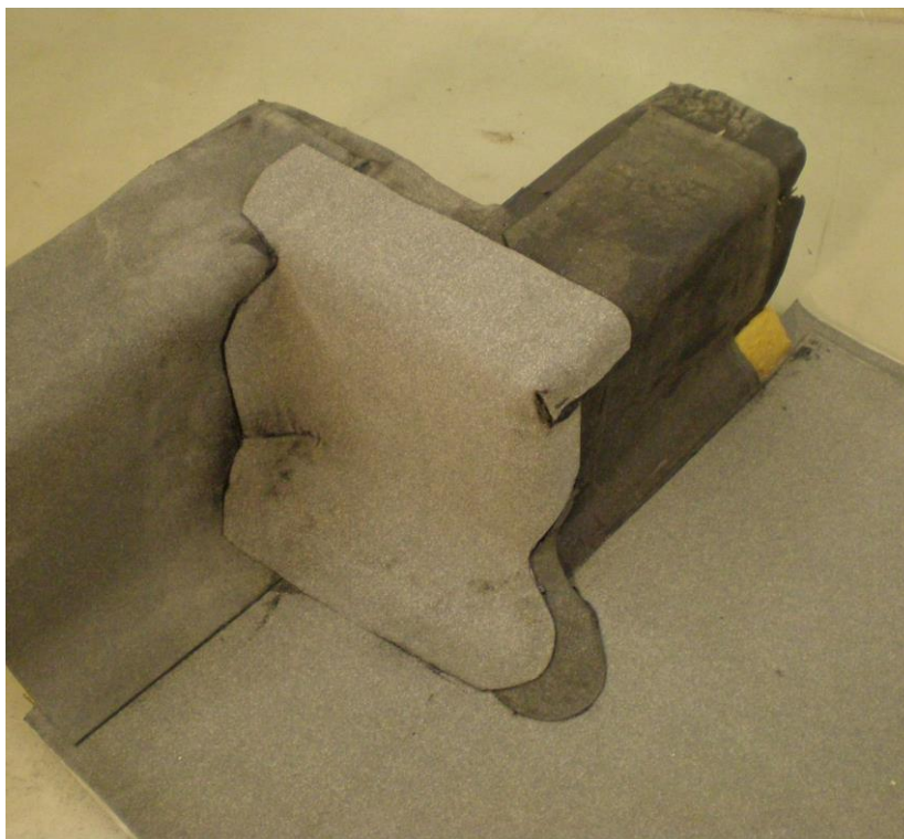
Obrázek /17/ Natavení tvarovaného asfaltového pásu na atice mezi vnitřním koutem a vnějším rohem
