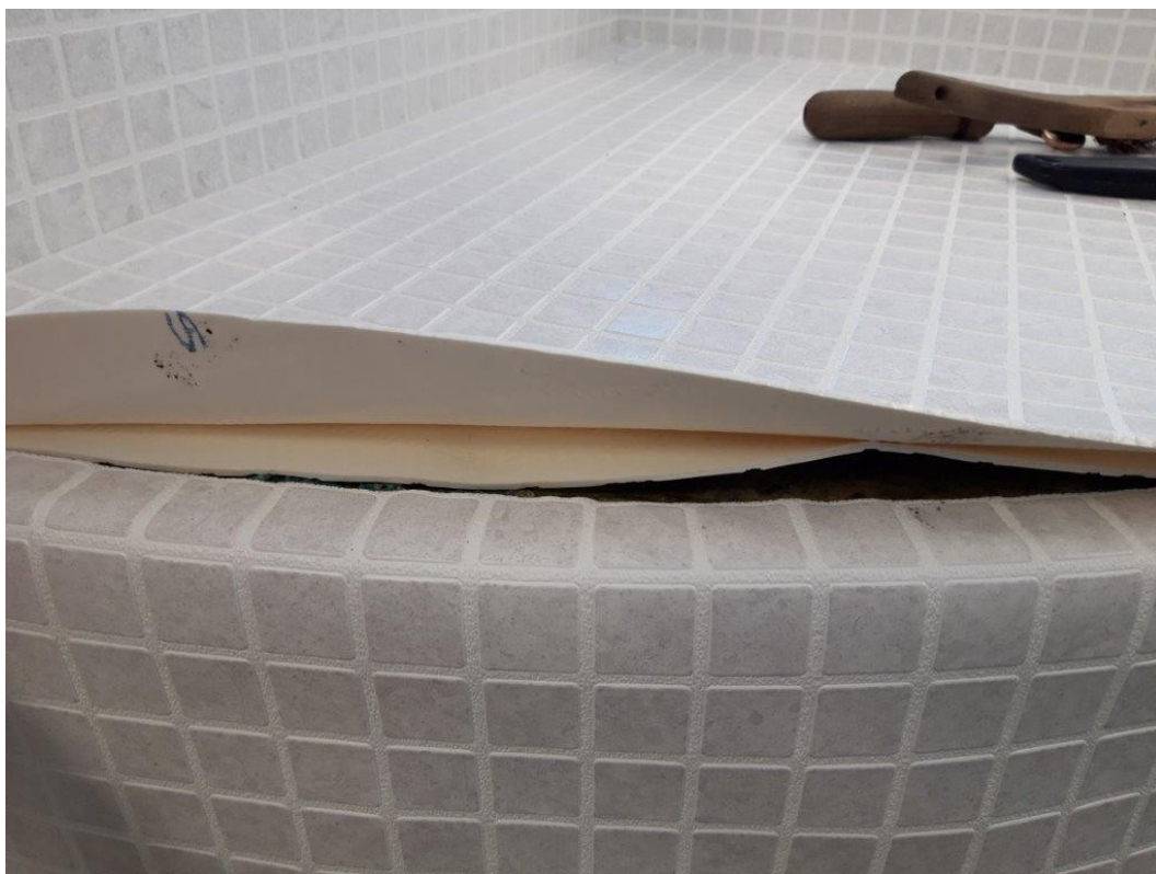
Foto 15. Pokládka fólie na stupeň s vypodložením přířezem fólie
