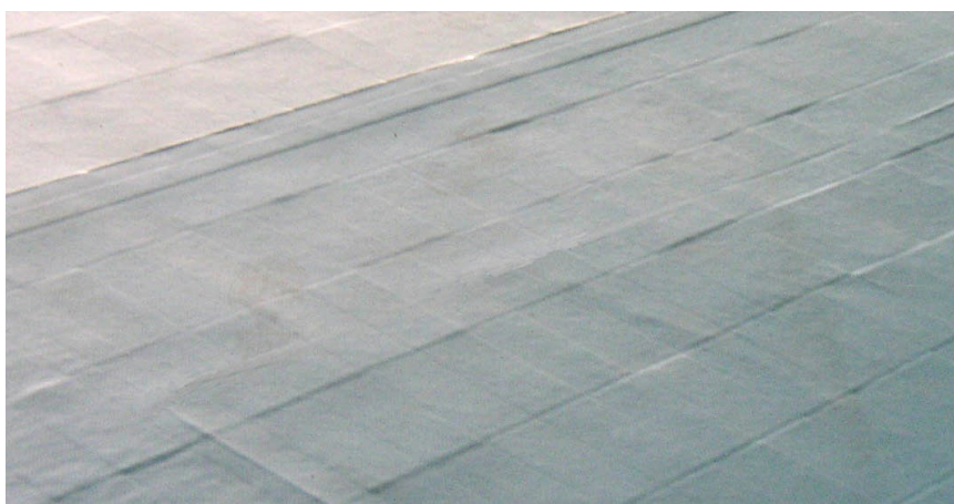
Foto 4. Prokreslení staré dlažby na povrch fólie.
