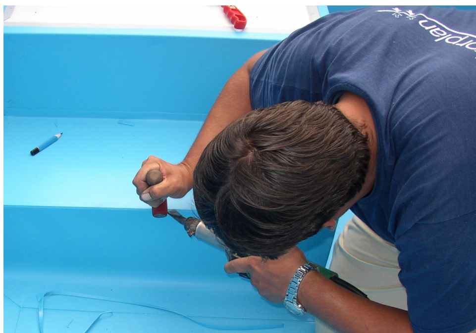
Foto 17. Zaoblení stříhaného okraje fólie na hraně schodu.
