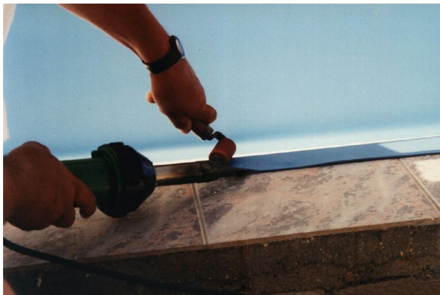
Foto 1. Navařování fólie na profil z poplastovaného plechu
