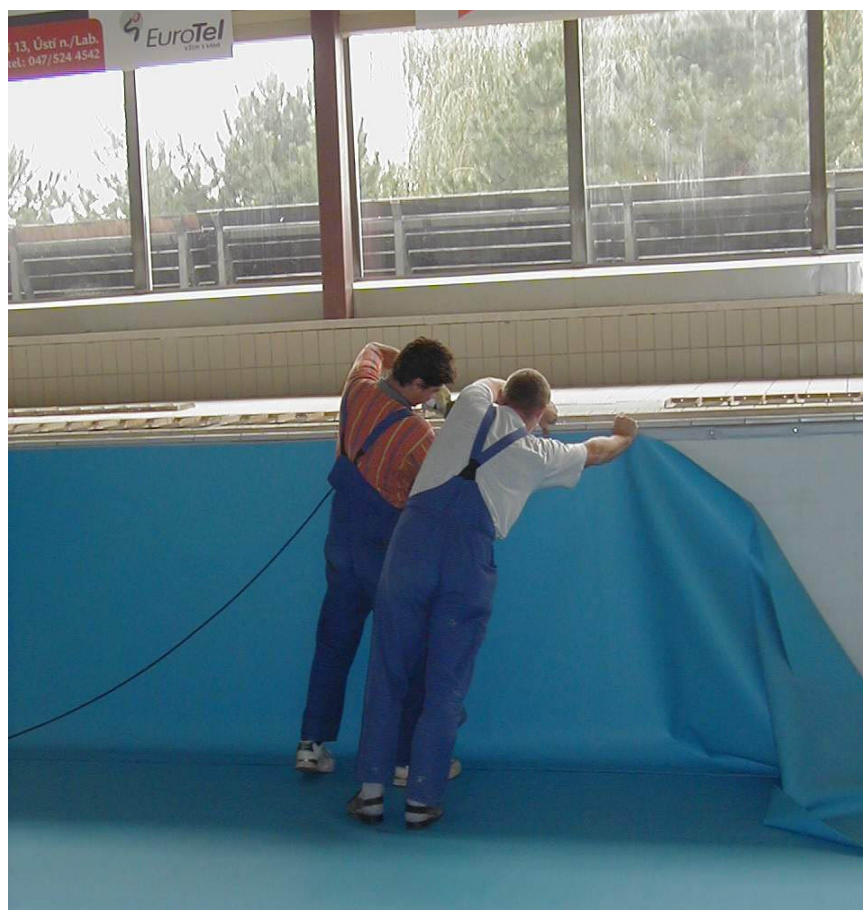
Foto 5. Provádění stěny bazénu.
