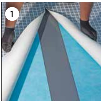
Foto 2. Navařování fólie CERAMICS na podvařovací pás
