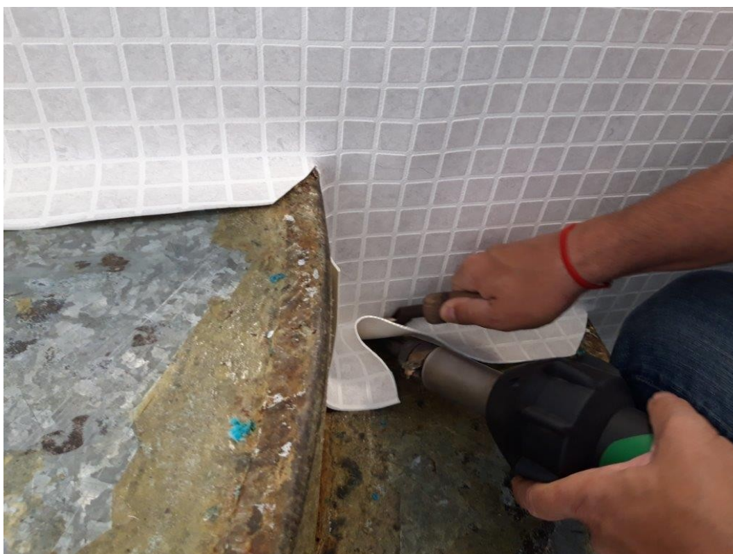
Foto 8. Přivaření fólie do hrany schodů
