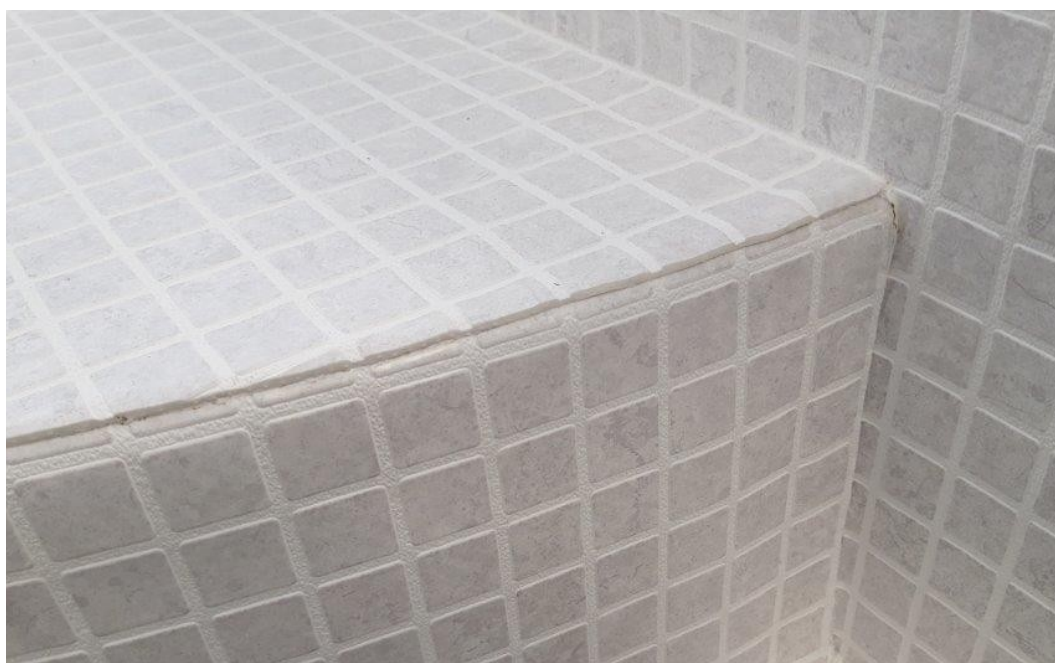
Foto 16. Pohled na svařený schodišťový stupeň
