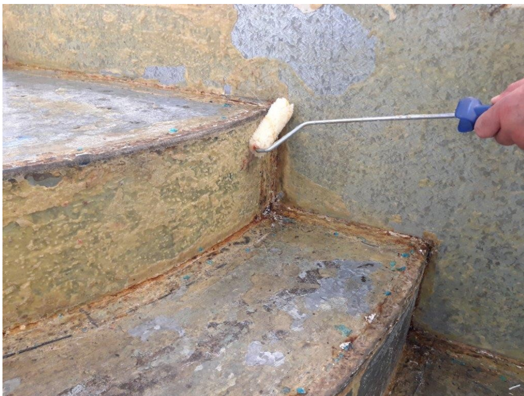
Foto 7. Nanášení lepidla na podklad
