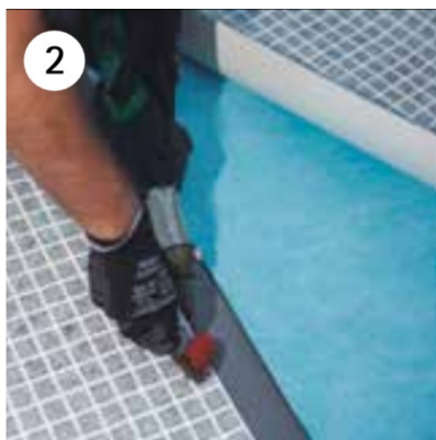
Foto 2. Navařování fólie CERAMICS na podvařovací pás
