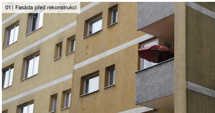
01 | Fasáda před rekonstrukcí
