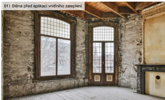
01 | Stěna před aplikací vnitřního zateplení
