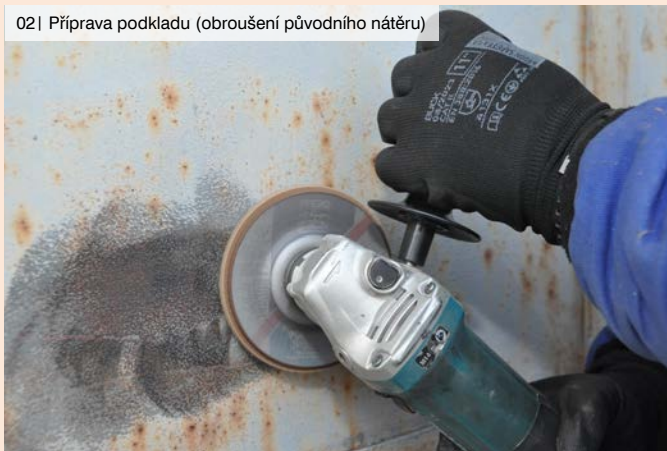
02 | Příprava podkladu (obroušení původního nátěru)
