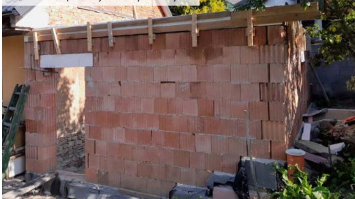
01 | Provádění přístavby ke stávajícímu objektu
