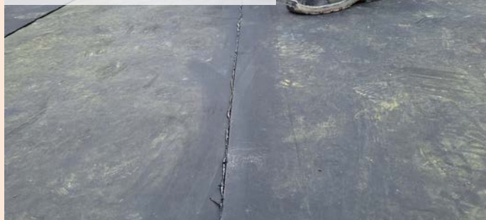
05| Realizace povlakové hydroizolace z EPDM určené pod vegetační střechy (Resitrix SK W)
