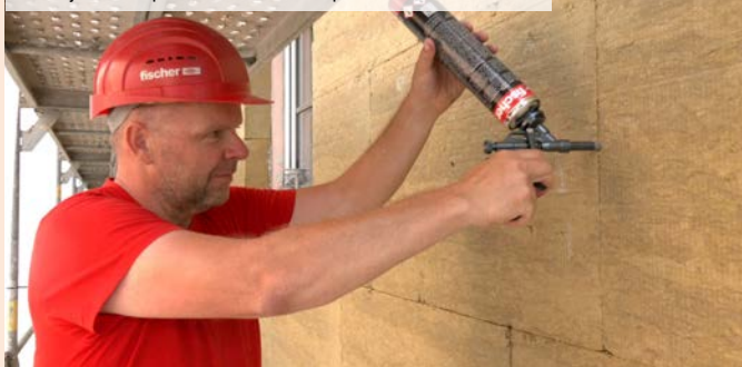
04 | Mechanické kotvení nového ETICS
