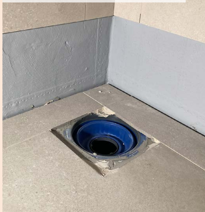
06| Pohled na osazenou sprchovou vaničku
