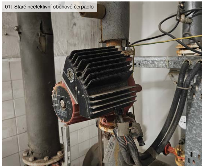
01 | Staré neefektivní oběhové čerpadlo
