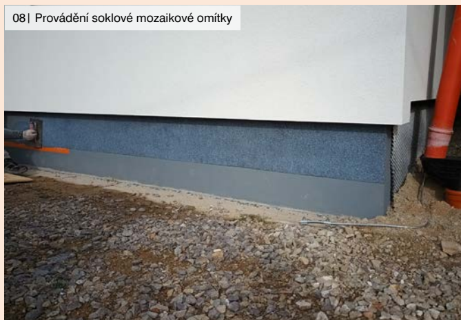
09 | Příklad povrchové úpravy soklu s obkladem
