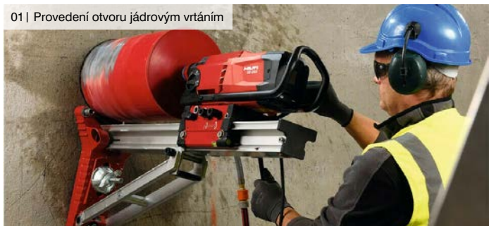
01 | Provedení otvoru jádrovým vrtáním
