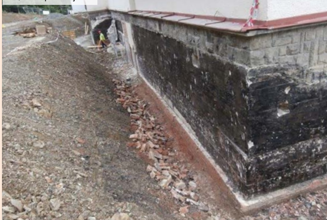
04| Vyrovnaní povrchu zdiva omítkou
