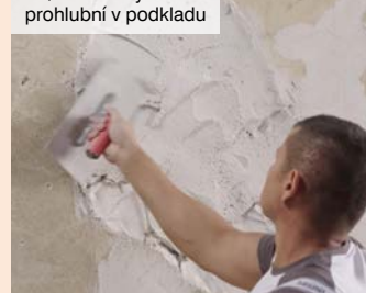
04 | Lokální vyrovnaní prohlubní v podkladu
