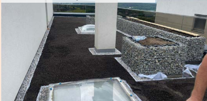
09| Provedení extenzivního vegetačního substrátu GREENDEK
