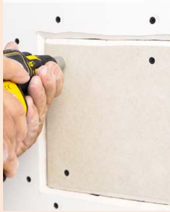
07| Připevnění přířezu k profilům
