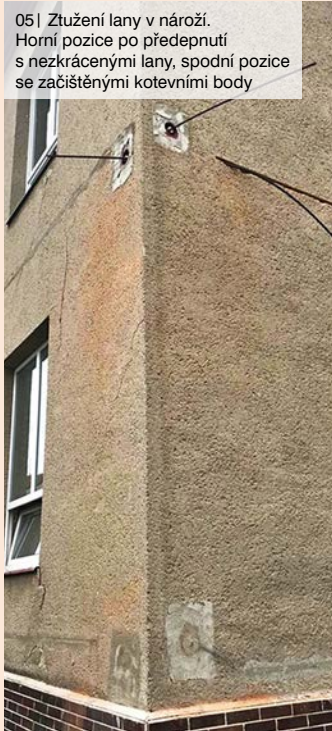
04| Po požadovaném předepnutí jsou lana Monostrand zkrácena k následnému zapravení omítkou
