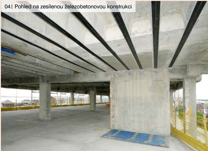
04 | Pohled na zesílenou železobetonovou konstrukci
