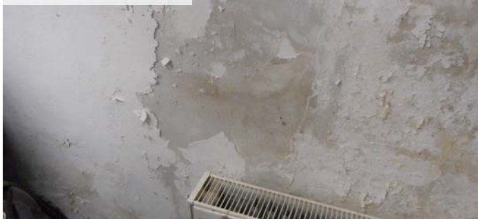
01 | Stav zdiva před rekonstrukcí
