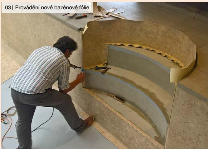
03 | Provádění nové bazénové fólie
