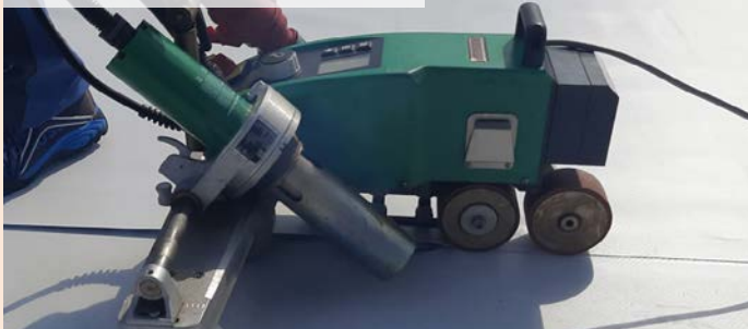
03| Realizace povlakové hydroizolace z TPO určené pod vegetační střechy (Mapeplan)
