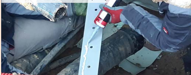
03 | Nanášení PU tmelu na volnou část příruby
