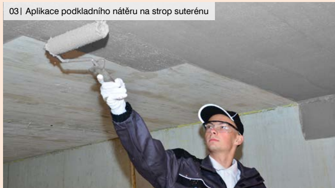
03 | Aplikace podkladního nátěru na strop suterénu
