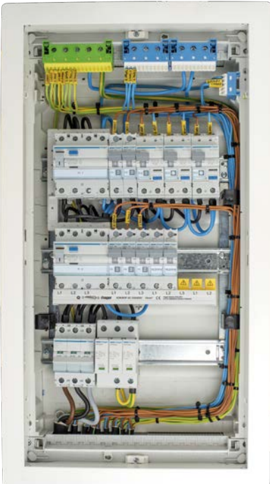
03| Příklad zapojení nového rozvaděče
