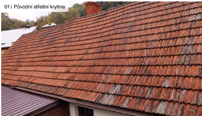
01 | Původní střešní krytina
