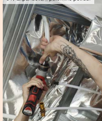
04 | Expandování páteřního potrubí
