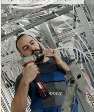
03 | Expandování potrubí z panelu
