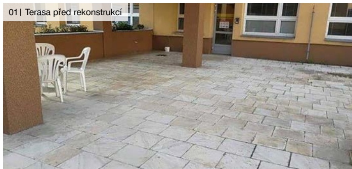
01 | Terasa před rekonstrukcí
