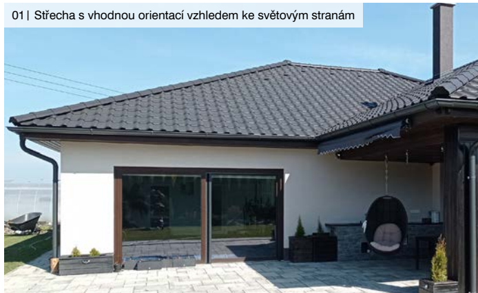
01 | Střecha s vhodnou orientací vzhledem ke světovým stranám
