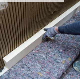
05| Zpevnění rohovými profily
