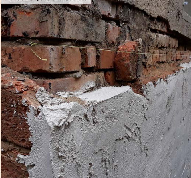
04| Vyrovnaní povrchu zdiva omítkou
