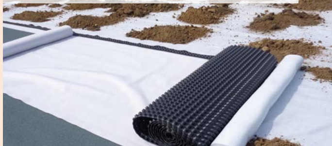
07| Provedení drenážní a hydroakumulační vrstvy (DEKDREN T20 GARDEN včetně geotextilie FILTEK)
