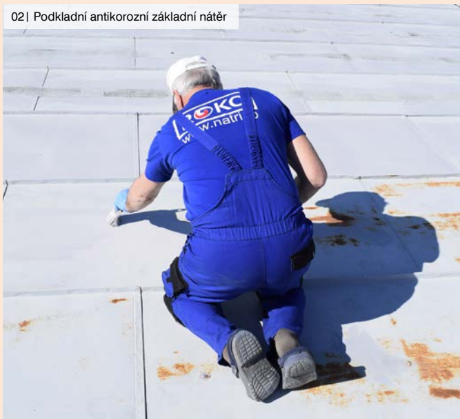
02 | Podkladní antikorozi základní nátěr
