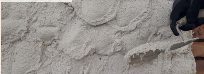
04| Vložení armovací tkaniny do jádrové omítky
