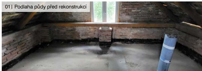
01 | Podlaha půdy před rekonstrukcí
