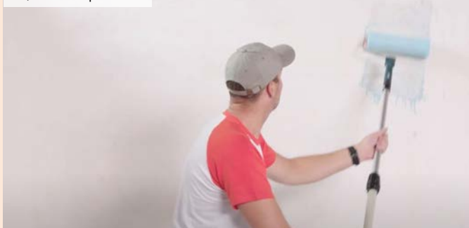
05 | Nanášení penetrace
