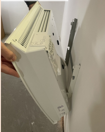
07| Nasazení konvektoru
