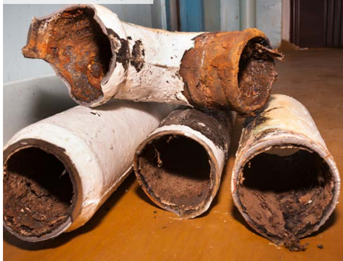
01 | Pohled na staré odpadní potrubí
