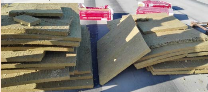
03| Odstraněná tepelná izolace
