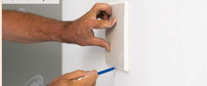
03 | Vyříznutí poškozené části sádrokartonové desky
