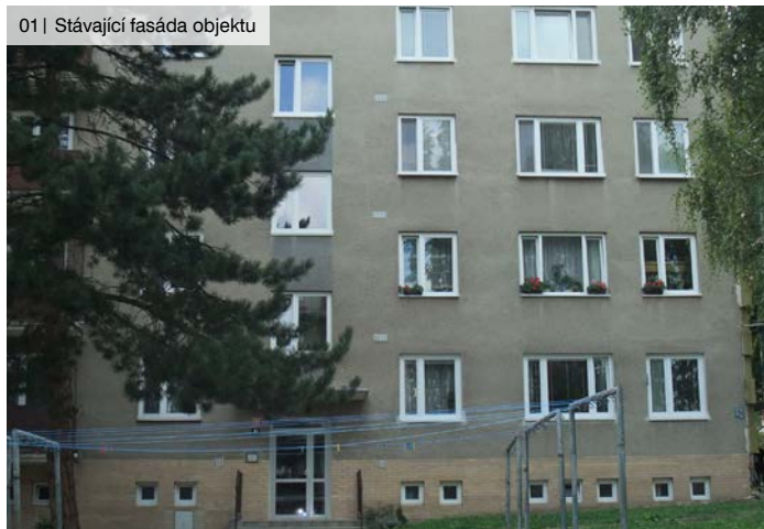
01 | Stávající fasáda objektu
