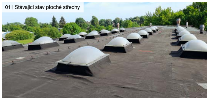
01 | Stávající stav ploché střechy
