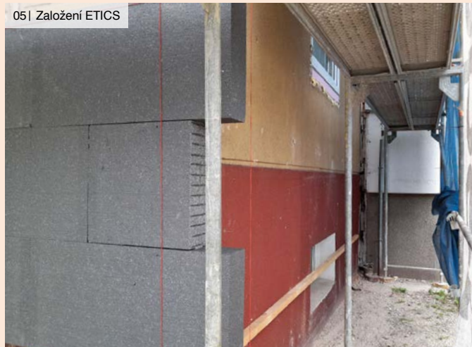
06 | Izolant nalepený na původní podklad
