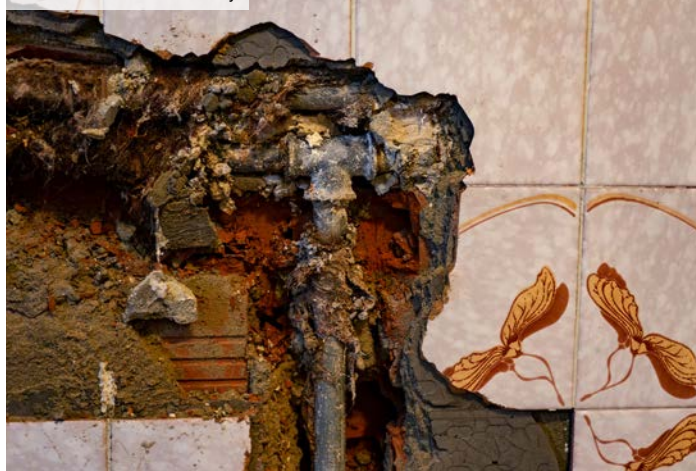
01 | Pohled na staré rozvody
