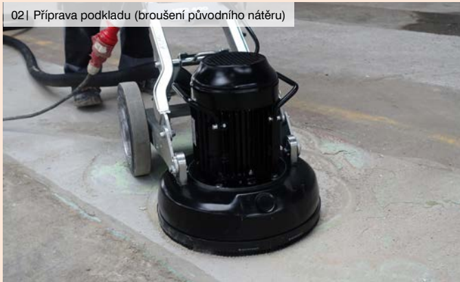
02 | Příprava podkladu (broušení původního nátěru)
