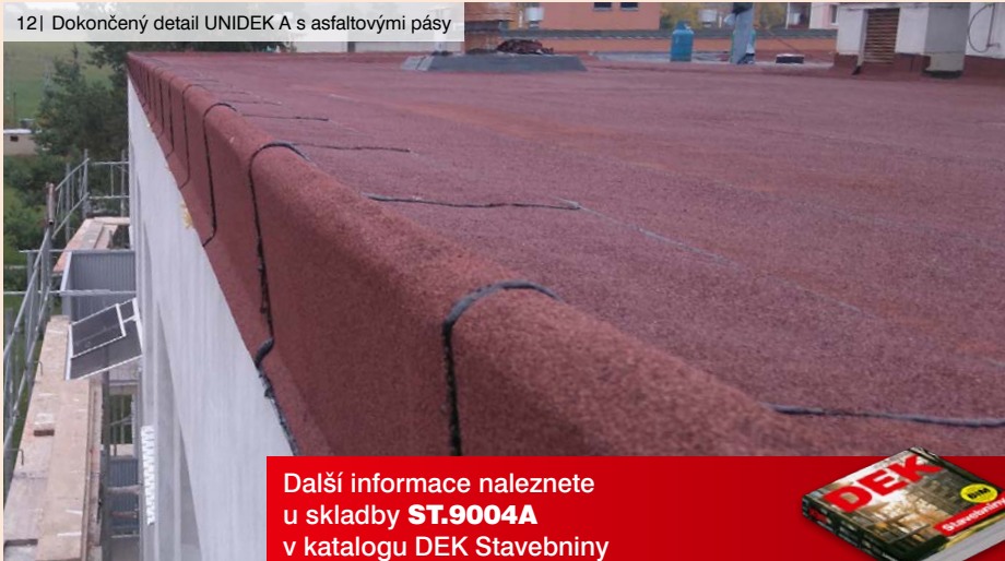
12| Dokončený detail UNIDEK A s asfaltovými pásy
