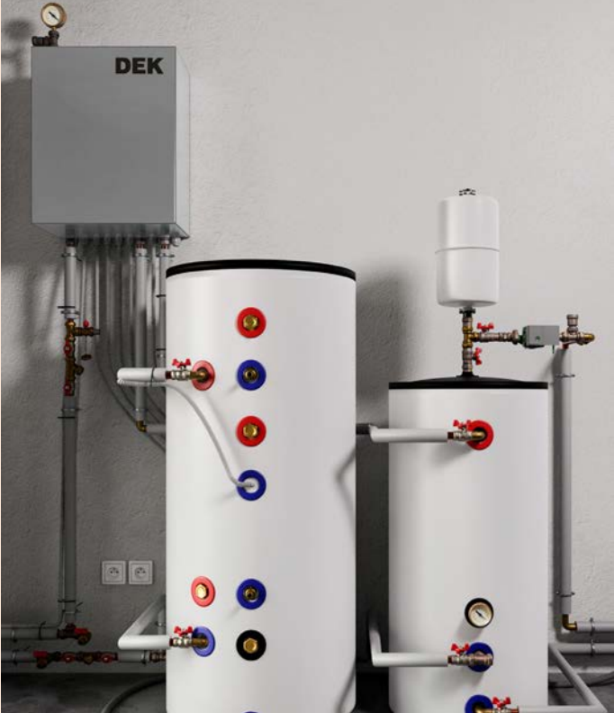
03| Vnitřní instalace se zásobníkem TV
