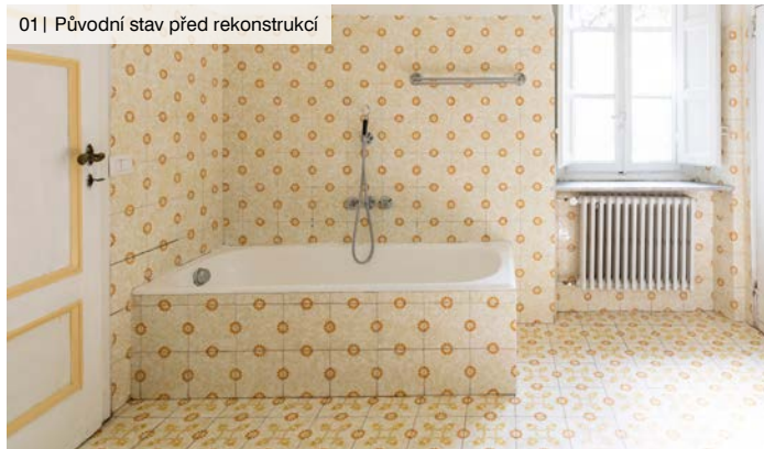
01 | Původní stav před rekonstrukcí
