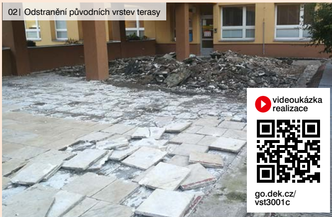
02 | Odstranění původních vrstev terasy
