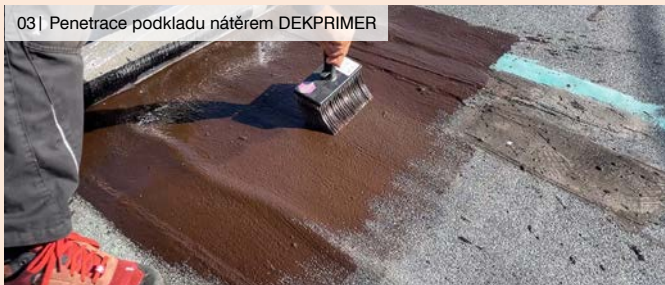
03 | Penetrace podkladu nátěrem DEKPRIMER
