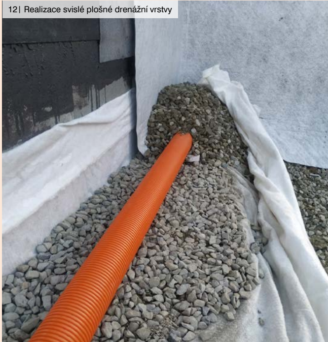
12 | Realizace svislé plošné drenážní vrstvy
