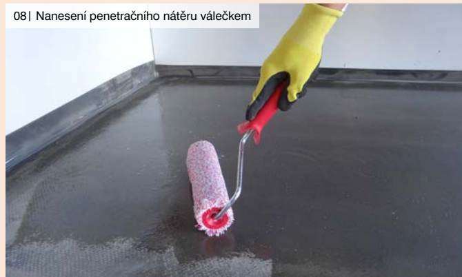
08 | Nanesení penetračního nátěru válečkem
