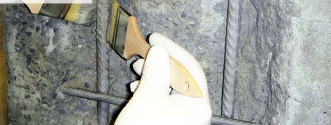
04| Hrubá reprofilace betonové konstrukce
