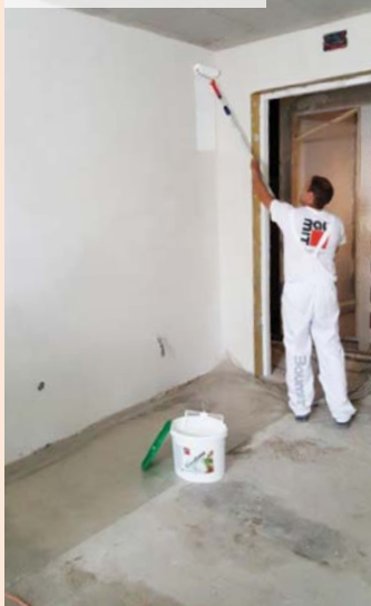
06 | Výmalba po dokončení štukové omítky
