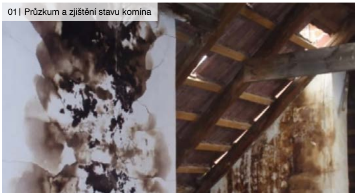
01 | Průzkum a zjištění stavu komína
