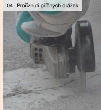
04 | Proříznutí příčných drážek
