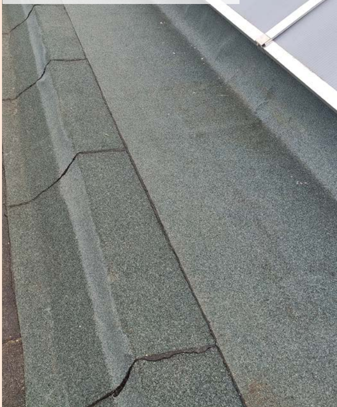
04| Nový povrch na svislé ploše světlíku a přiléhající ploše
