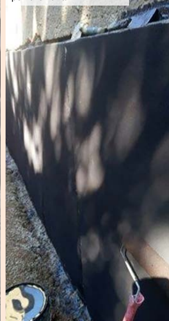
06| Penetrace vyrovnaného povrchu zdiva
