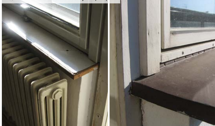
01 | Původní stav vnitřního a vnějšího parapetu
