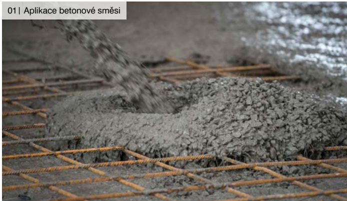
01 | Aplikace betonové směsi
