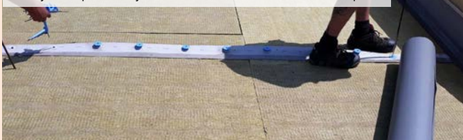
03| Odstraněná tepelná izolace
