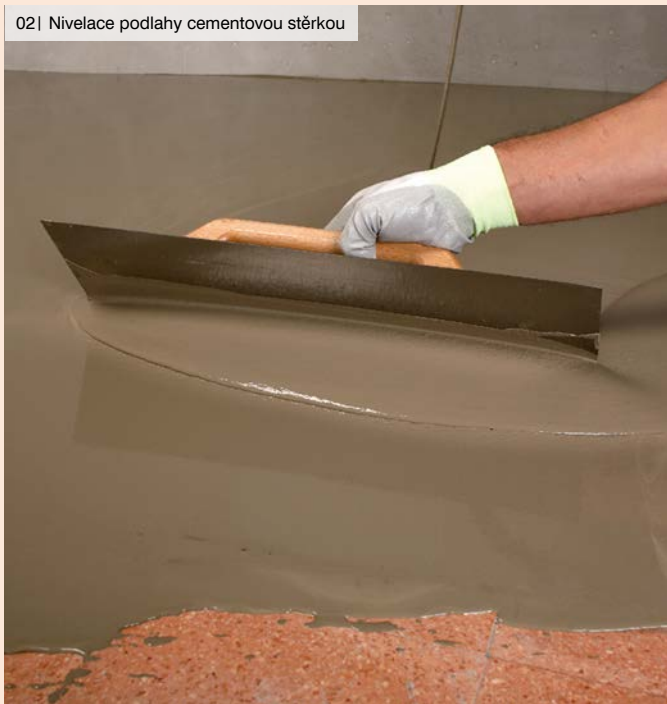
02 | Nivelace podlahy cementovou stěrkou
