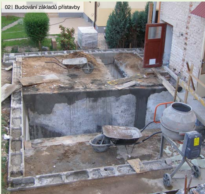
02 | Budování základů přístavby
