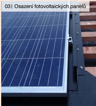
03 | Osazení fotovoltaických panelů
