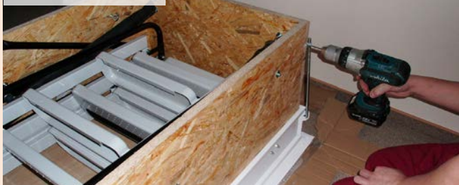
03| Osazení závitových tyčí
