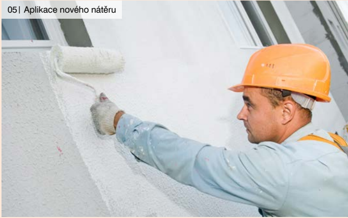
05| Aplikace nového nátěru
