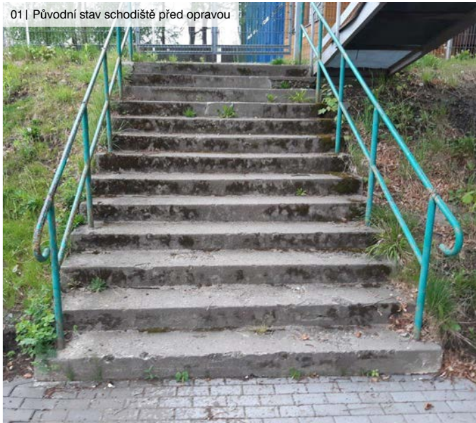
01 | Původní stav schodiště před opravou
