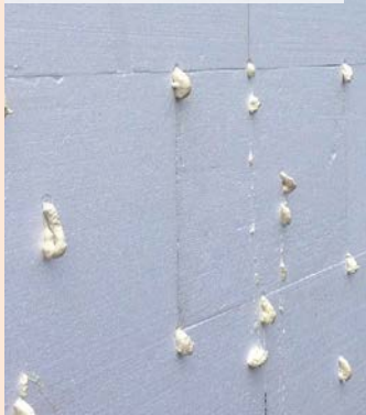
04| Aplikace PU pěny do hmoždinky
