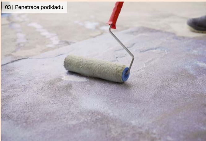
03 | Penetrace podkladu
