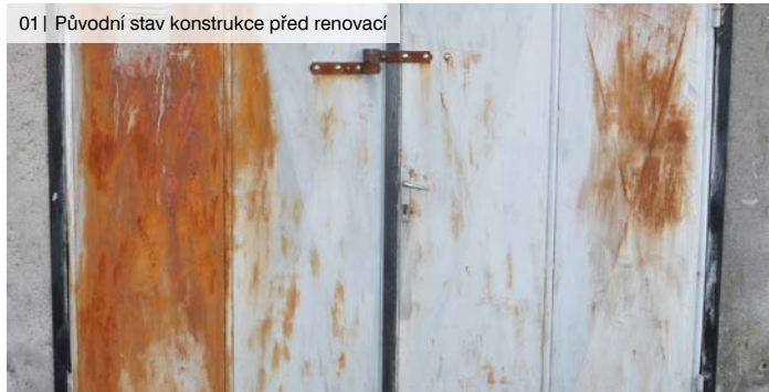
01 | Původní stav konstrukce před renovací
