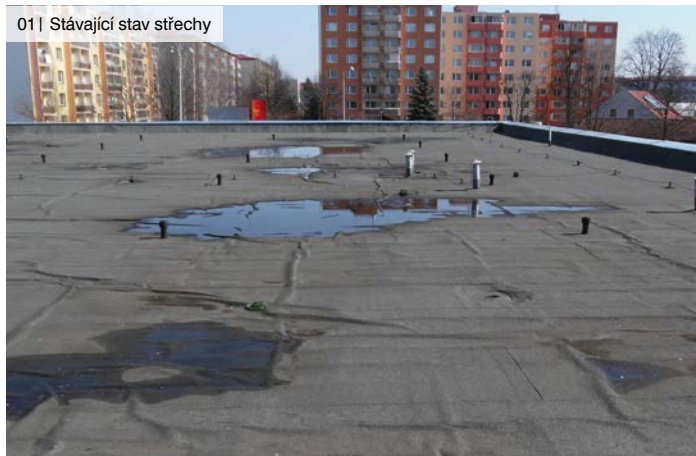
01 | Stávající stav střechy
