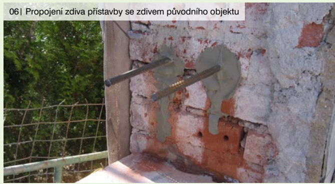
06 | Propojení zdiva přístavby se zdivem původního objektu
