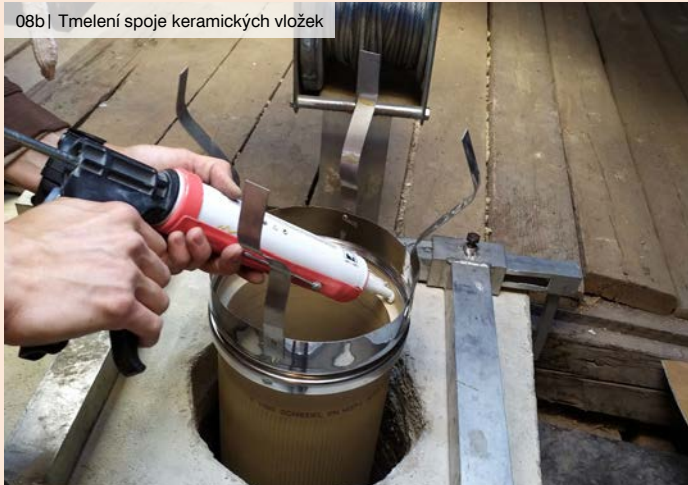
08b| Tmelení spoje keramických vložek
