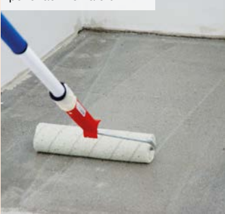
06| Odvzdušnění hmoty nivelačním válečkem
