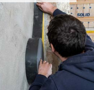
04| Lepení izolace Remmers iQ M střídavě bez průběžných svislých spár
