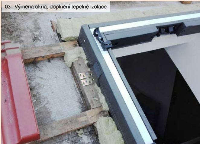
03 | Výměna okna, doplnění tepelné izolace
