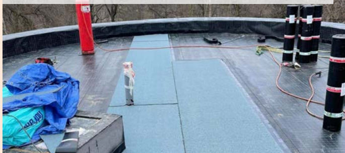
05| Realizace povlakové hydroizolace z EPDM určené pod vegetační střechy (Resitrix SK W)
