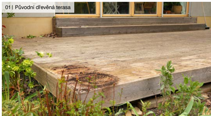
01 | Původní dřevěná terasa
