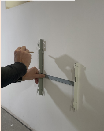
07| Nasazení konvektoru
