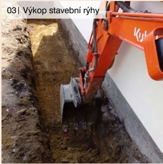
04| Postup výkopu jámy pod základové pasy do požadované hloubky
