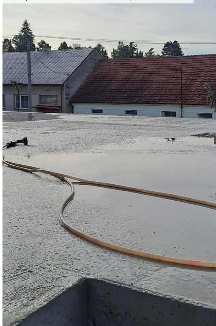
05 | Kropení čerstvého betonu vodou lze nahradit aplikací Stachema CH330
