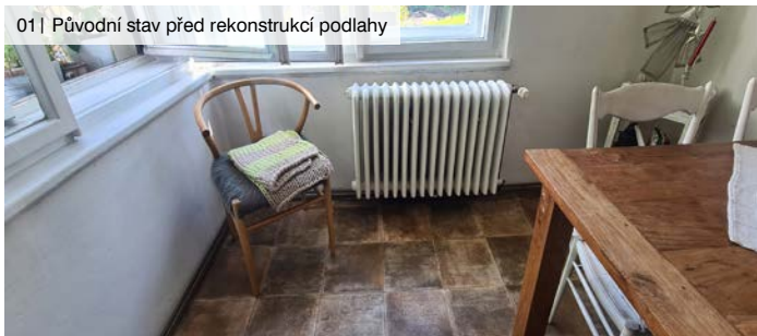
01 | Původní stav před rekonstrukcí podlahy
