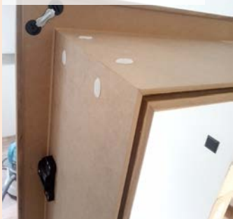
04| Vsazení přední rám v otvoru
