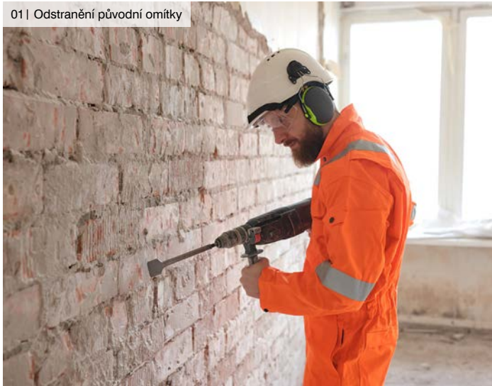
01 | Odstranění původní omítky
