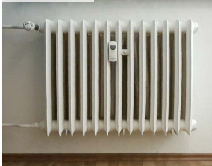
01 | Stávající článkové otopné těleso
