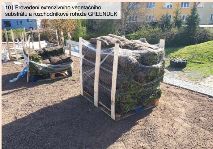
11| Provedení extenzivního vegetačního substrátu a rozchodníkové rože GREENDEK
