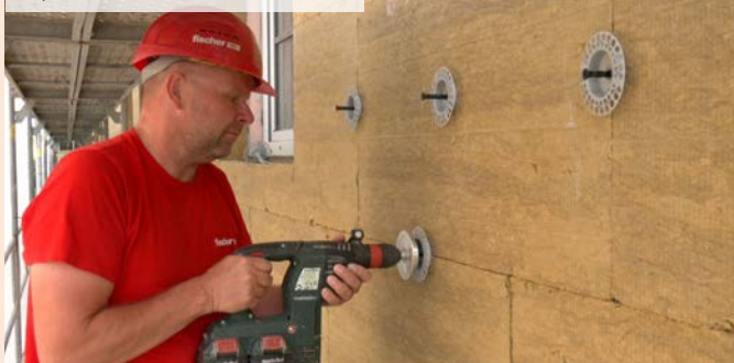
04 | Mechanické kotvení nového ETICS
