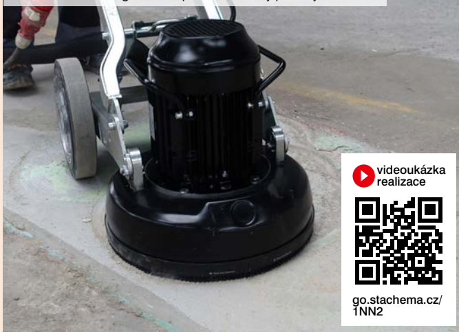
02 | Odstraňování degradované povrchové vrstvy podlahy broušením
