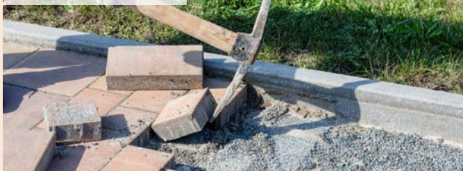
02 | Odstranění původní dlažby
