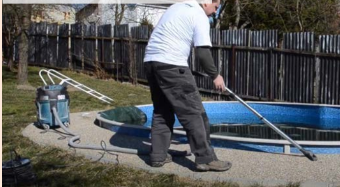
02 | Čištění podkladu po lokálním vyplnění výtluků
