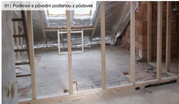
01 | Podkroví s původní podlahou z půdovek
