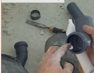
03 | Aplikace montážního maziva do hrdla tvarovky
