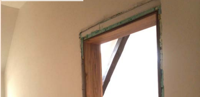
05| Nasazení zadního rámu do předního rámu
