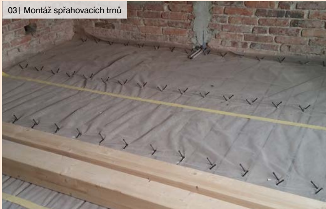
03 | Montáž spřahovacích trnů
