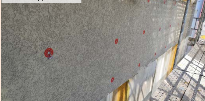
03 | Injektování předvrtaného otvoru pro mechanické kotvení
