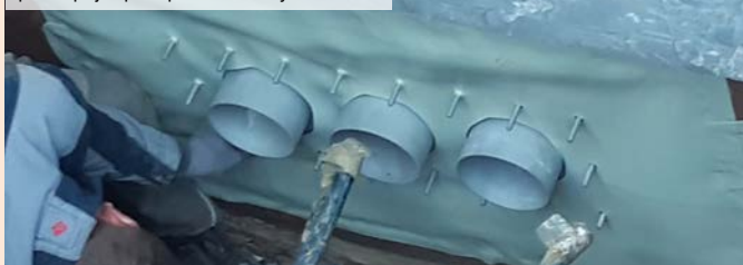
03 | Nanášení PU tmelu na volnou část příruby
