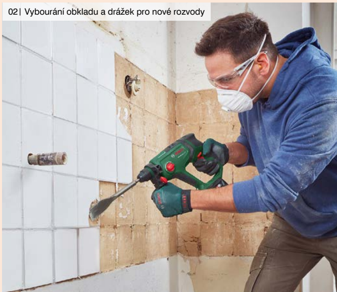
02 | Vybourání obkladu a drážek pro nové rozvody
