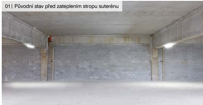
01 | Původní stav před zateplením stropu suterénu
