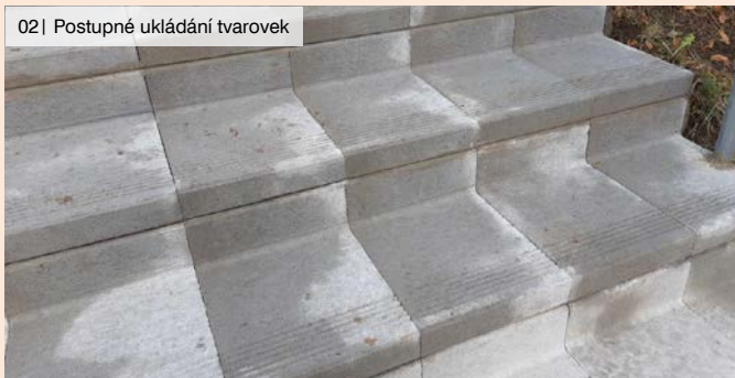
02 | Postupné ukládání tvarovek
