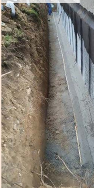
05| Vytvoření betonového žlabu
