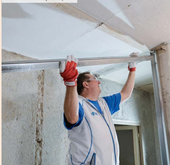
03 | Montáž obvodových UW profilů
