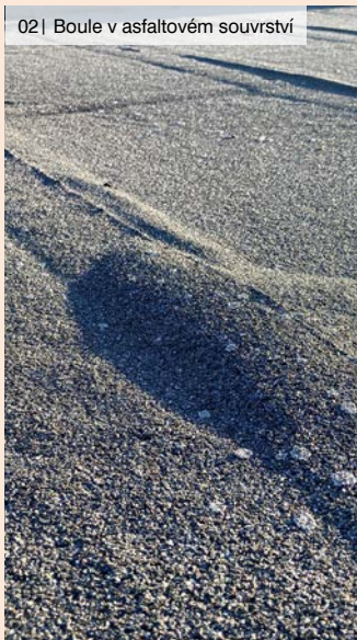
02 | Boule v asfaltovém souvrství
