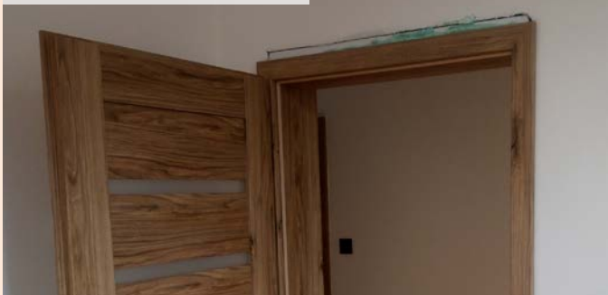
06| Obložkové zárubně osazené křídlem
