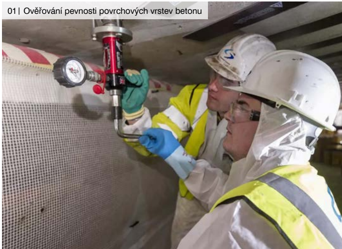
01 | Ověřování pevnosti povrchových vrstev betonu
