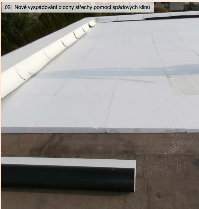
02 | Nové vyspádování plochy střechy pomocí spádových klínů
