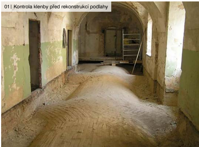
01 | Kontrola klenby před rekonstrukcí podlahy
