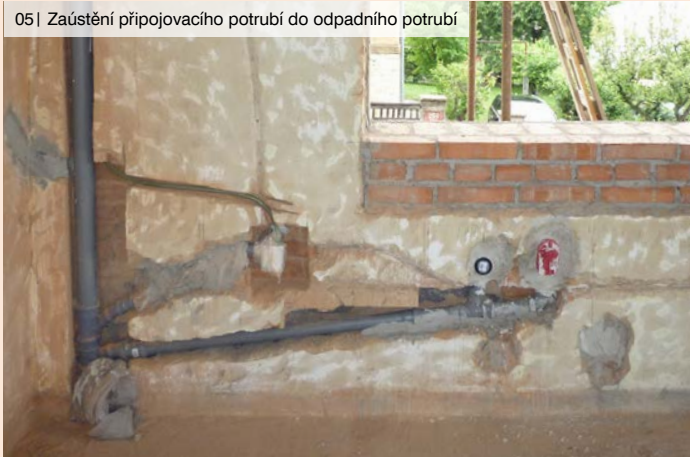
05| Zaústění připojovacího potrubí do odpadního potrubí
