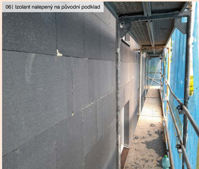
06 | Izolant nalepený na původní podklad
