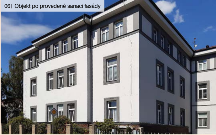
06| Objekt po provedené sanaci fasády
