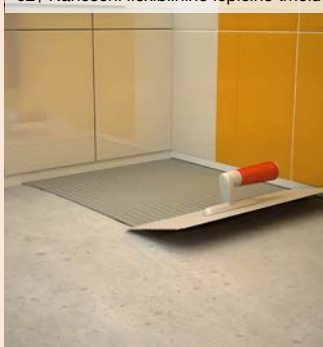
02 | Nanesení flexibilního lepicího tmelu
