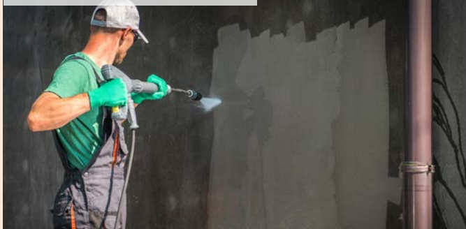
02 | Dokotvený původní ETICS
