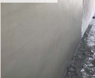
05| Jemná reprofilace betonové konstrukce
