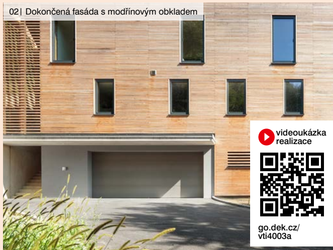
02 | Dokončená fasáda s modřínovým obkladem
