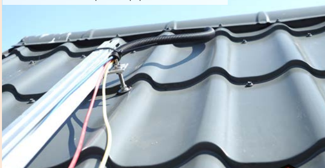
02 | Nosná konstrukce pro FV a příprava elektroinstalace
