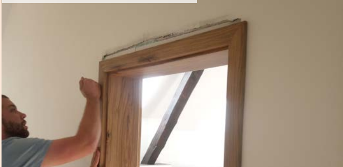
06| Obložkové zárubně osazené křídlem
