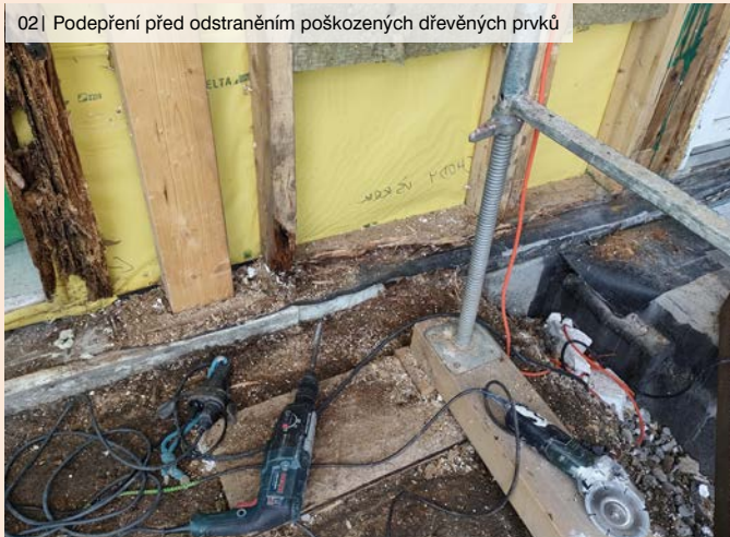
02 | Podepření před odstraněním poškozených dřevěných prvků
