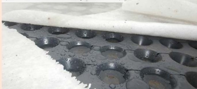
08| Provedení drenážní a hydroakumulační vrstvy (DEKDREN T20 GARDEN včetně geotextilie FILTEK)
