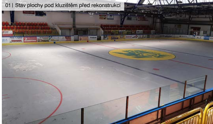
01 | Stav plochy pod kluzištěm před rekonstrukcí
