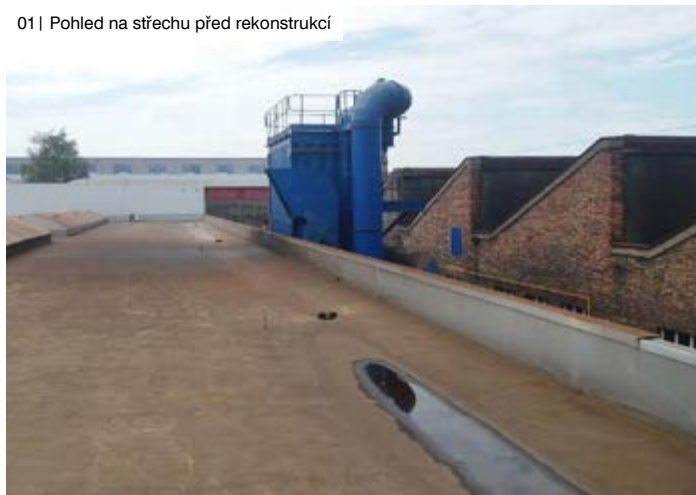
01 | Pohled na střechu před rekonstrukcí
