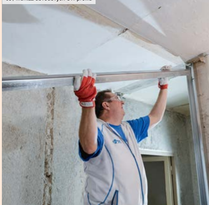
03| Montáž obvodových UW profilů
