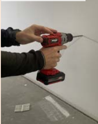
04| Vyvrtání otvorů pro hmoždinky
