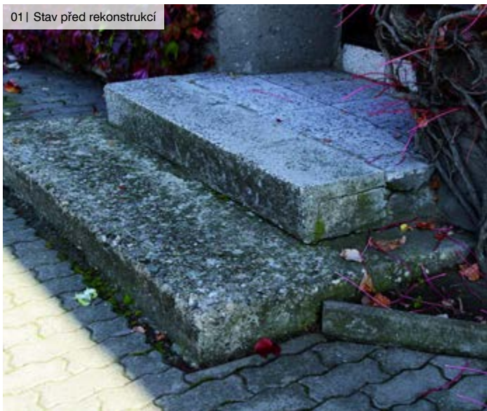
01 | Stav před rekonstrukcí
