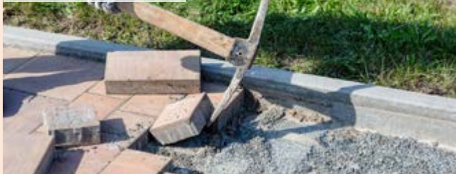
02 | Odstranění původní dlažby
