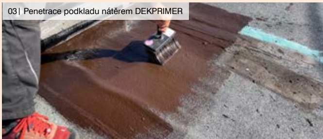
03 | Penetrace podkladu nátěrem DEKPRIMER
