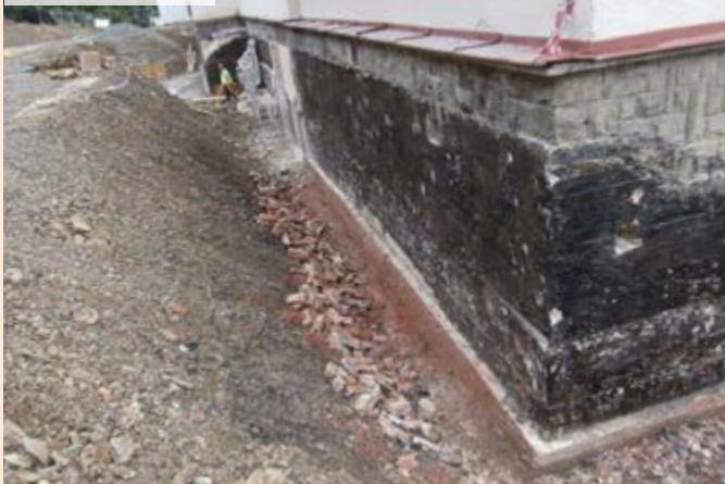
04 | Vyrovnaní povrchu zdiva omítkou
