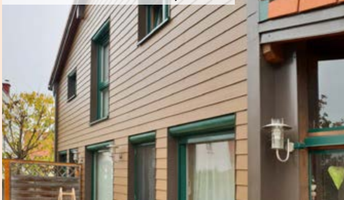
04| Dokončená fasáda s vláknocementovým obkladem
