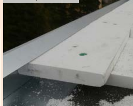
10| Tepelná izolace z EPS zasunutá do prvku UNIDEK A
