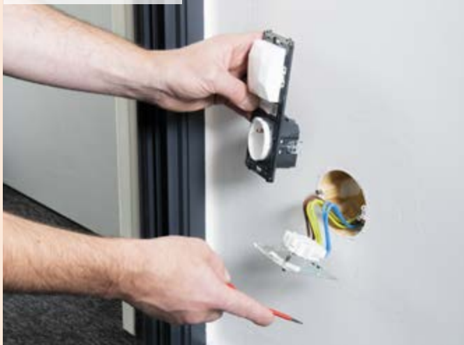
02 | Instalace startovacího kitu
