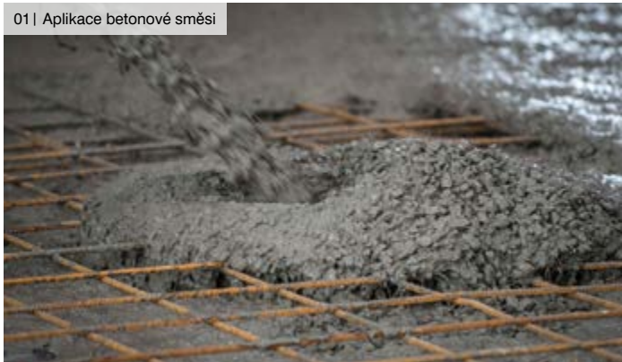
01 | Aplikace betonové směsi
