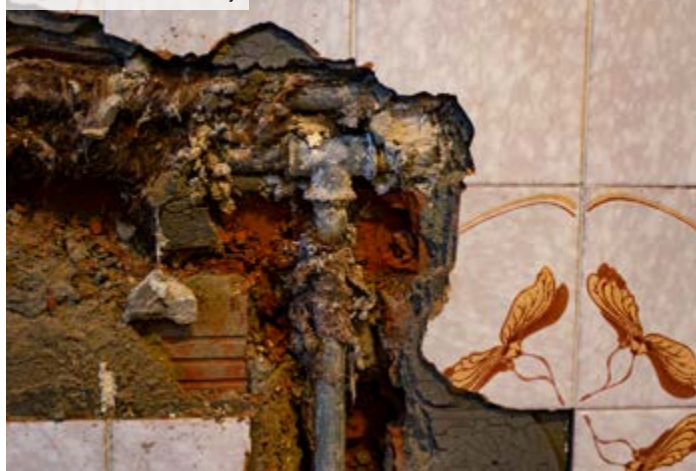
01 | Pohled na staré rozvody
