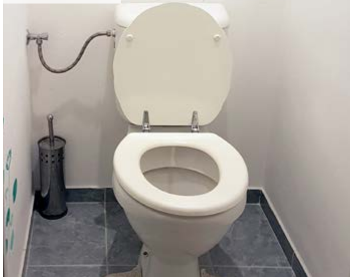
01 | Pohled na původní WC
