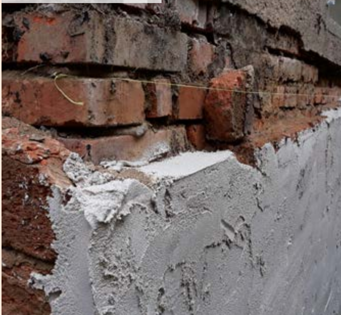
04 | Vyrovnaní povrchu zdiva omítkou
