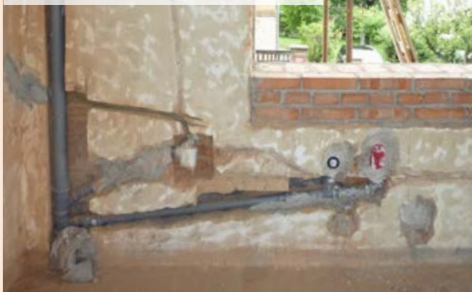
05 | Zaústění připojovacího potrubí do odpadního potrubí
