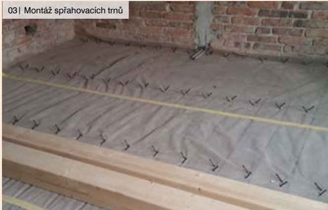
03 | Montáž spřahovacích trnů
