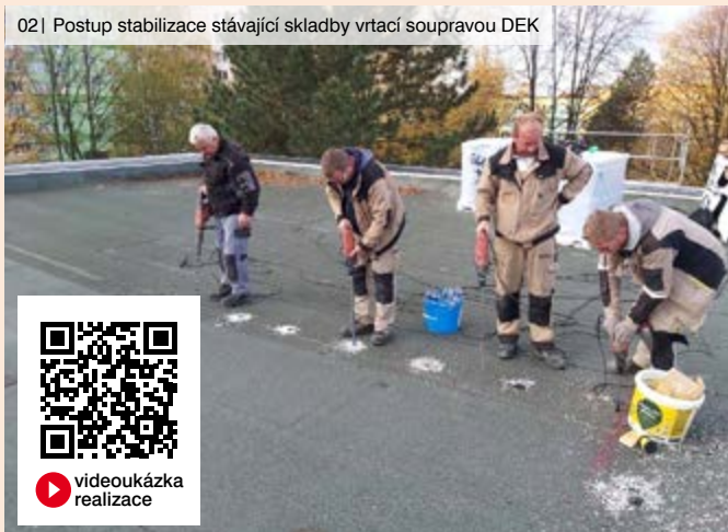
02 | Postup stabilizace stávající skladby vrtací soupravou DEK
