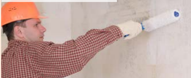
04| Aplikace nového nátěru
