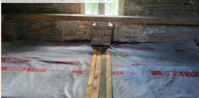
06| Montáž pochozí lávky na dřevěné hranoly
