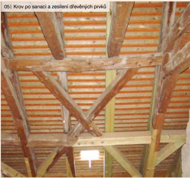
05| Krov po sanaci a zesílení dřevěných prvků
