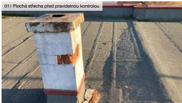
01 | Plochá střecha před pravidelnou kontrolou
