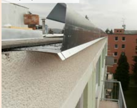
12| Dokončený detail UNIDEK A s asfaltovými pásy
