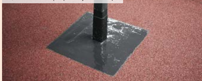
07| Pohled na detail po aplikaci systému Enkopur
