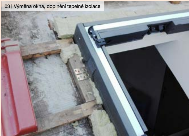
03 | Výměna okna, doplnění tepelné izolace
