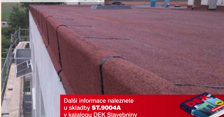
12| Dokončený detail UNIDEK A s asfaltovými pásy
