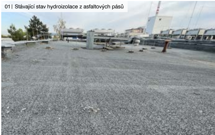
01 | Stávající stav hydroizolace z asfaltových pásů
