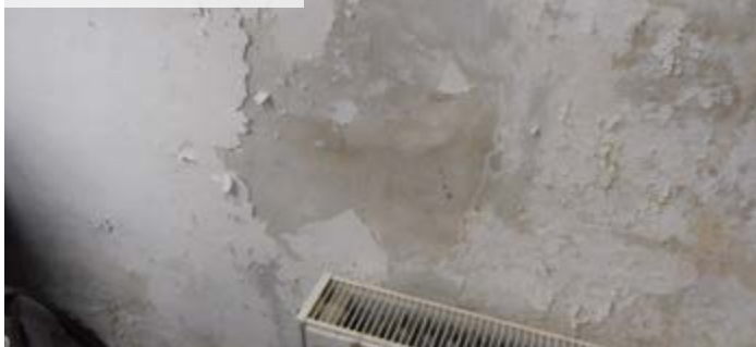
01 | Stav zdiva před rekonstrukcí
