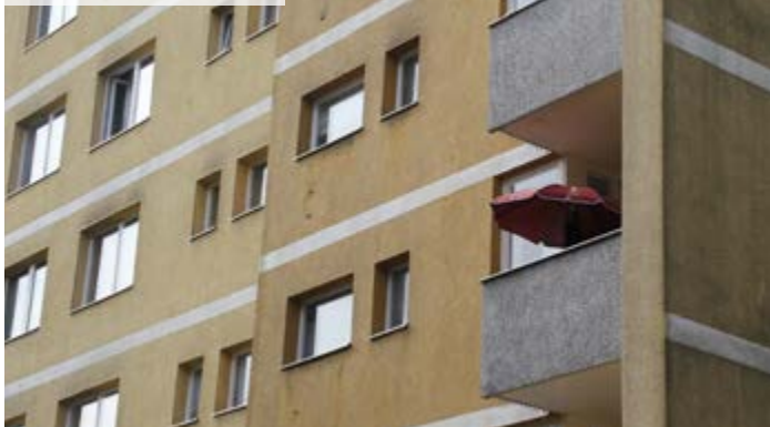
01 | Fasáda před rekonstrukcí
