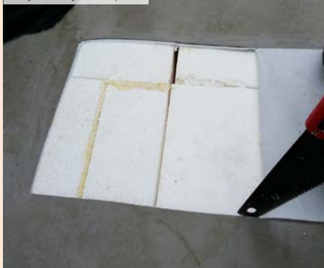
02 | Odhrnutí kameniva a provedení sondy do skladby střešního pláště
