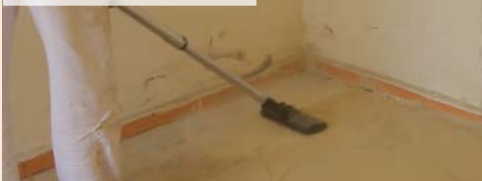
04| Nanášení penetračního nátěru na podlahu a sokl
