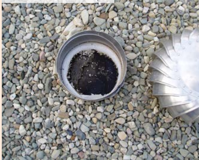
05| Pohled do otevřeného komínku s viditelnou vodou ve skladbě střešního pláště
