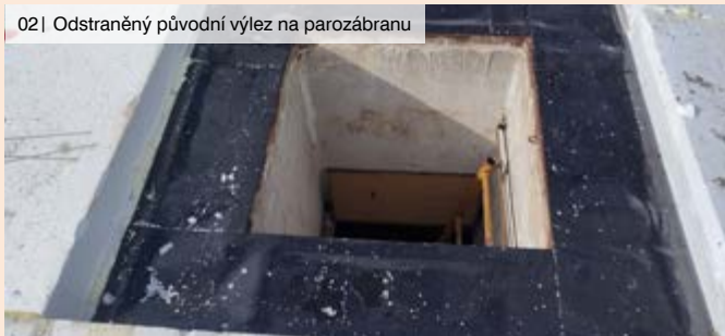
02 | Odstraněný původní výlez na parozábranu
