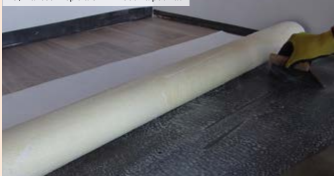
14| Pokládka podlahové krytiny do lepidla
