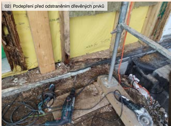
02 | Podepření před odstraněním dřevěných prvků
