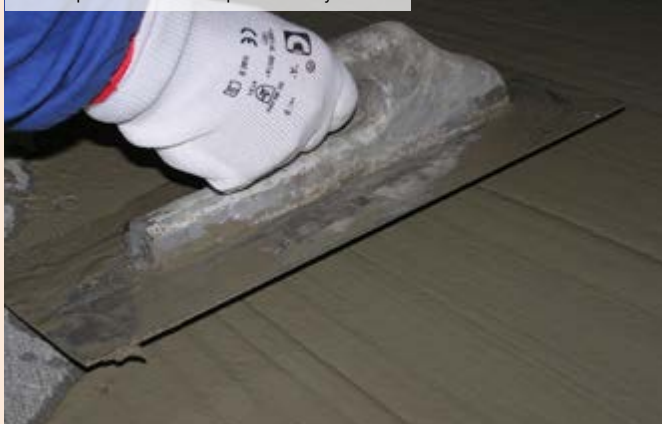
04 | Vyrovnání povrchu po odstranění uvolněných dlaždic pomocí weberbat opravné hmoty
