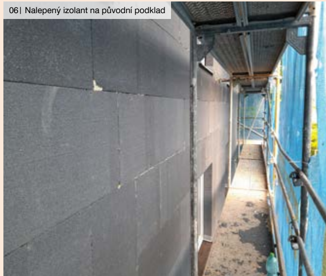
06 | Nalepený izolant na původní podklad
