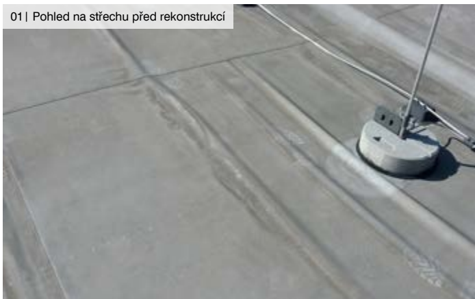
01 | Pohled na střechu před rekonstrukcí
