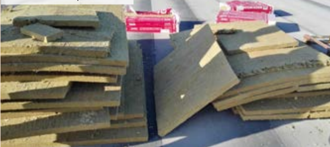
03| Odstraněná tepelná izolace
