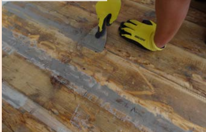
04 | Vyspravení spár a případných prasklin
