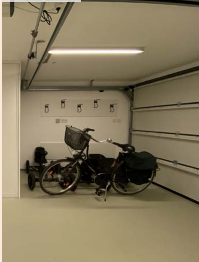
06| Podlaha garáže po renovaci
