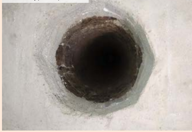
04a | Nově vyložkovaný komín z nerezových vložek
