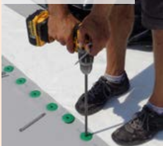
03| Pokládka a stabilizace nové hydroizolace z PVC-P fólie
