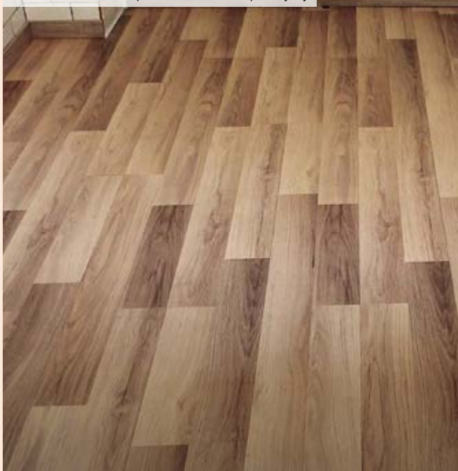
06| Pohled na hotovou podlahu včetně nášlapné krytiny
