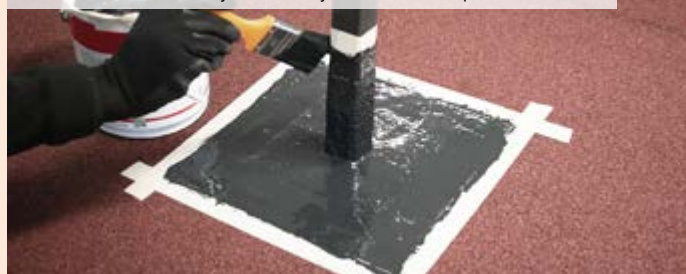
07| Pohled na detail po aplikaci systému Enkopur
