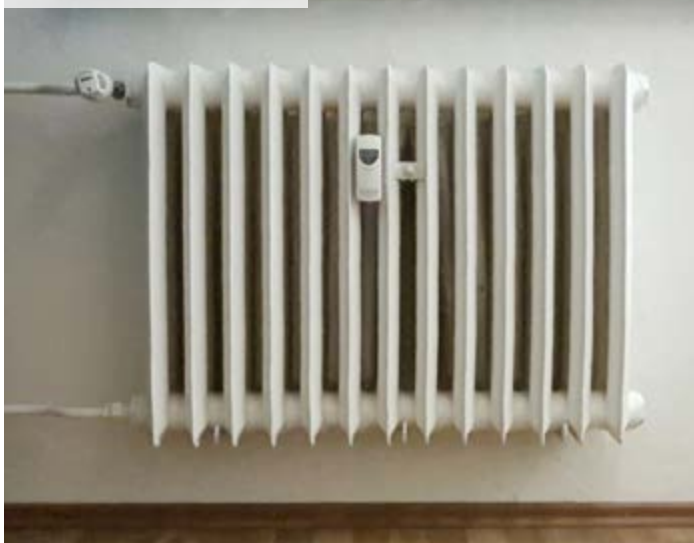
01 | Stávající článkové otopné těleso
