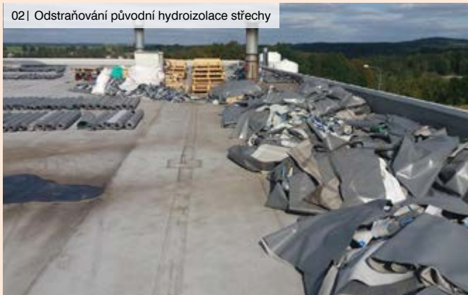
02 | Odstraňování původní hydroizolace střechy
