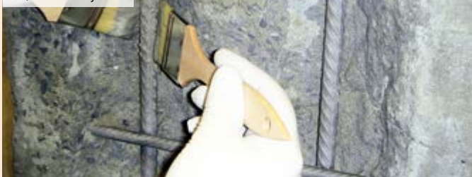
04| Hrubá reprofilace betonové konstrukce
