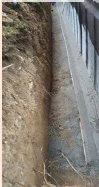
05 | Vytvoření betonového žlabu
