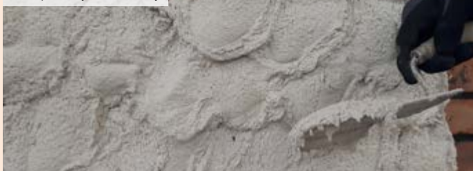
04| Vložení armovací tkaniny do jádrové omítky
