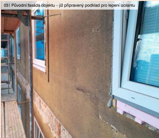
03 | Původní fasáda objektu – již připravený podklad pro lepení izolantu
