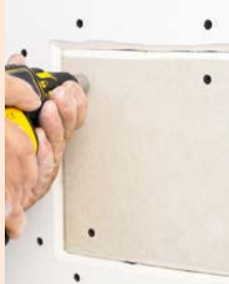
07| Připevnění přířezu k profilům
