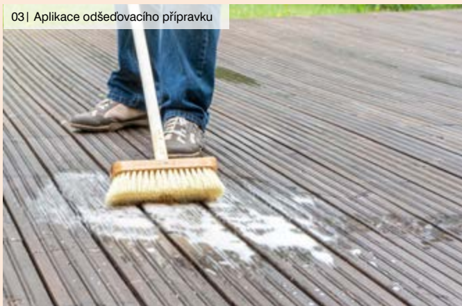
03 | Aplikace odšedovacího přípravku
