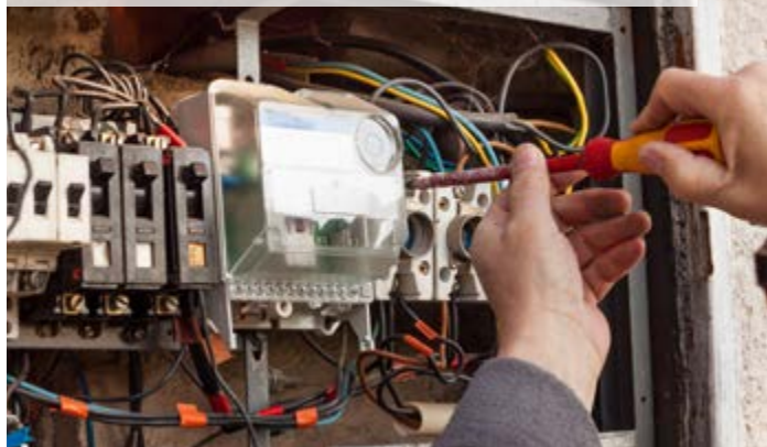
01 | Jističí prvky jednotlivých vývodů se nesmí nacházet v elektroměrové skříni
