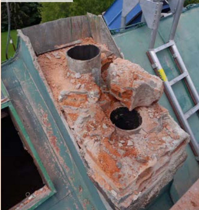
02 | Odstranění komínového zdiva v nadstřešní části
