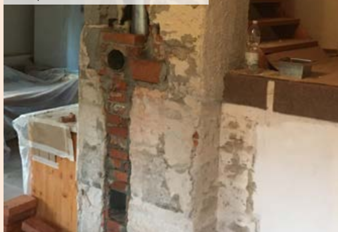
05a | Oprava komínového zdiva v interiérové části
