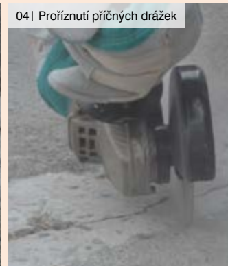
04 | Proříznutí příčných drážek
