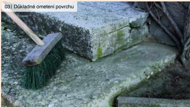
03 | Důkladné ometení povrchu
