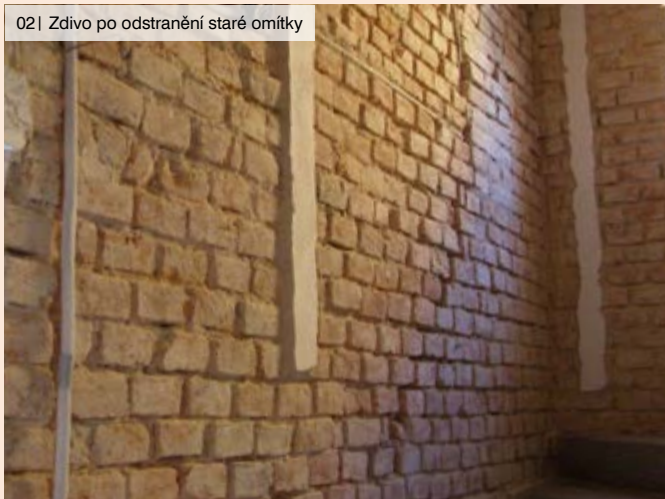
02 | Zdivo po odstranění staré omítky
