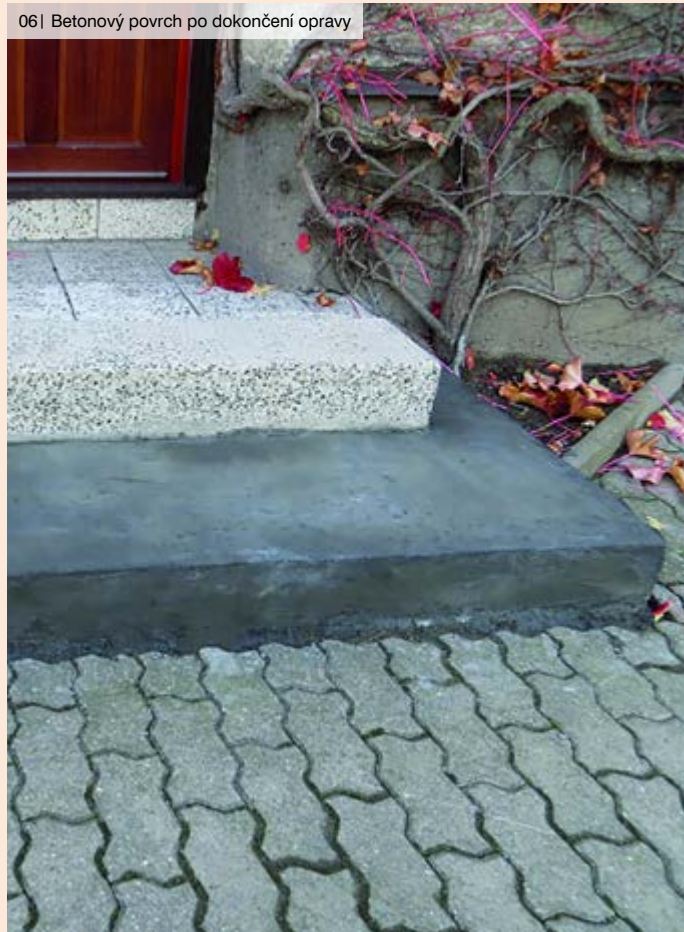
06 | Betonový povrch po dokončení opravy
