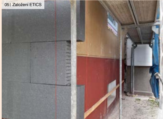
06 | Nalepený izolant na původní podklad
