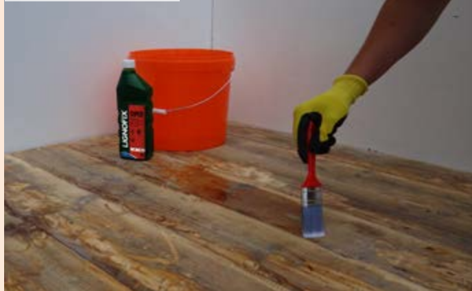
04 | Vyspravení spár a případných prasklin
