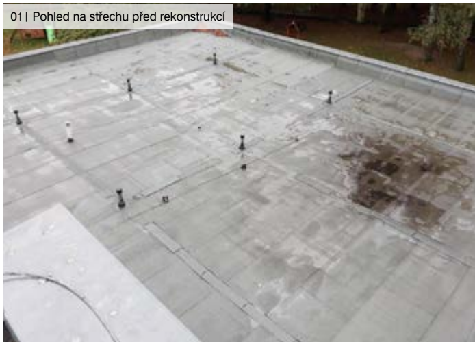
01 | Pohled na střechu před rekonstrukcí
