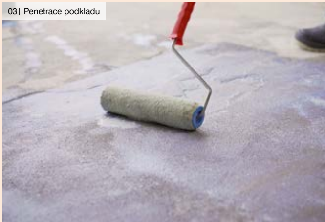
03 | Penetrace podkladu
