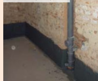
04 | Nové odpadní potrubí
