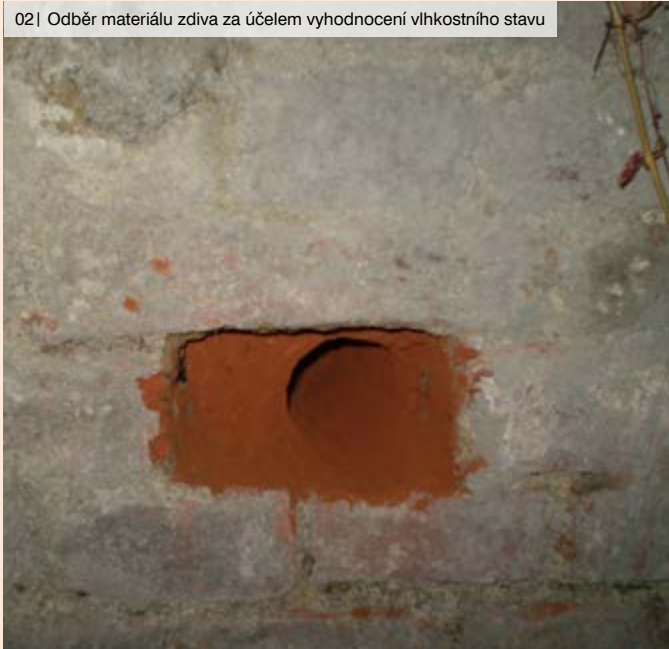
02 | Odběr materiálu zdiva za účelem vyhodnocení vlhkostního stavu
