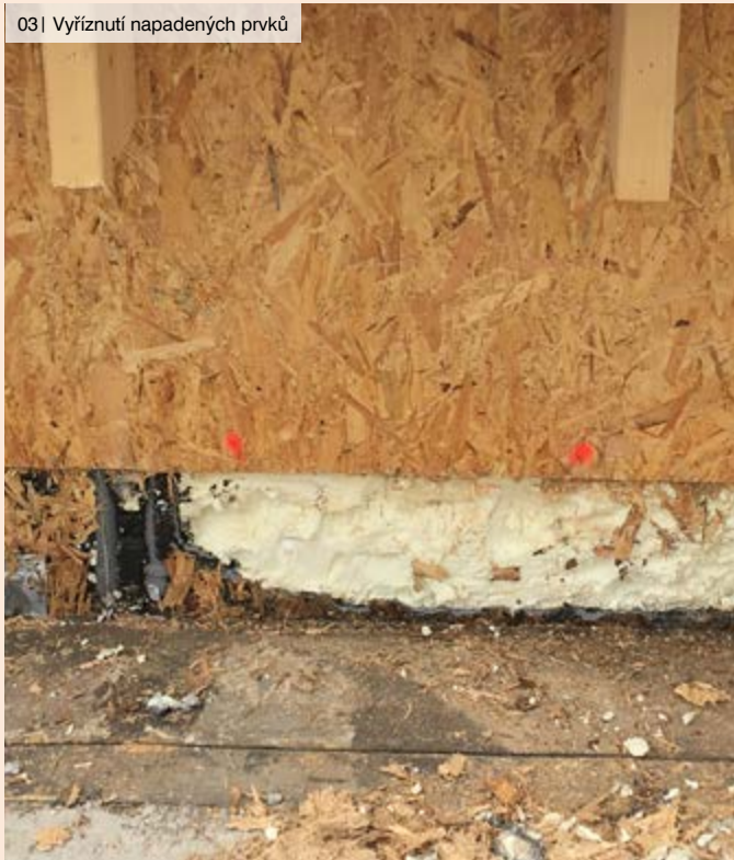
03 | Vyřiznutí napadených prvků
