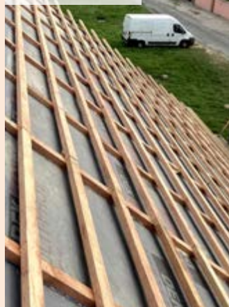
05 | Provedení latování pro skládanou krytinu
