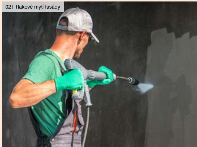
02 | Tlakové mytí fasády
