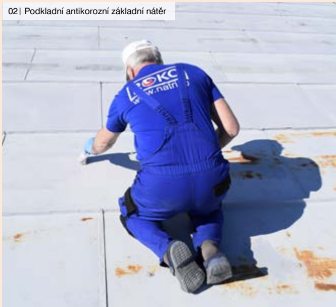
02 | Podkladní antikorozi základní nátěr
