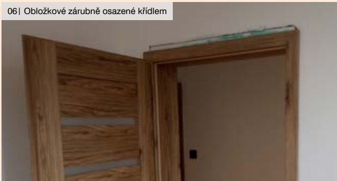
06| Obložkové zárubně osazené křídlem
