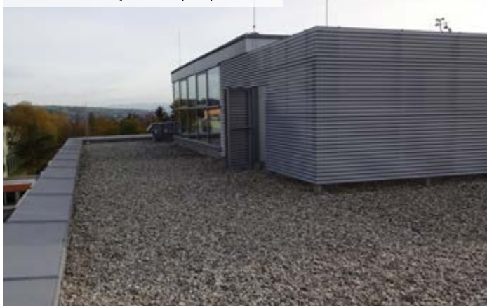
01 | Pohled na stávající střechu před průzkumem
