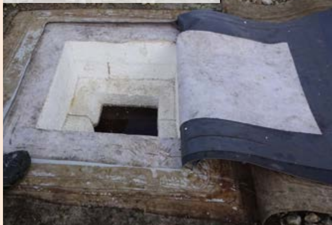
04| Vysávání vody pomocí vysavače
