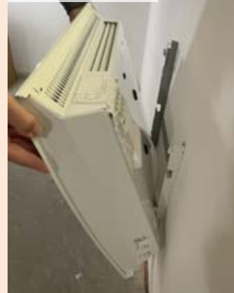
07| Nasazení konvektoru
