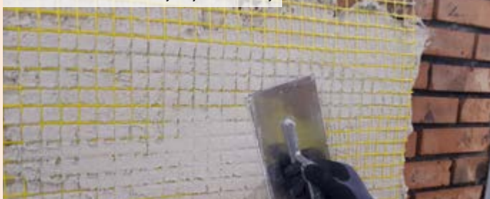
04| Vložení armovací tkaniny do jádrové omítky
