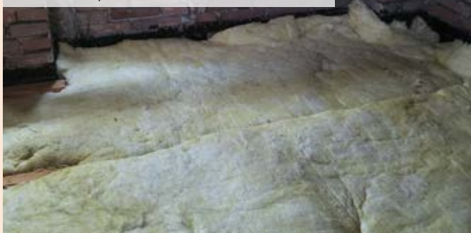
05| Aplikace difuzní fólie pro zakrytí tepelné izolace před zaprášením a profukováním
