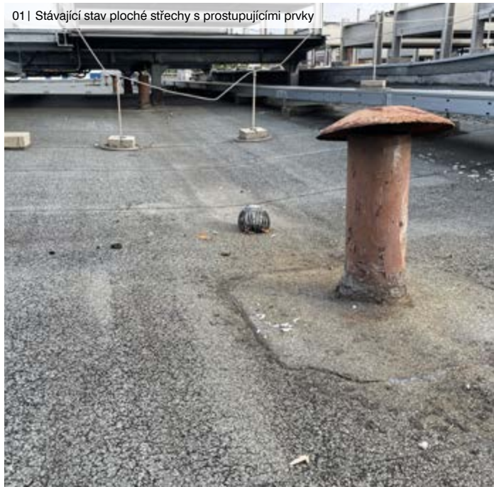
01 | Stávající stav ploché střechy s prostupujícími prvky
