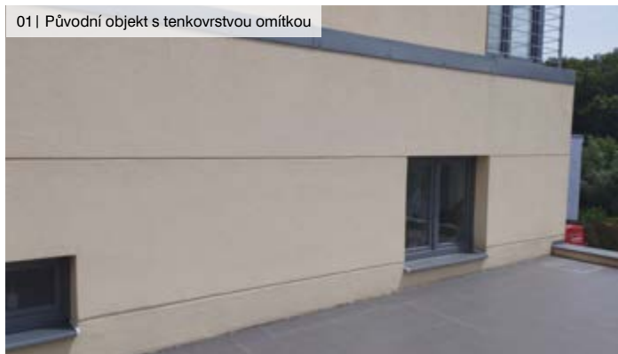
01 | Původní objekt s tenkovrstvou omítkou
