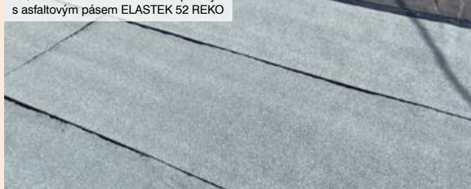
09| Pohled na obnovenou část plochy s asfaltovým pásem ELASTEK 52 REKO
