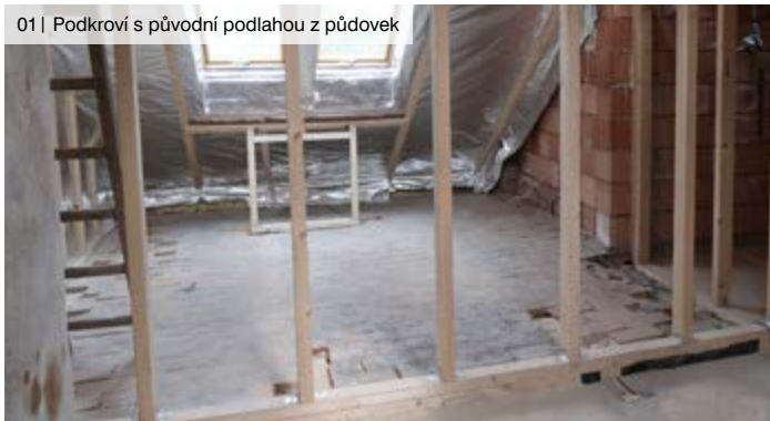
01 | Podkroví s původní podlahou z půdovek
