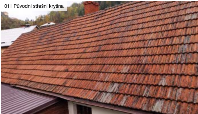
01 | Původní střešní krytina
