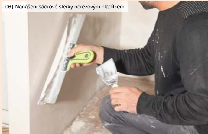
06 | Nanášení sádrové stěrky nerezovým hladítkem
