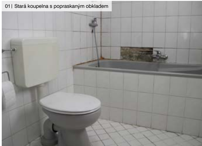
01 | Stará koupelna s popraskaným obkladem
