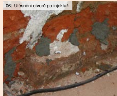
06 | Utěsnění otvorů po injektáži
