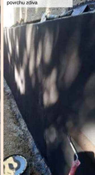
06 | Penetrace vyrovnaného povrchu zdiva
