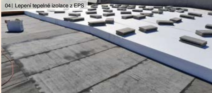
04| Lepení tepelné izolace z EPS
