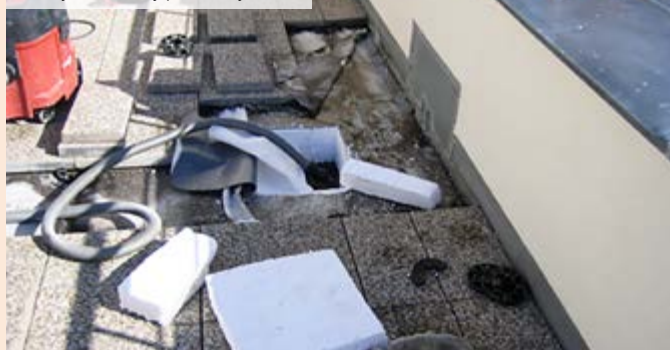
05| Pohled do otevřeného komínku s viditelnou vodou ve skladbě střešního pláště
