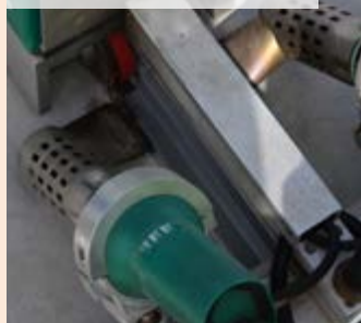
04| Svařování automatem profilu ALKORSOLAR k fólii DEKPLAN 76
