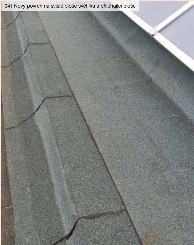
04| Nový povrch na svislé ploše světlíku a přiléhající ploše
