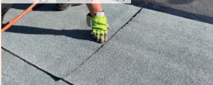
06| Důkladné provaření a přitlačení příčného spoje
