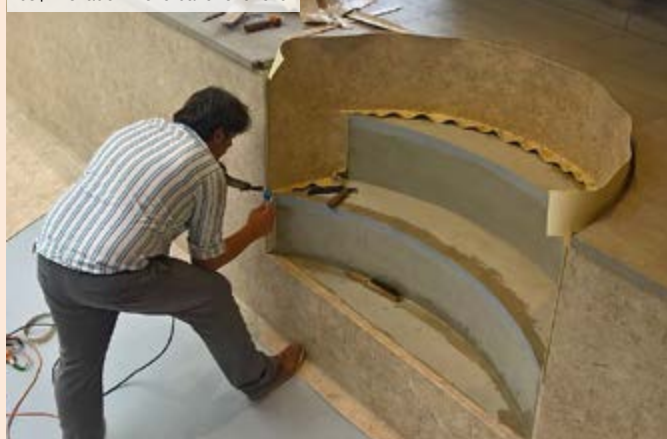
03 | Provádění nové bazénové fólie
