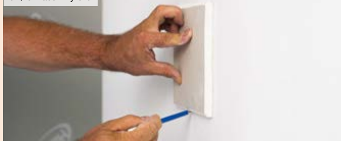
03 | Vyříznutí poškozené části sádrokartonové desky
