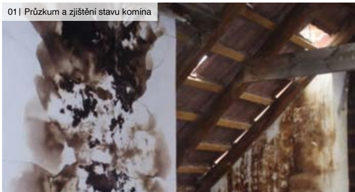
01 | Průzkum a zjištění stavu komína
