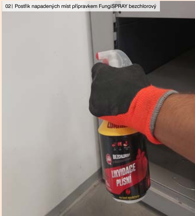
02 | Postříkání napadených míst přípravkem FungiSPRAY bezchlorový
