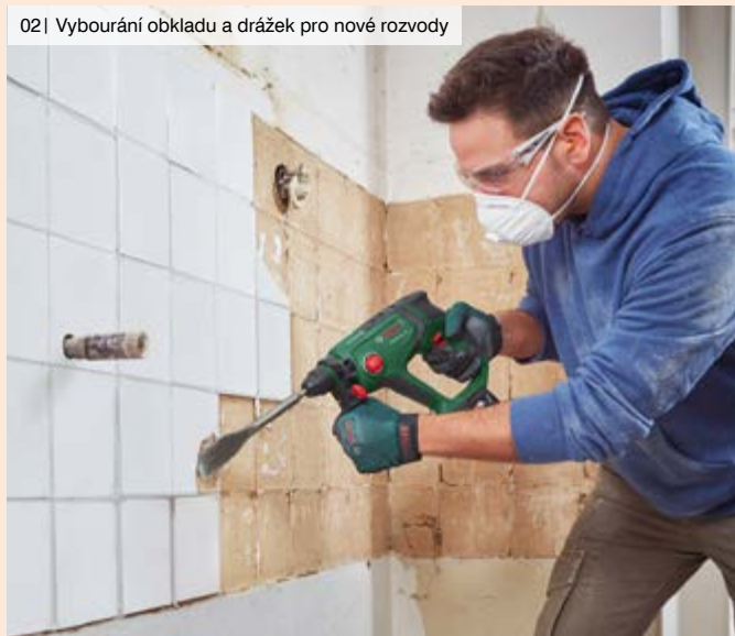
02 | Vybourání obkladu a drážek pro nové rozvody
