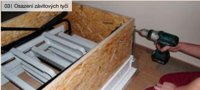
03| Osazení závitových tyčí
