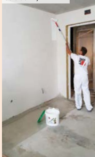
06 | Výmalba po dokončení štukové omítky
