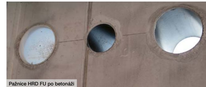
Pažnice HRD FU po betonáži
