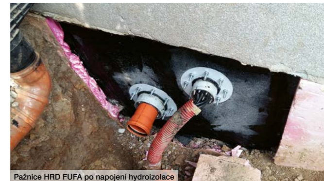
Pažnice HRD FUFA po napojení hydroizolace
