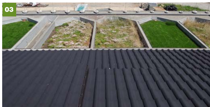
Ploché vegetační střechy na Experimentální budově
