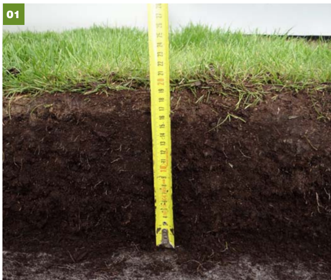
Sonda do skladby intenzivní střechy s travním kobercem po 75 dnech po realizaci
