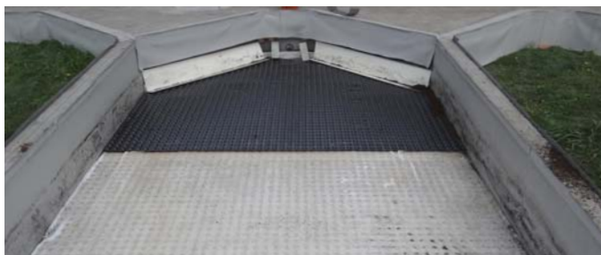
Demontáž vrstev až po filtrační textilii
