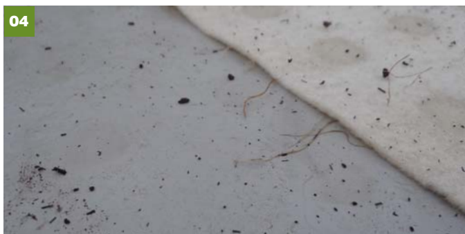
Prorůstání kořenů až k hydroizolační fólii DEKPLAN 77
