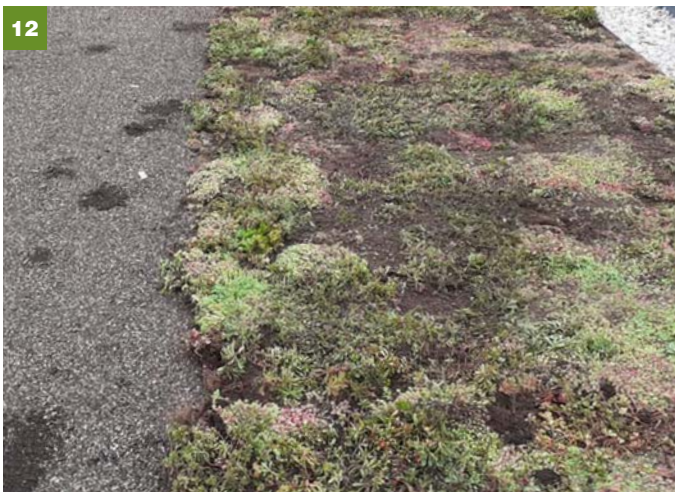
Pokládka rozchodníkových rohoží
