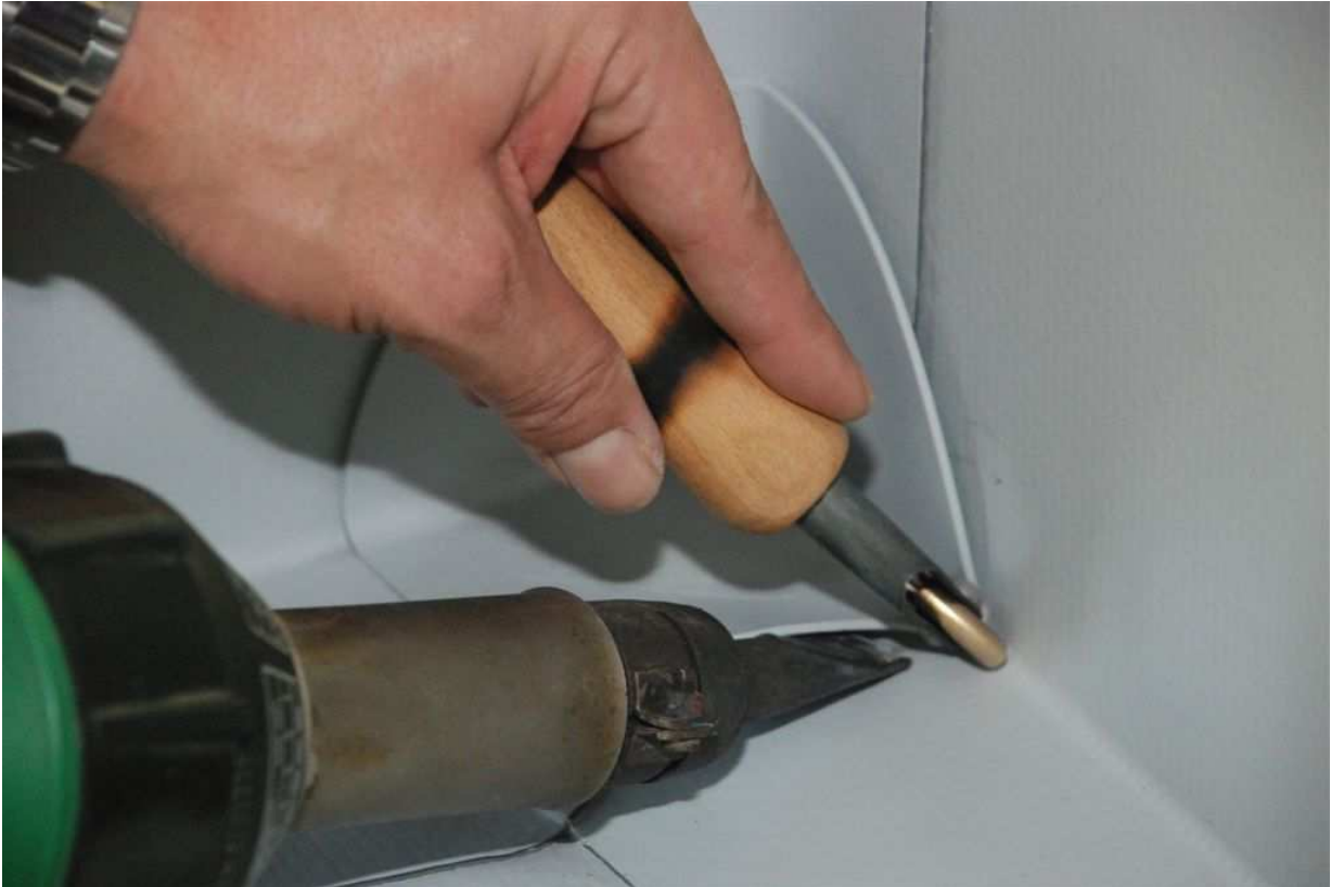
Obrázok 16: Postup opracovania hydroizolácie v kúte
