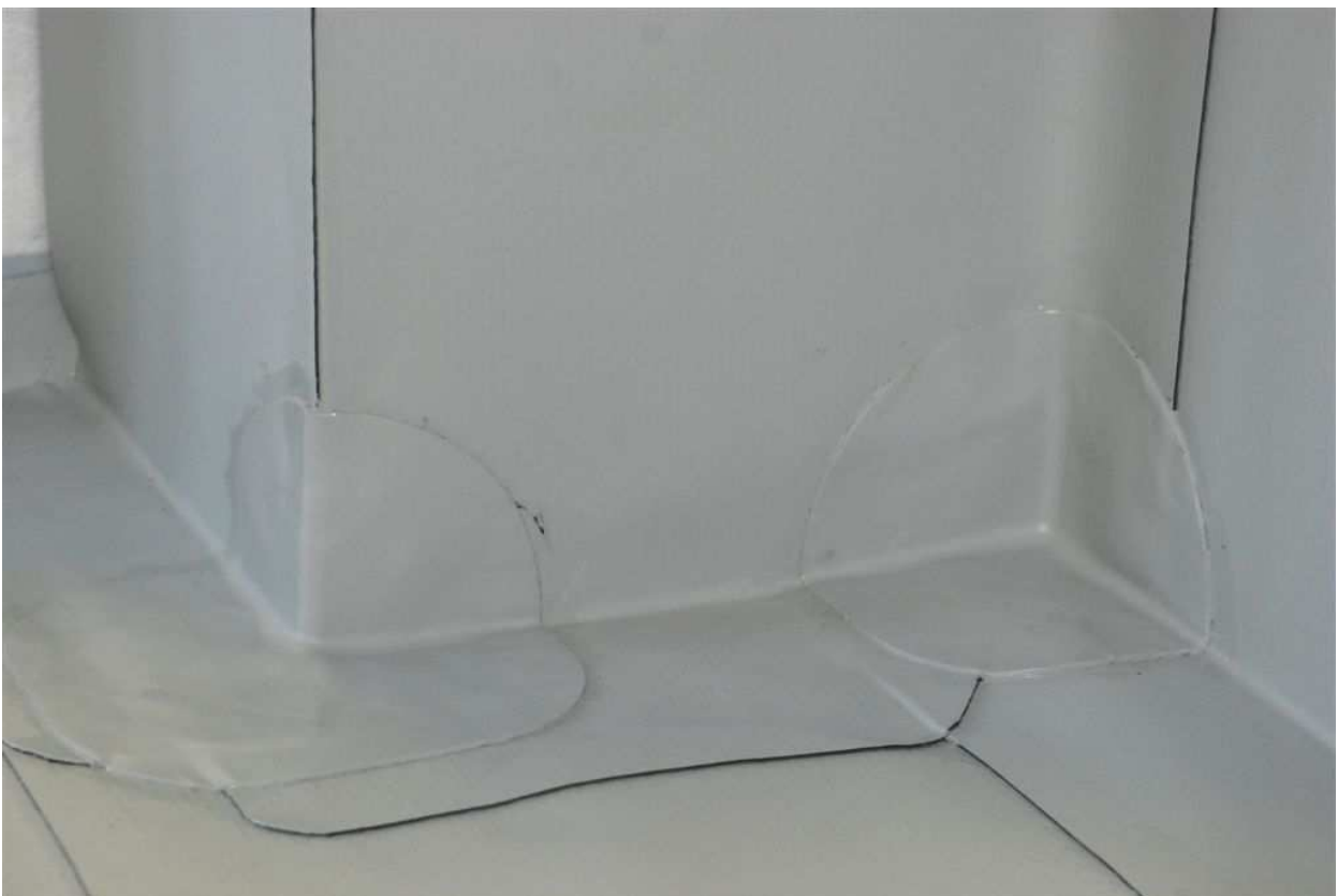
Obrázok 17: Opracovanie hydroizolácie tvarovkami v kúte a v rohu
