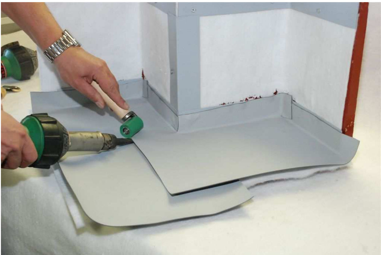
Obrázok 11: Postup opracovania hydroizolácie v rohu
