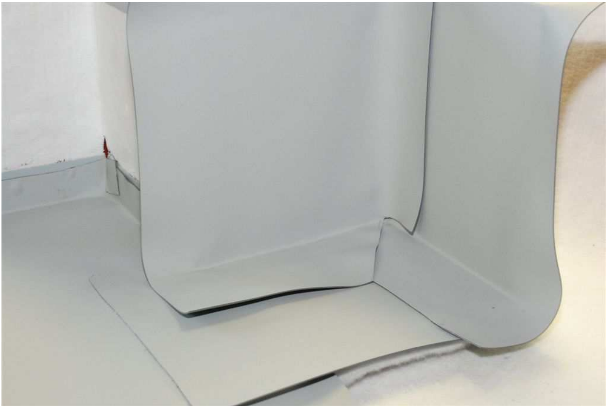
Obrázok 12: Postup opracovania hydroizolácie v kúte
