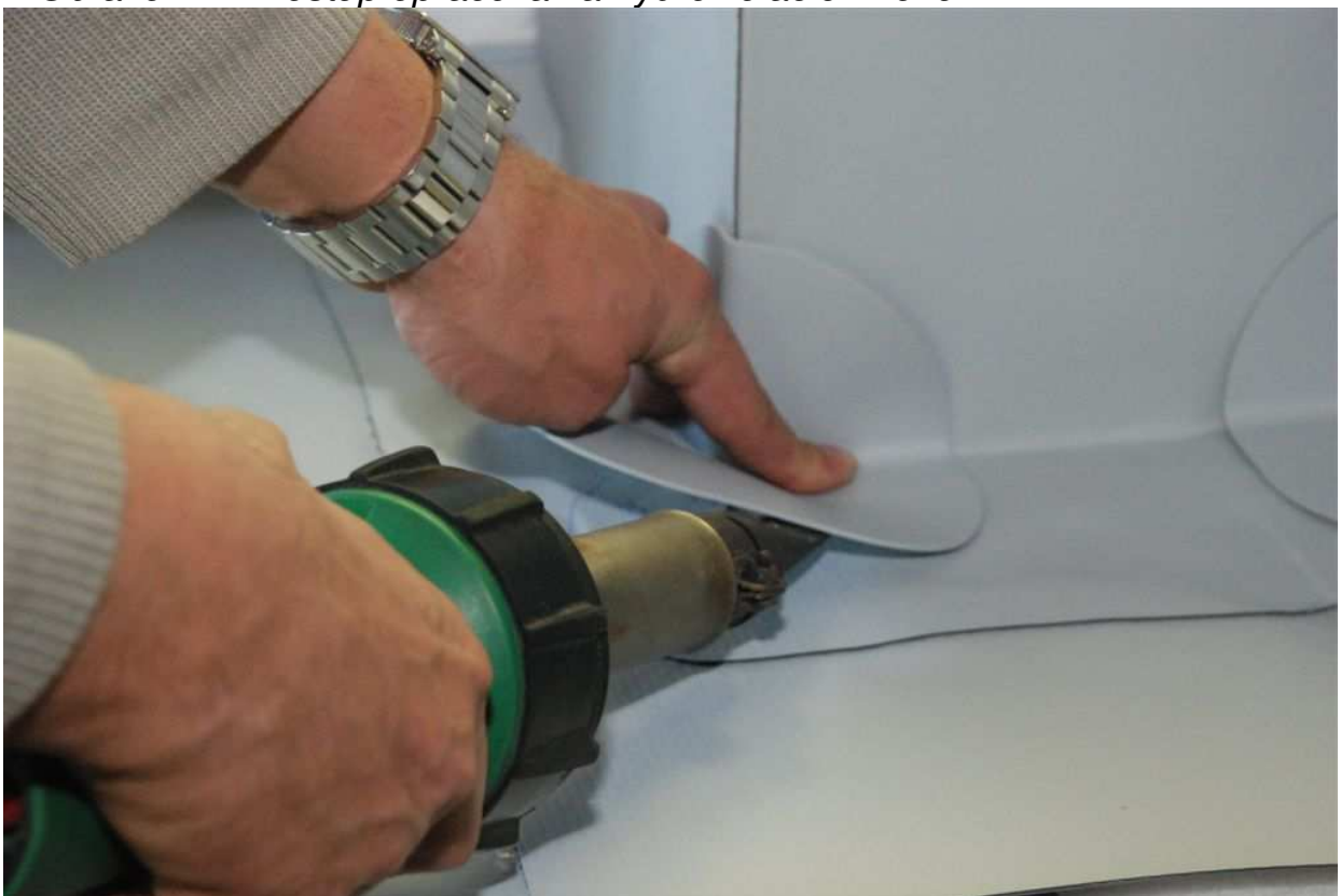
Obrázok 14: Postup opracovania hydroizolácie v rohu
