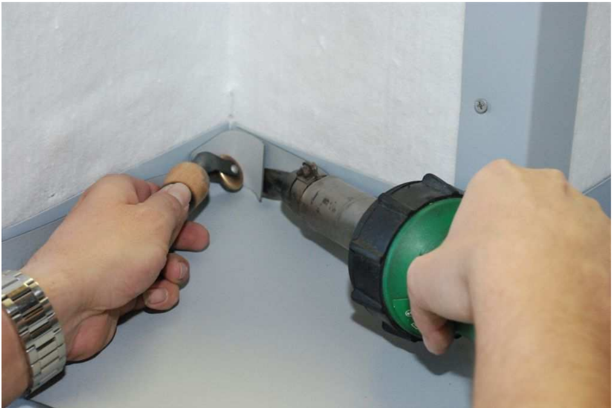
Obrázok 10: Postup opracovania hydroizolácie v kúte
