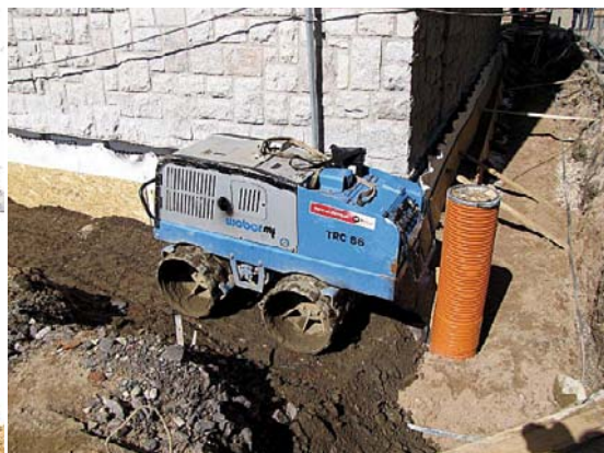
09| ... jinde vibračním válcem na dálkové ovládání.
