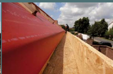
06 | Konstrukce žlabu z dřevostěpkových desek
