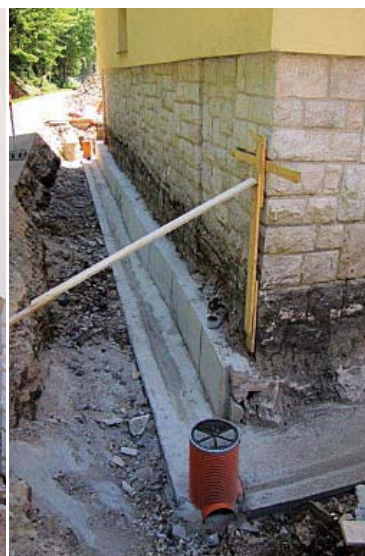
07| Úprava obnažené stěny základu přibetonováním, betonáž podkladního lože drenážního pera v definovaném spádu, na který se provádí drenážní pero z flexibilního drenážního potrubí a šterkového obsypu. V popředí kontrolní a čistící šachtice drenážního pera (osazuje se v místě každé změny směru nebo výškové úrovně)
