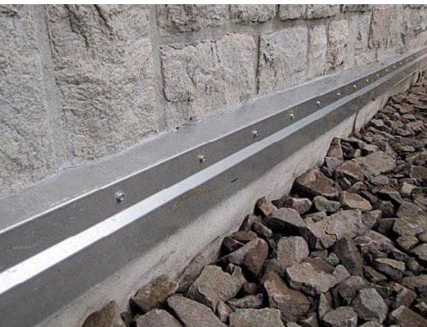
16| Rozpracovaný detail ukončení hydroizolace v úrovni terénu. Jedná se o překrytí nerezovým plechem tl. 1mm zasunutým do vyfrézované drážky v žulové podezdívce. Pohled na detail těsně před dokončením, kdy bude dosypáno prané říční kamenivo do úrovně spodní hrany plechu
