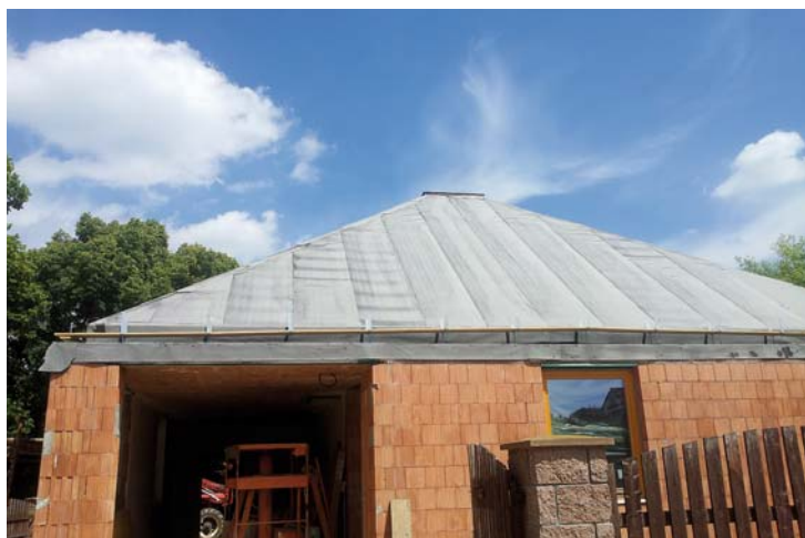
01 | Položení parozábrany TOPDEK AL BARRIER na záklop z dřevostěpkových desek
