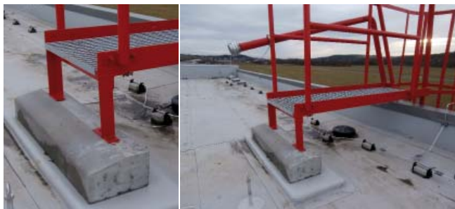
08| Osazení bet. prefabrikátu na hydroizolace u požárního zebříku s ukázkou jeho finální podoby na střeše
