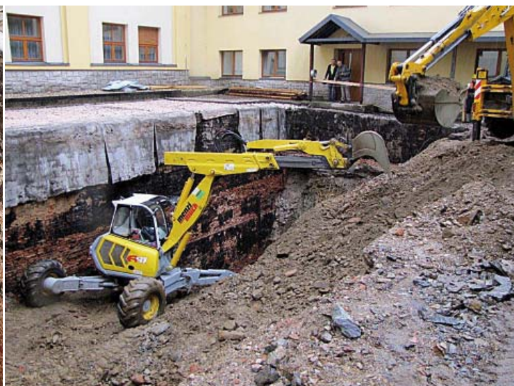
11| Stroje pracující v taktu s mezideponií
