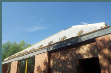
05 | Doplnění detailu pod žlabem tepelnou izolací
