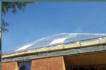
06 | Konstrukce žlabu z dřevostěpkových desek
