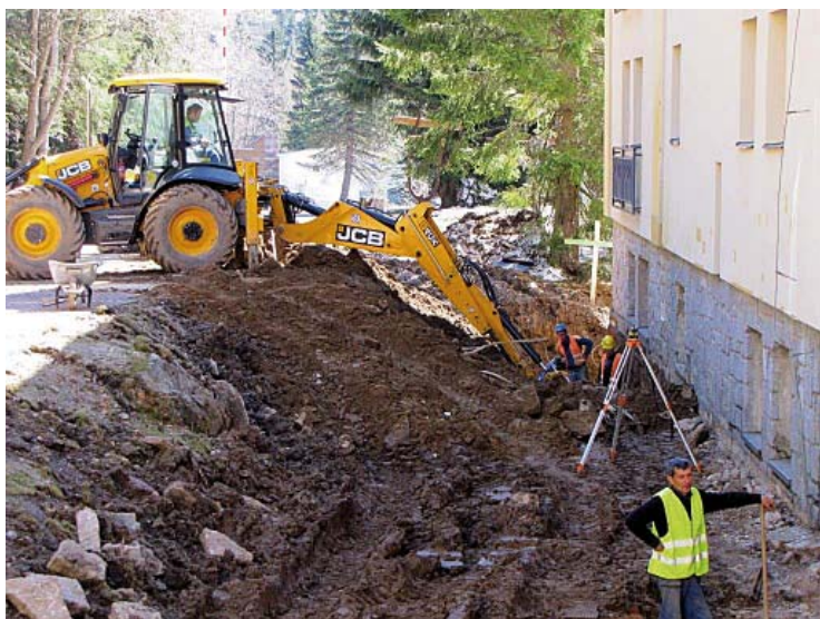
06| Výkop mělké drenáže do hloubky dosažitelné běžnou mechanizací
