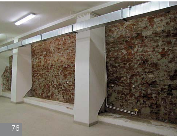
18| Zdivo spodní stavby při vysoušení, povrchová úprava železobetonových pilířů byla zachována. Po vysoušení na přípustnou mez byla aplikována skladba sanační omítky
