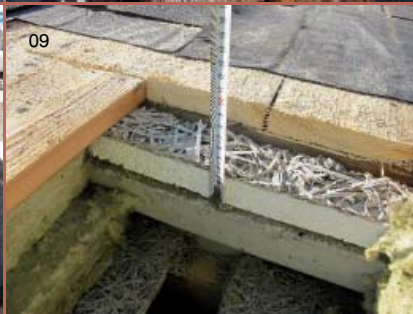
07 | Skladba šikmé střechy (foto z odstraňování původních vrstev)
