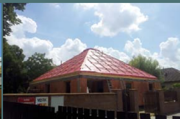
07 | Vyrojení žlabu fólií z měkkého PVC
