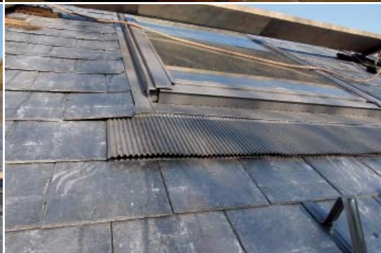
11| Detail napojení střešního okna
