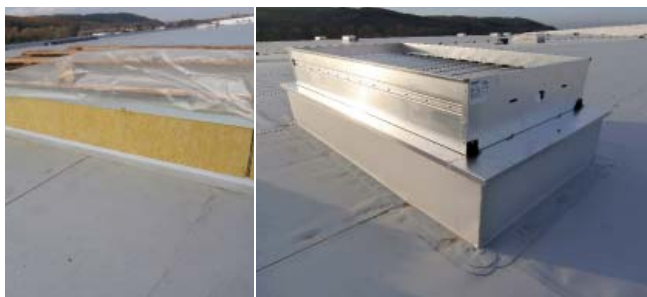
06| Ukončení hydroizolace na ventilátoru s ukázkou jeho finální podoby na střeše
