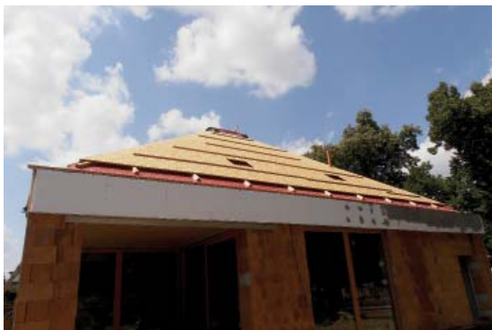
08| Plnoplošné bednění dřevoštěpkovou deskou jako podklad pro skládanou krytinu
