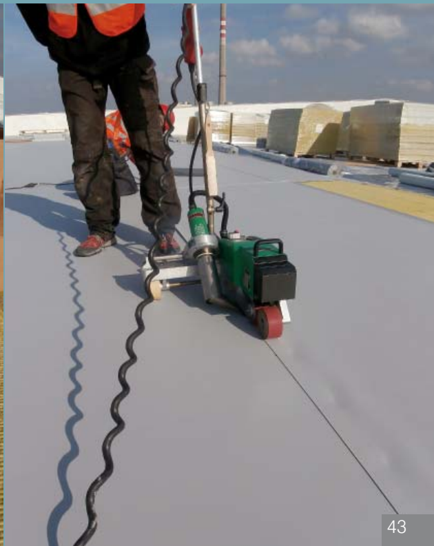
04 | Svařování hydroizolační vrstvy DEKPLAN 76 svařovacím automatem
