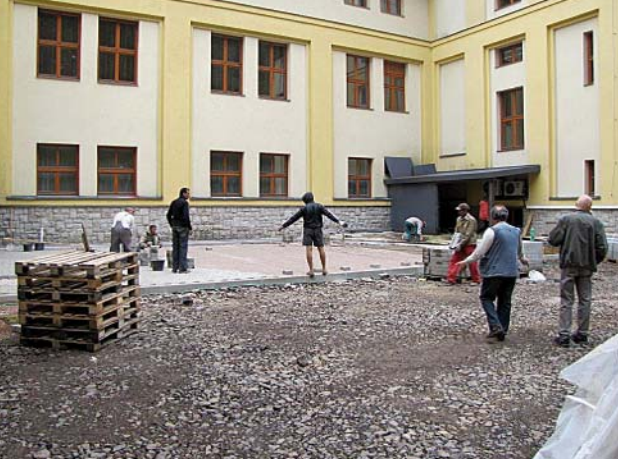
14| Pokládka drenážní smyčkové rohože pojižděné skladby stropu nad 1.PP
