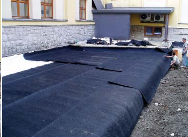
15| V pozadí pokládka dlažby do podsypu ve skladbě pojižděné střechy, v popředí hutněný podklad pro asfaltobetonový kryt dvora na koruně záspy hluboké úrovně drenáže
