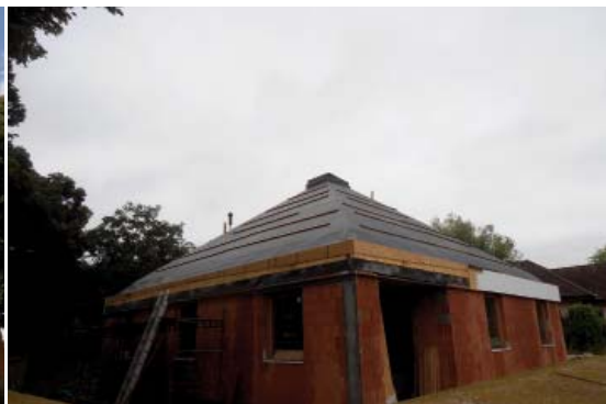
09| Podkladní asfaltový pás ROLL BASE pod břidličnou krytinu
