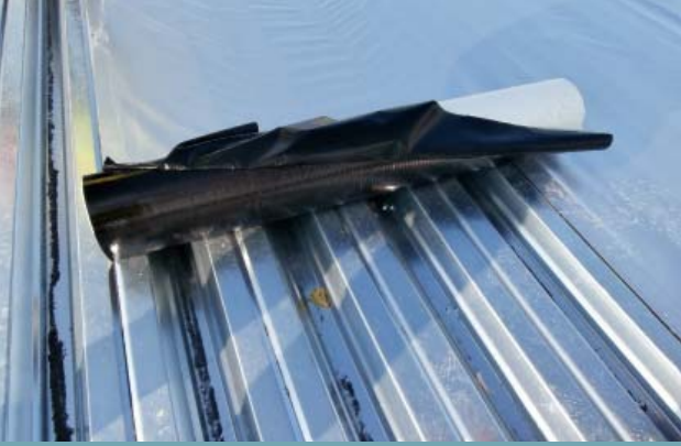
01 | Realizace parozábrany ze samolepícího SBS pásu
