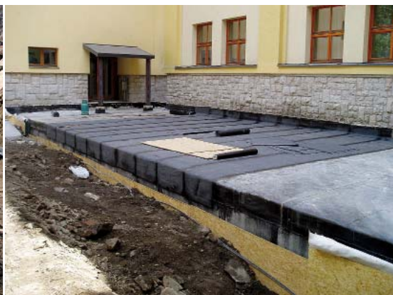
13| Hydroizolace pojižděné střechy 1.PP plynule navazující na svislou hydroizolaci spodní stavby. S výhodou užito stejné materiálové báze
