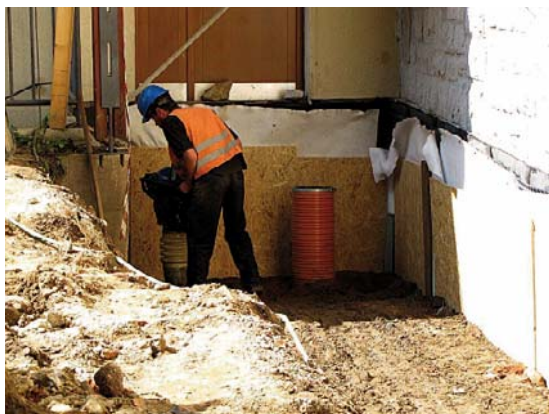
08| Hutnění zásypu po vrstvách, v nepřístupných místech vibrační deskou ...
