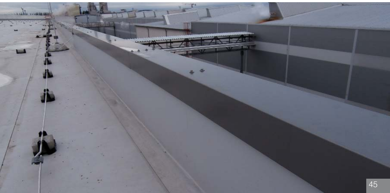
10| Pohled na hotovou střechu
