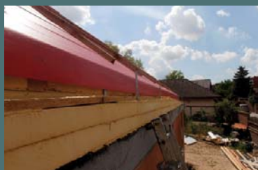
05 | Doplnění detailu pod žlabem tepelnou izolací
