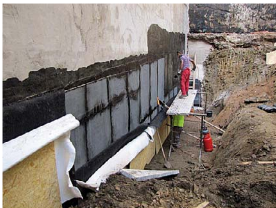
12| Natavování asfaltových pásů po záběrech na omítnutý a penetrovaný podklad, vespod již ochrana OSB deskou a hutněný zásyp. Ve hloubkách pod 4m je nutné svislou drenážní vrstvu provést z prostorové smýčkové ohože ve 2 vrstvách, nopová fólie by se tlakem zborčila, případně by poškodila asfaltové pásy
