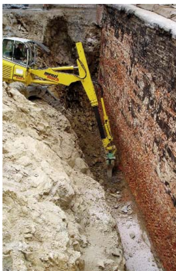
10| Lámání skály při provádění výkopu pro hlubokou drenáž
