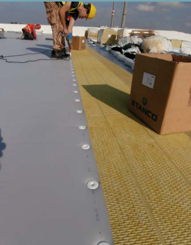
03 | Kotvení hydroizolační vrstvy DEKPLAN 76
