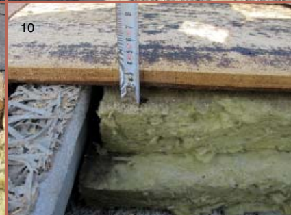
07 | Skladba šikmé střechy (foto z odstraňování původních vrstev)
