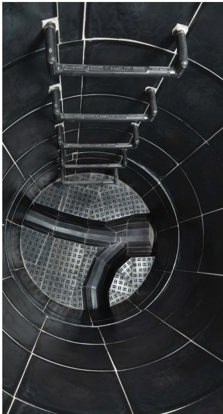
Vnitřní obklad spadišťové šachty čedičem
