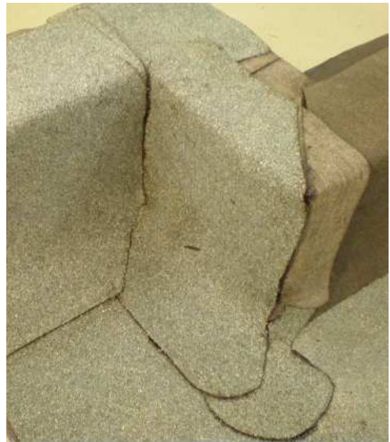
Obrázok /13/ Natavenie kútovej tvarovky 4b upravenej z prava na tvar rohovej tvarovky 2b a natavenie kútovej tvarovky 4a, obe s posypom
