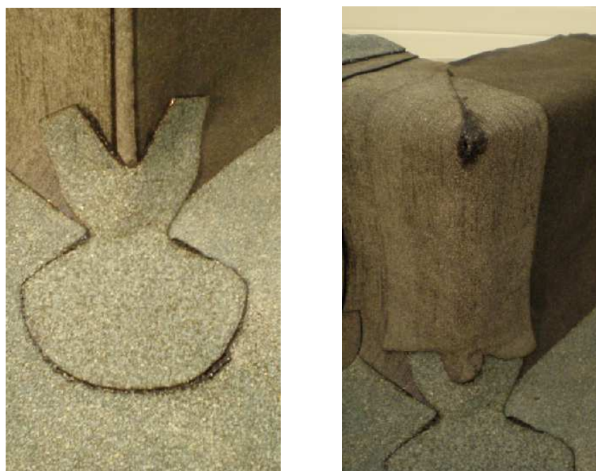
Obrázok /12/ Natavenie univerzálnej tvarovky 3 s posypom a univerzálnej tvarovky 4 bez posypu (pri nedokonalom tvare podkladu vonkajšieho rohu doporučujeme použiť univerzálnu tvarovku 4 s posypom pre uľahčenie napojenia rohových tvaroviek 2a a 2b)
