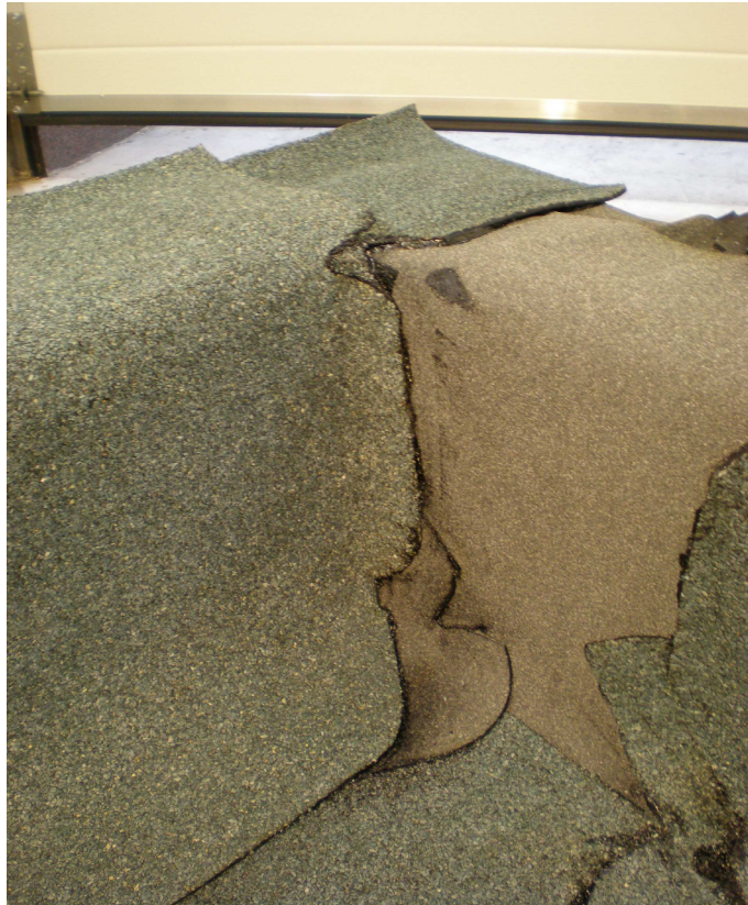
Obrázok /25/ Natavenie upraveného asfaltovaného pásu s posypom privedeného po atike k detailu vnútorného kútu
