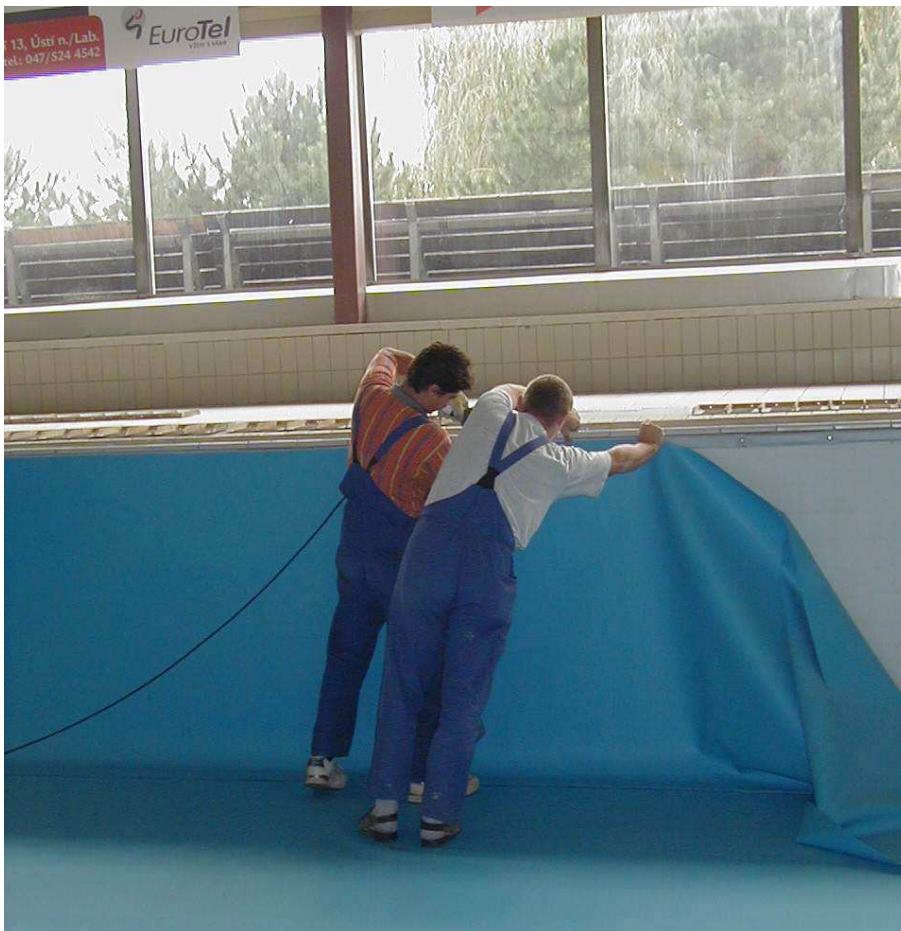
Foto 5. Realizácia steny bazéna.
