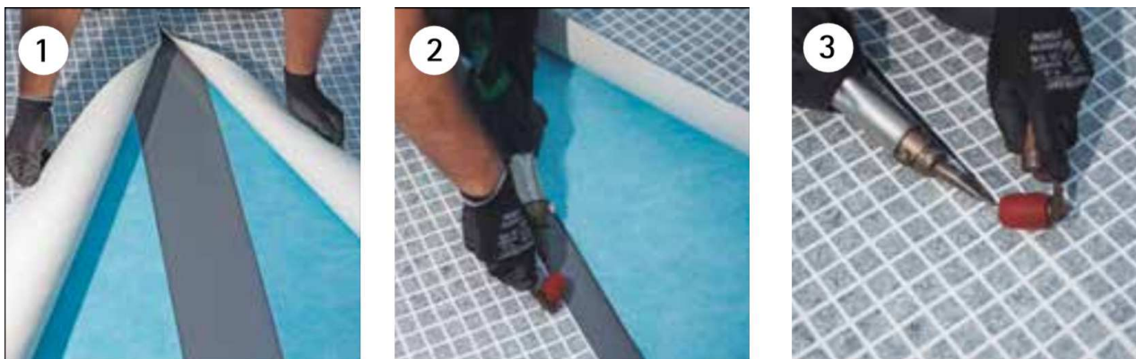
Foto 2. Natavenie fólie CERAMICS na spojovaciu pásku.
