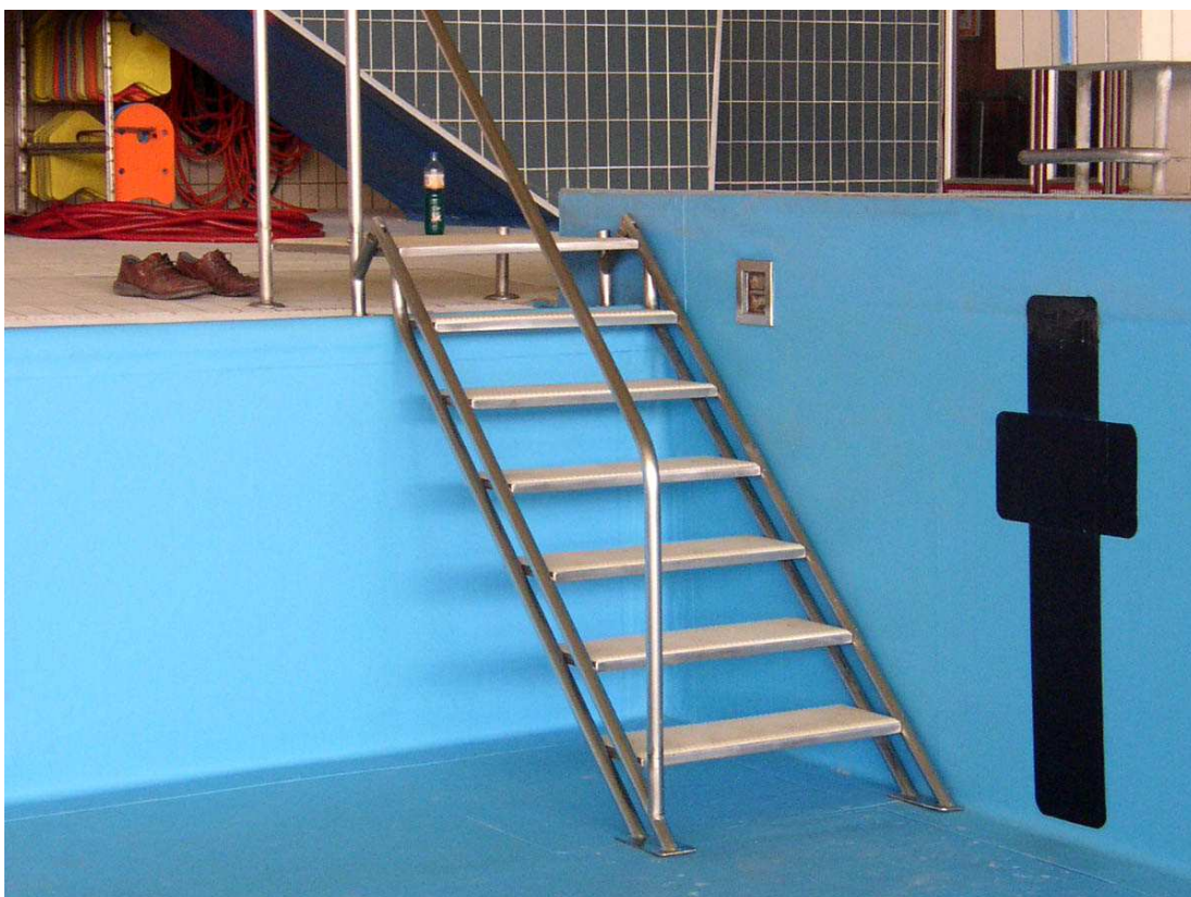
Foto 22. Verejný bazén Ústí nad Labem – prístupové schodisko.
