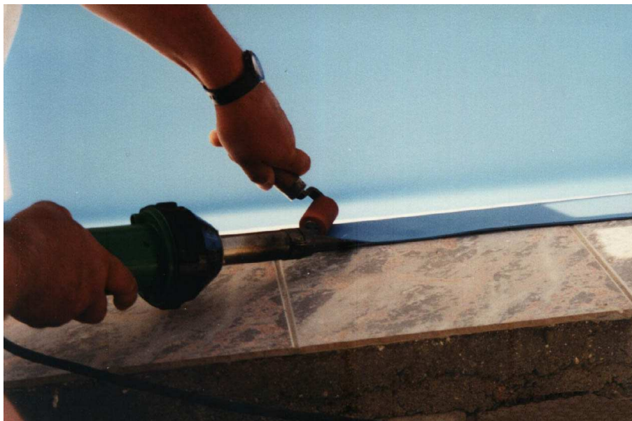
Foto 1. Navarenie fólie na profil z poplastovaného plechu.
