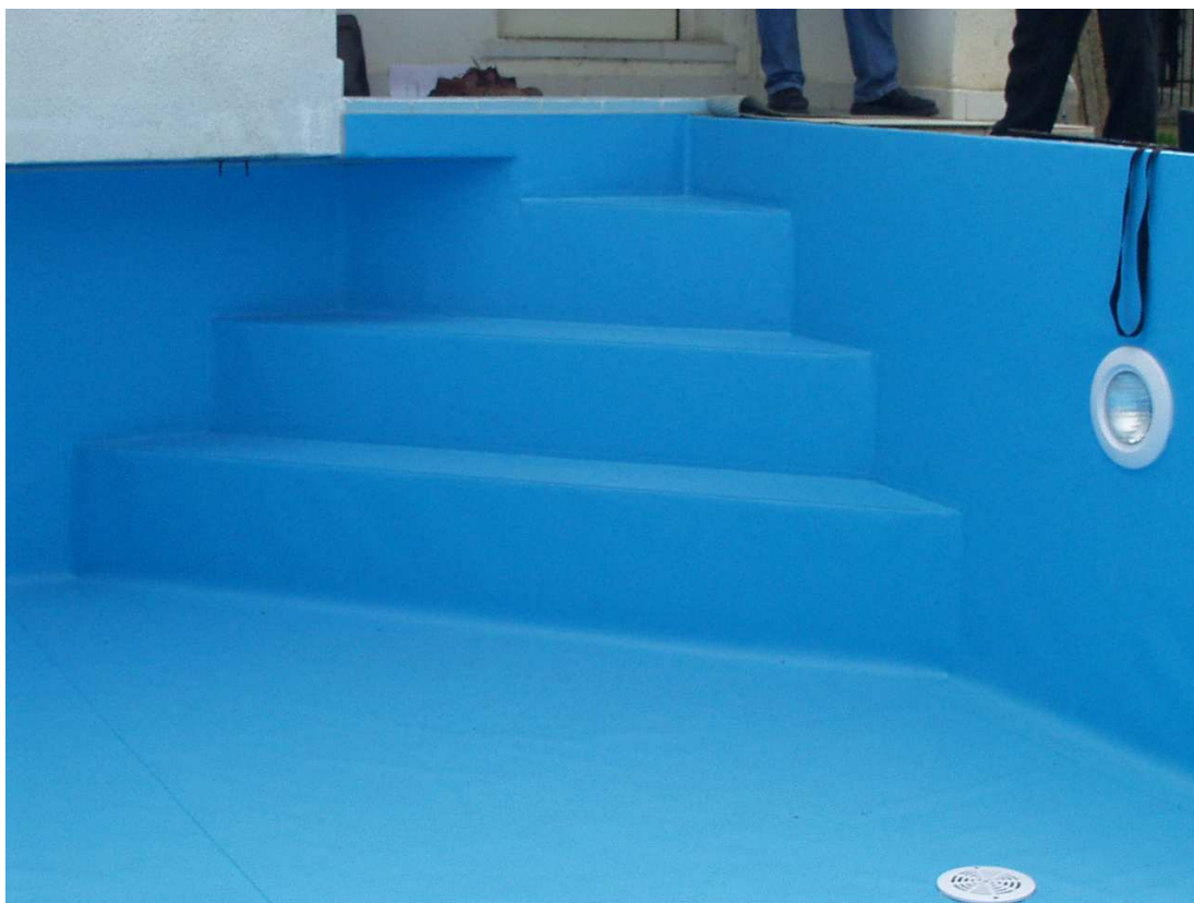
Foto 26. Rodinný bazén – Letňany – přístupové schodisko.
