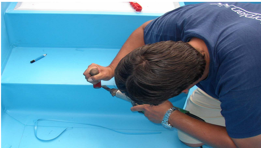
Foto 17. Zaočenie strihaného okraja fólie na hrane schodu.
