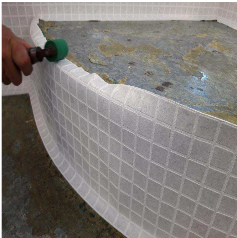
Foto. 14 Prilepenie fólie s prítlakom valčeka.
