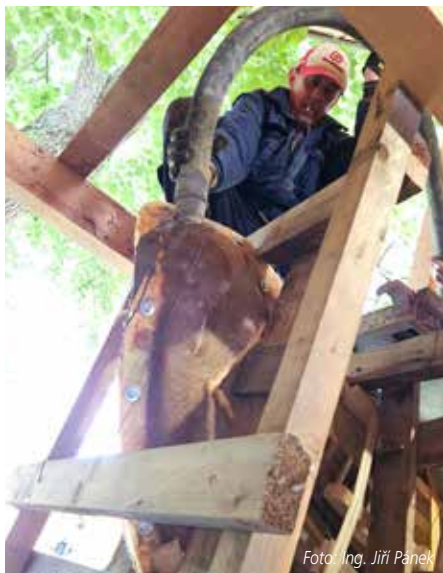
Obr. 2 – Připravené bednění před uložením betonu
