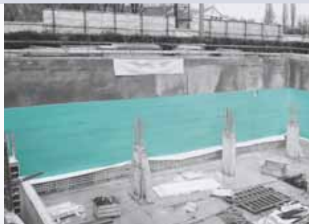
Pripevnenie tepelnej izolácie na múr stavebnej jamy v centre mesta FIBRANxps 300-L
