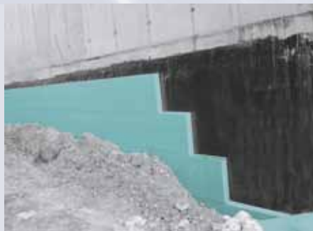
FIBRANxps 300-L, mechanická ochrana hydroizolácie a súčasne tepelná izolácia pivničných priestorov.
