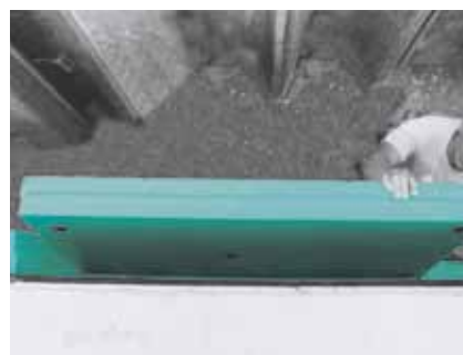
Lepenie dosky FIBRANxps 300-L na hydroizolačnú membránu s lepiacimi vankúšikmi FIBRANstick
