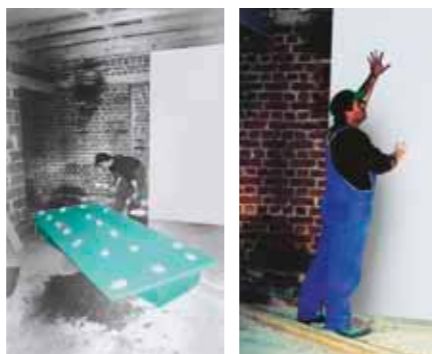
FIBRANxps FABRIC Vnútna izolácia kombinovaná sádkokartónovou doskou
