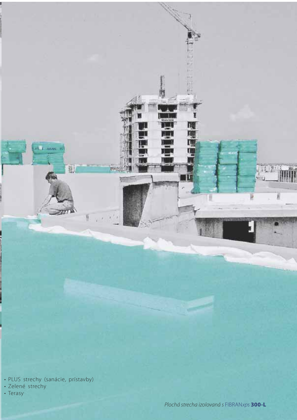
Záhrada na terase (princíp obrátejnej strechy) FIBRANxps 300-L
