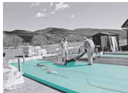
FIBRANxps 400-L Tepelná izolácia základov nízkoenergetického obytného domu
