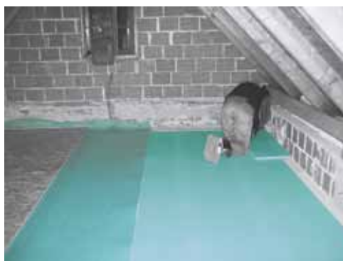
Suchomontážna podlaha podkrovia, tepelná izolácia FIBRANxps 300-I a FIBRANxpe ako izolácia krokového zvuku
