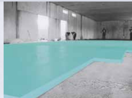
FIBRANxps 300-L, tepelná izolácia podlahy v sklade.
