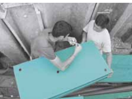
Lepenie dosky FIBRANxps 300-L na hydroizolačnú membránu s lepiacimi vankúšikmi FIBRANstick
