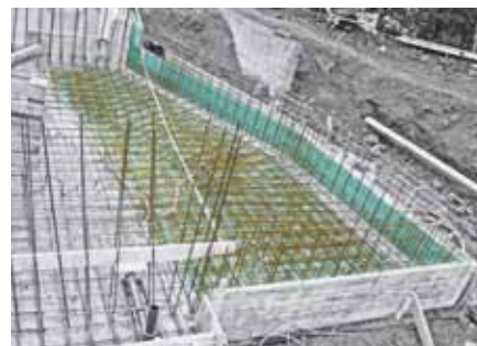
FIBRANxps 400-L Tepelná izolácia základov bazénu
