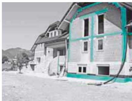
Izolácia tepelných mostov, väzníky, väzné trámy proti zemetraseniu, použitím FIBRANxps ETICS
