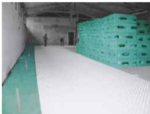
FIBRANxps 300-I tepelná izolácia pod podlahové kúrenie
