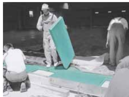
Tepelná izolácia vysoko zaťaženej podlahy FIBRANxps 500-L
