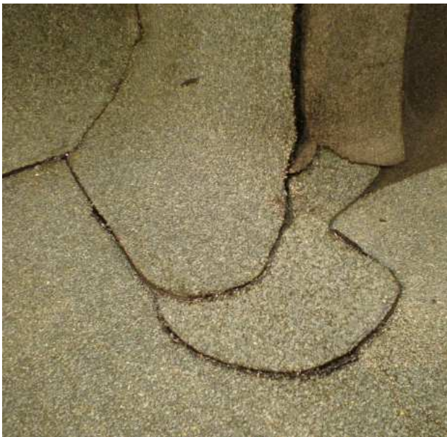
Obrázok /14/ Detail vonkajšieho rohu a natavenie rohovej tvarovky 2a (pri použití univerzálnej tvarovky 4 s posypom nemusí rohová tvarovka 2a a 2b na seba nadväzovať)
