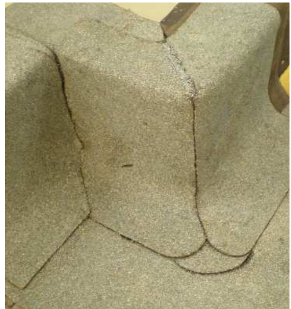
Obrázok /14/ Detail vonkajšieho rohu a natavenie rohovej tvarovky 2a (pri použití univerzálnej tvarovky 4 s posypom nemusí rohová tvarovka 2a a 2b na seba nadväzovať)
