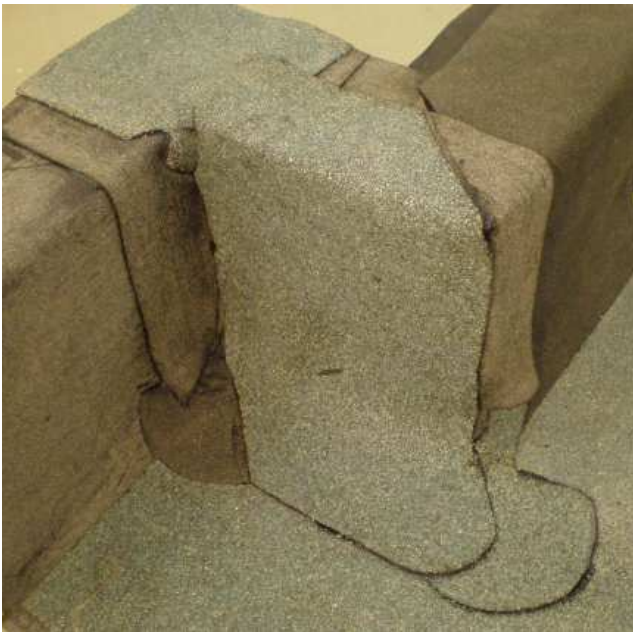
Obrázok /13/ Natavenie kútovej tvarovky 4b upravenej z prava na tvar rohovej tvarovky 2b a natavenie kútovej tvarovky 4a, obe s posypom
