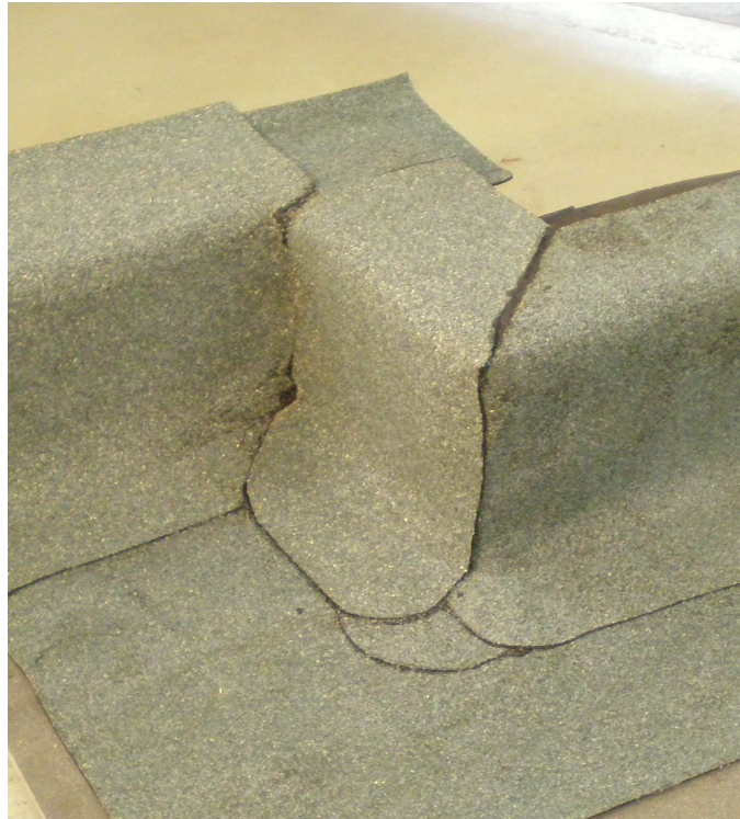
Obrázok /27/ Dokončenie detailu vnútorného kútu a vonkajšieho rohu
