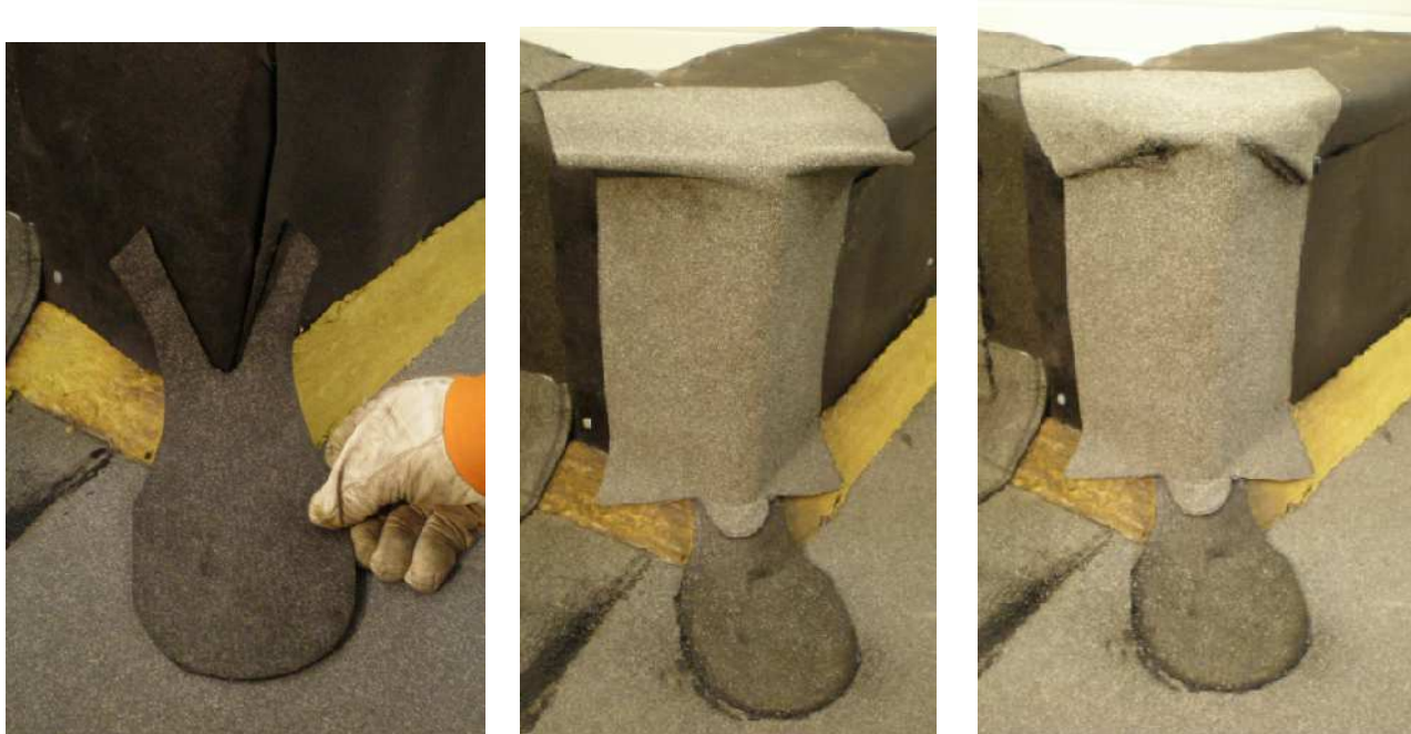
Obrázok /9/ Natavenie univerzálnej tvarovky 1 a 2
