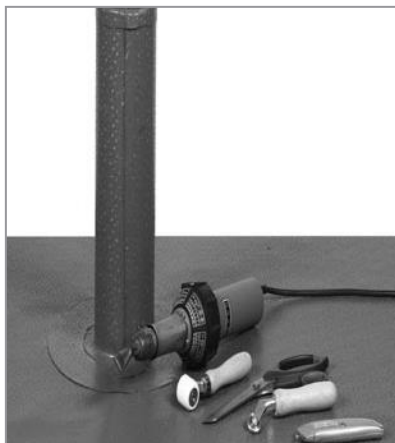
30. Dokončené zakryté potrubie
