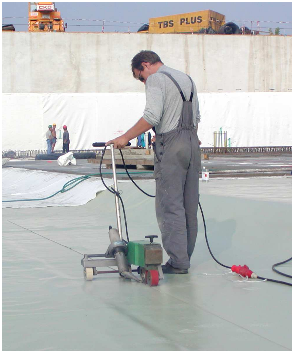
Foto 3. Práca so zváracím automatom LEISTER VARIMAT.
