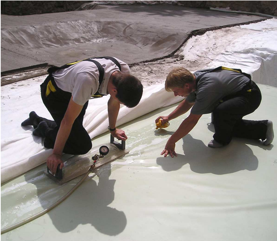
Foto 9. Skúšanie tesnosti spojov vákuovou skúškou.
