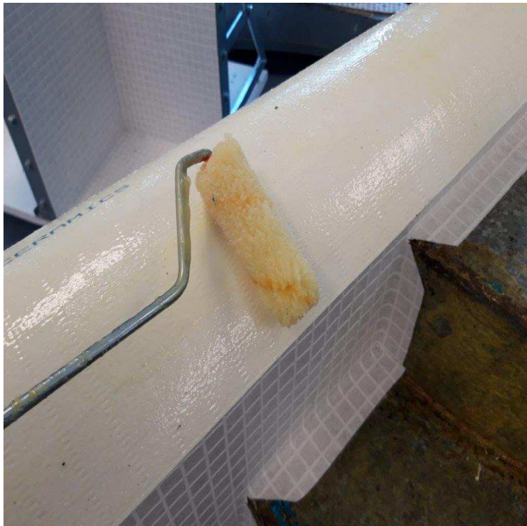
Foto 12. Nanášanie lepidla na fóliu.
