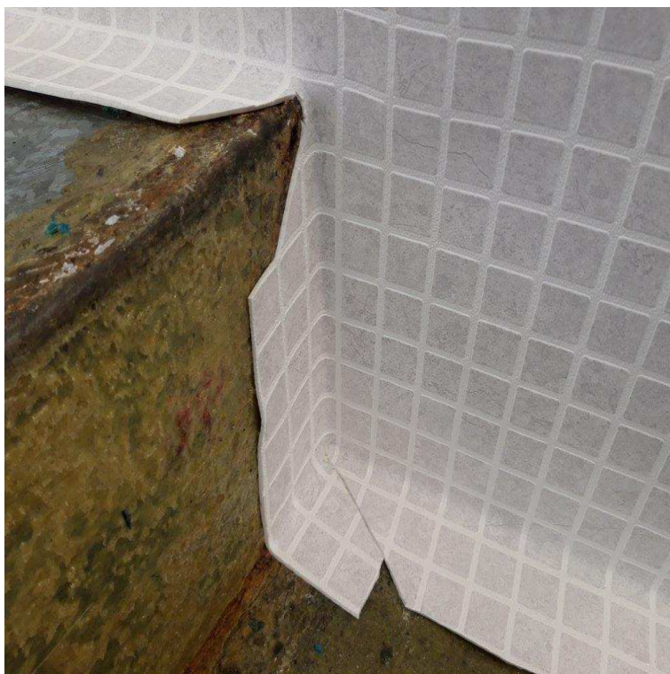
Foto 9. Zvarenie fólie v detaile.
