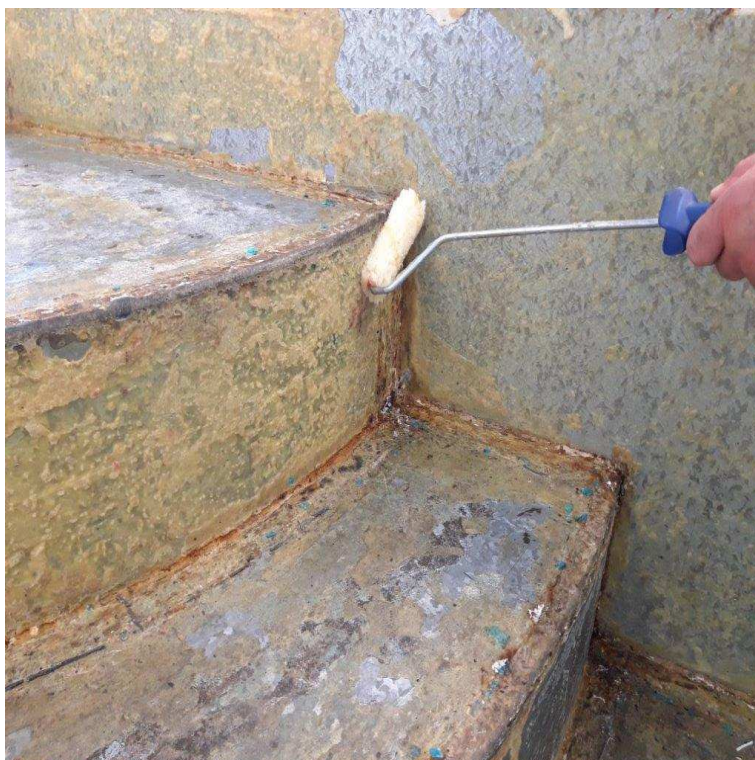
Foto 7. Nanášanie lepidla na podklad.
