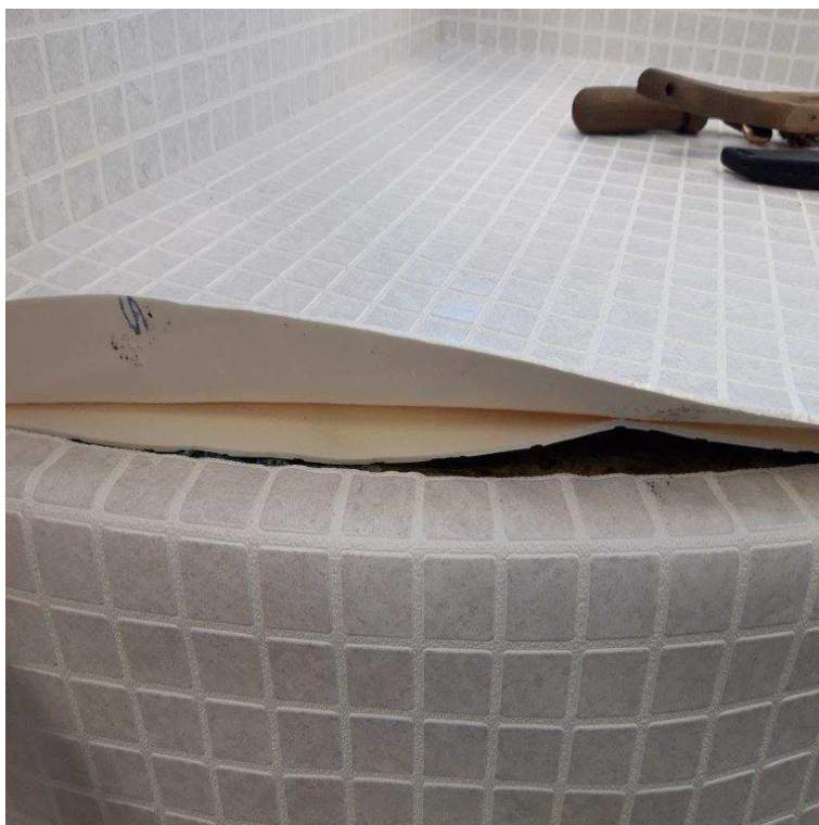
Foto 15. Pokládka fólie na stupeň s vypodložením prírezom fólie.
