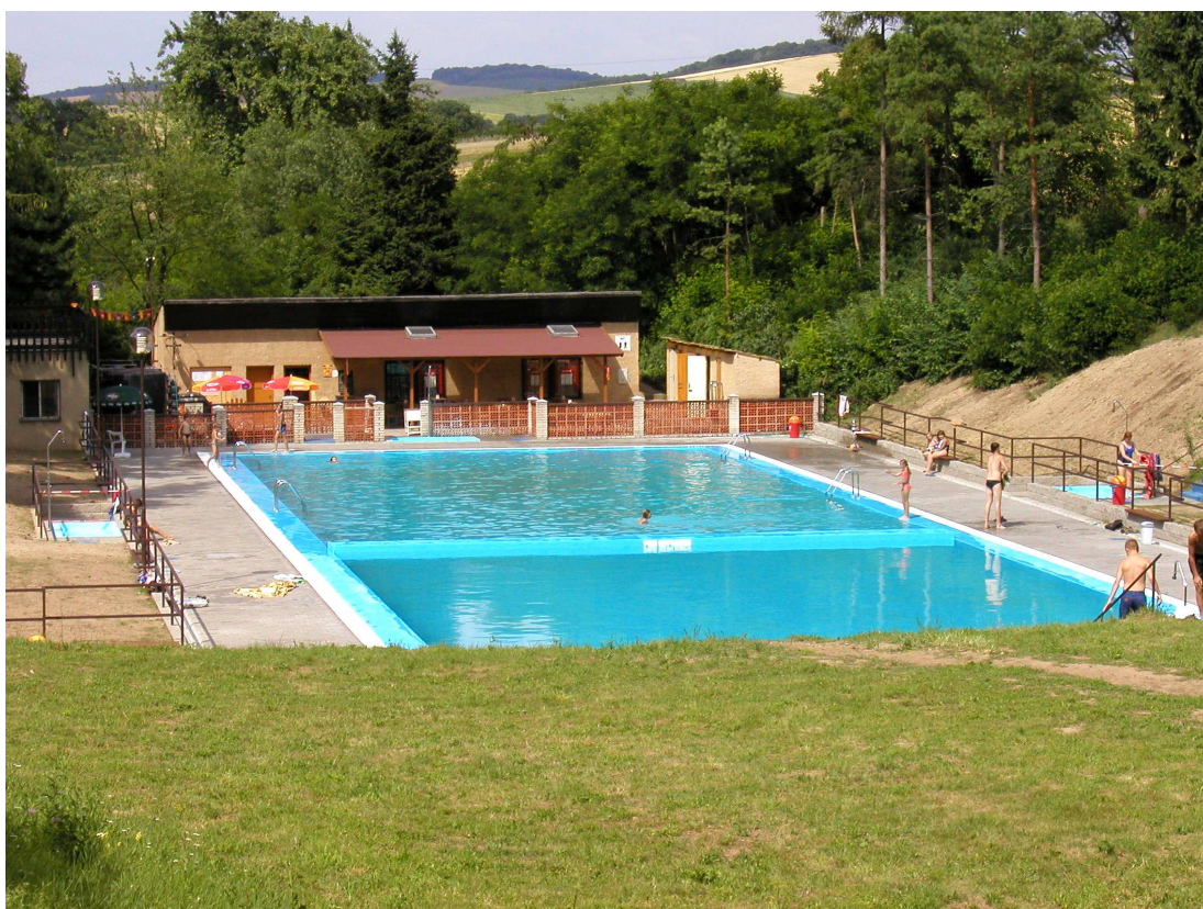
Foto 28. Verejný bazén Hodějice.
