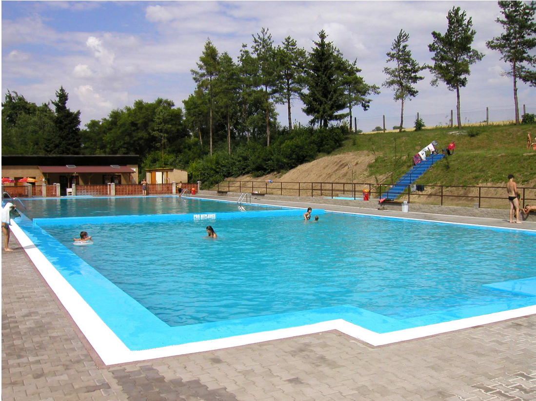
Foto 29. Verejný bazén Hodějice.
