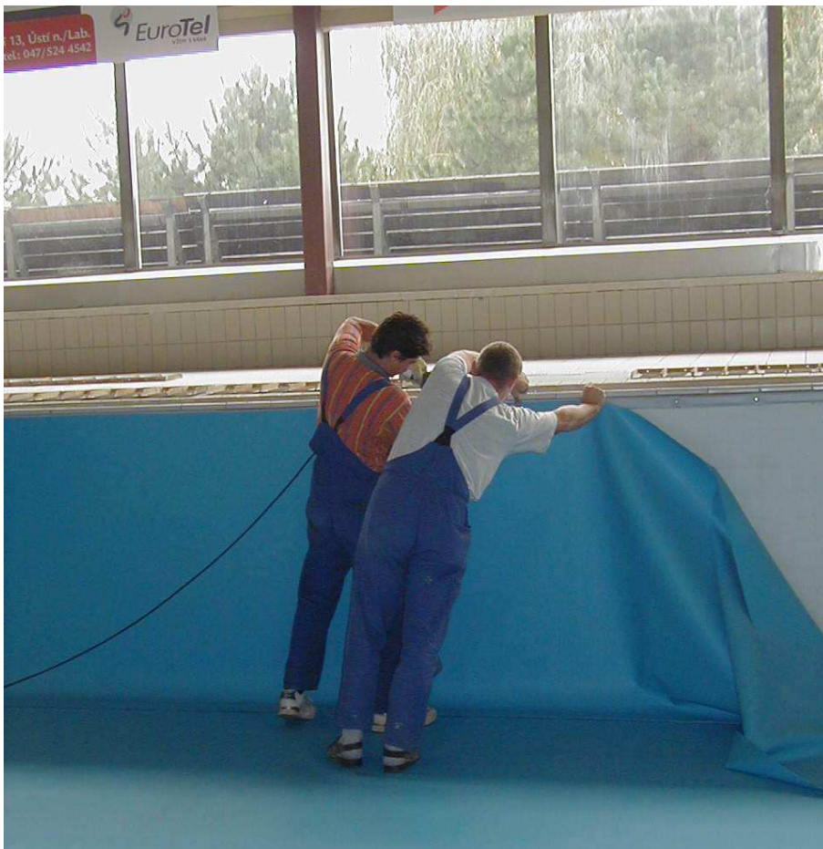
Foto 5. Realizácia steny bazéna.
