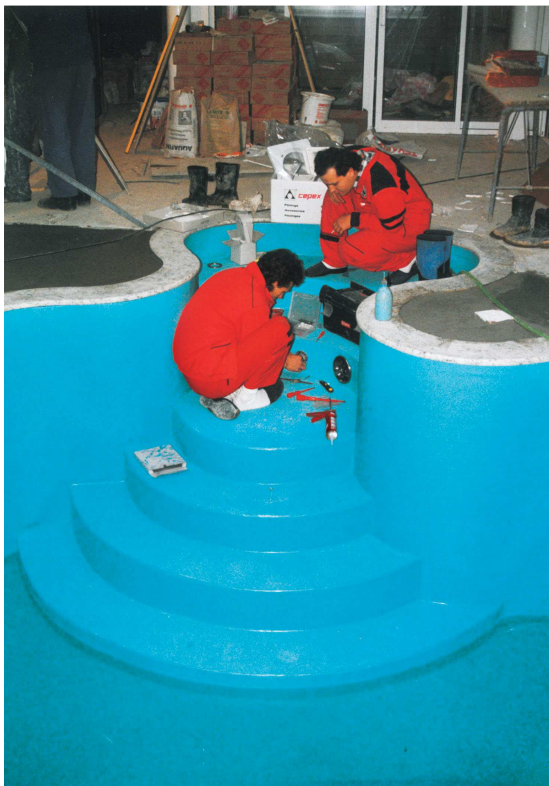
Foto 31. Realizácia schodiska – fóliou je možné riešiť aj tvarovo veľmi zložité prvky.
