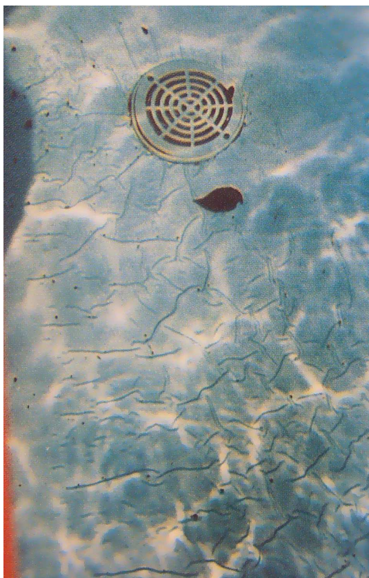
Foto 18. Zvrásnenie fólie v dôsledku nesprávneho použitia bazénovej chémie.
