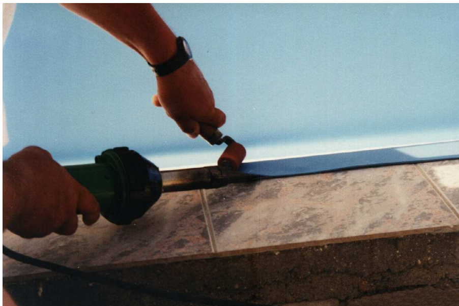
Foto 1. Navarenie fólie na profil z poplastovaného plechu.
