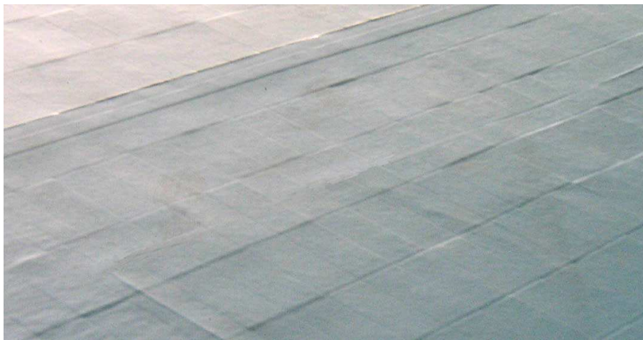
Foto 4. Prekreslenie starej dlažby na povrch fólie.
