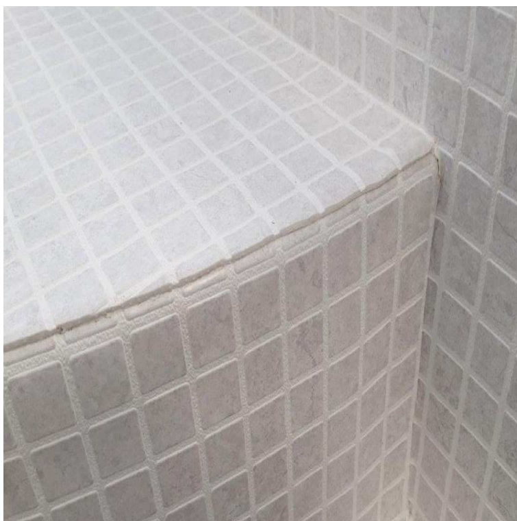
Foto 16. Pohľad na zvarený schodiskový stupeň.
