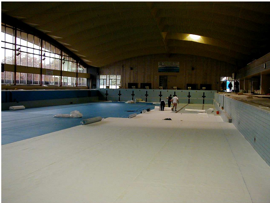
Foto 21. Verejný bazén Ústí nad Labem – realizácia dna bazéna.
