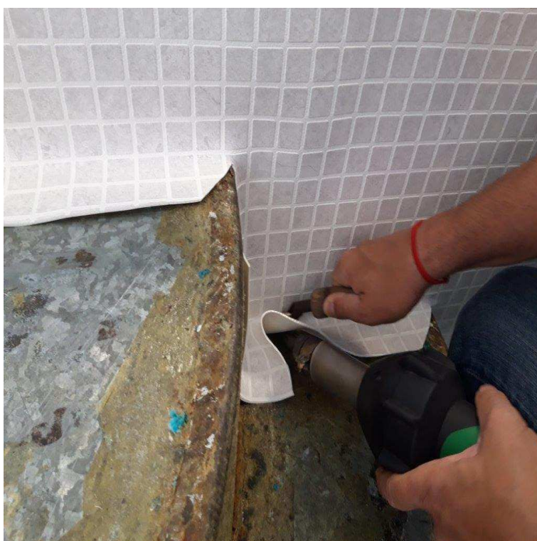
Foto 8. Privarenie fólie do hrany schodov.
