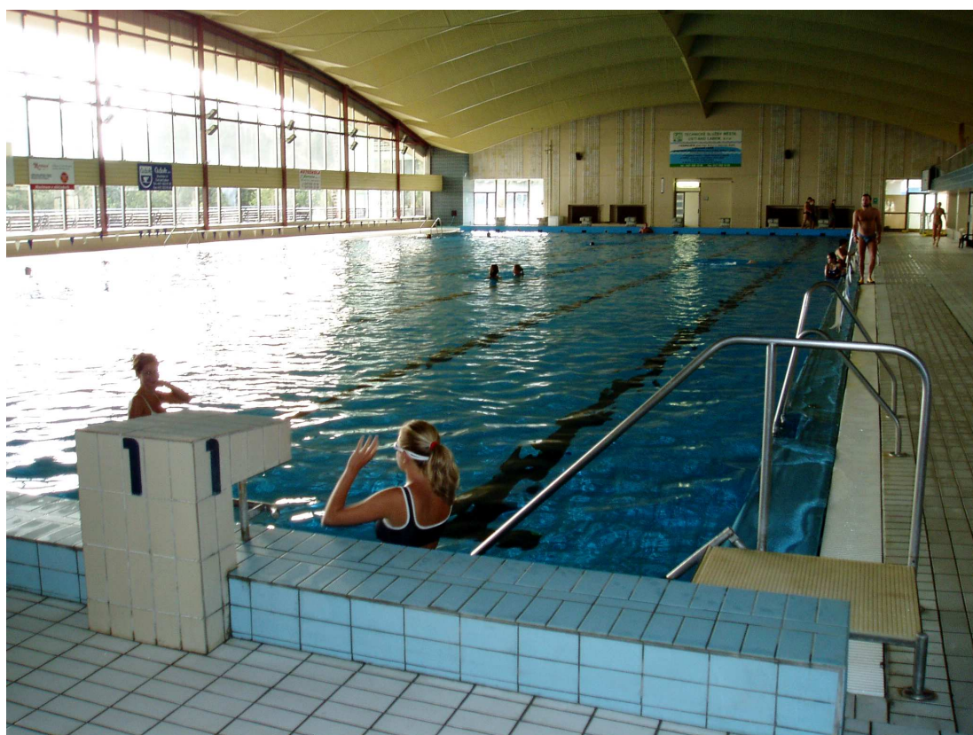
Foto 20. Verejný bazén Ústí nad Labem.
