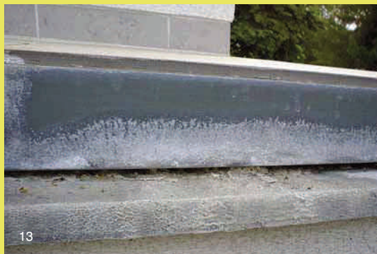
12| Skladba střechy poškozená větrem v důsledku nedostatečného kotvení tepelněizolačních desek 13| Zkorodovaná okrajová lišta na okapu terasy
