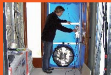
hledání netěsností anemometrem
