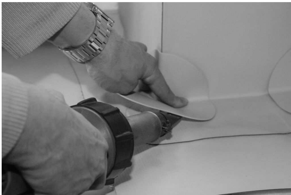
Obrázek 14.: Postup opravování hydroizolace na rohu
