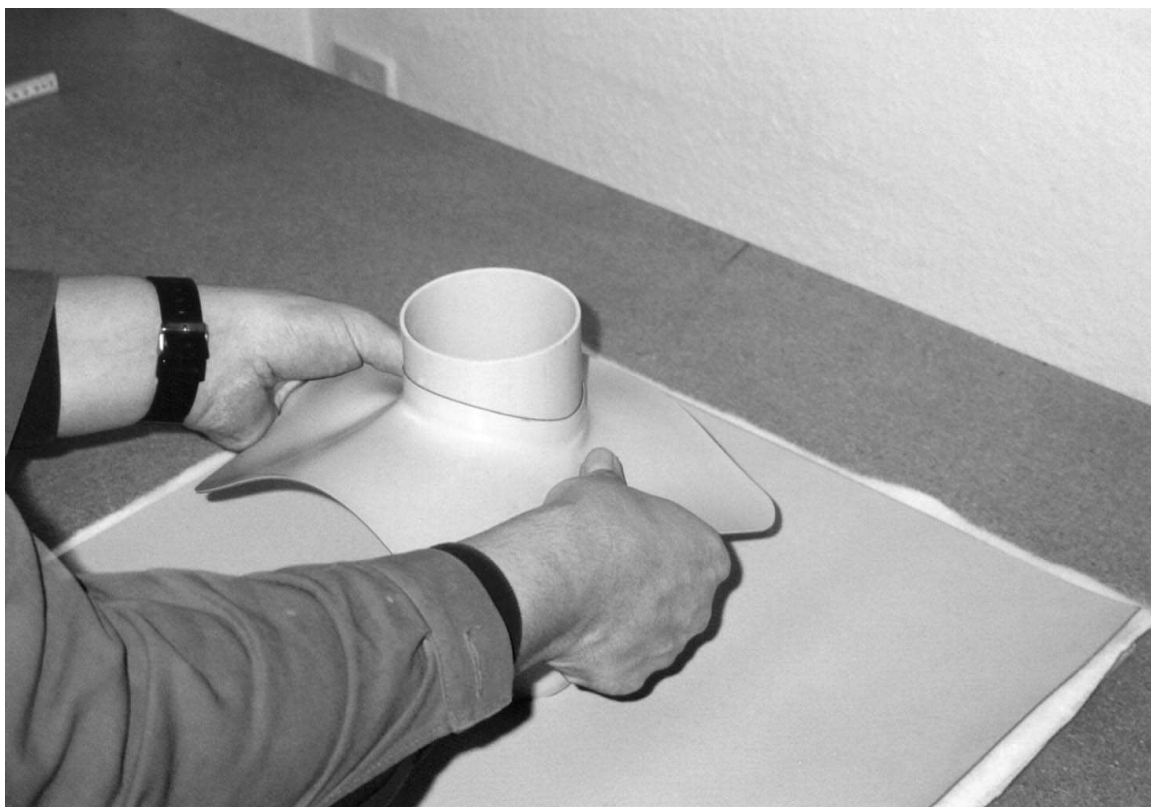
Obrázek 20.: Opracování prostupu - nasazení manžety na prostup
