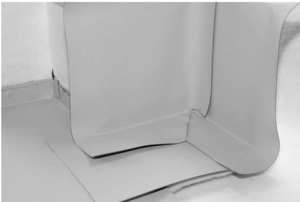
Obrázek 11.: Postup opravování hydroizolace v koutu
