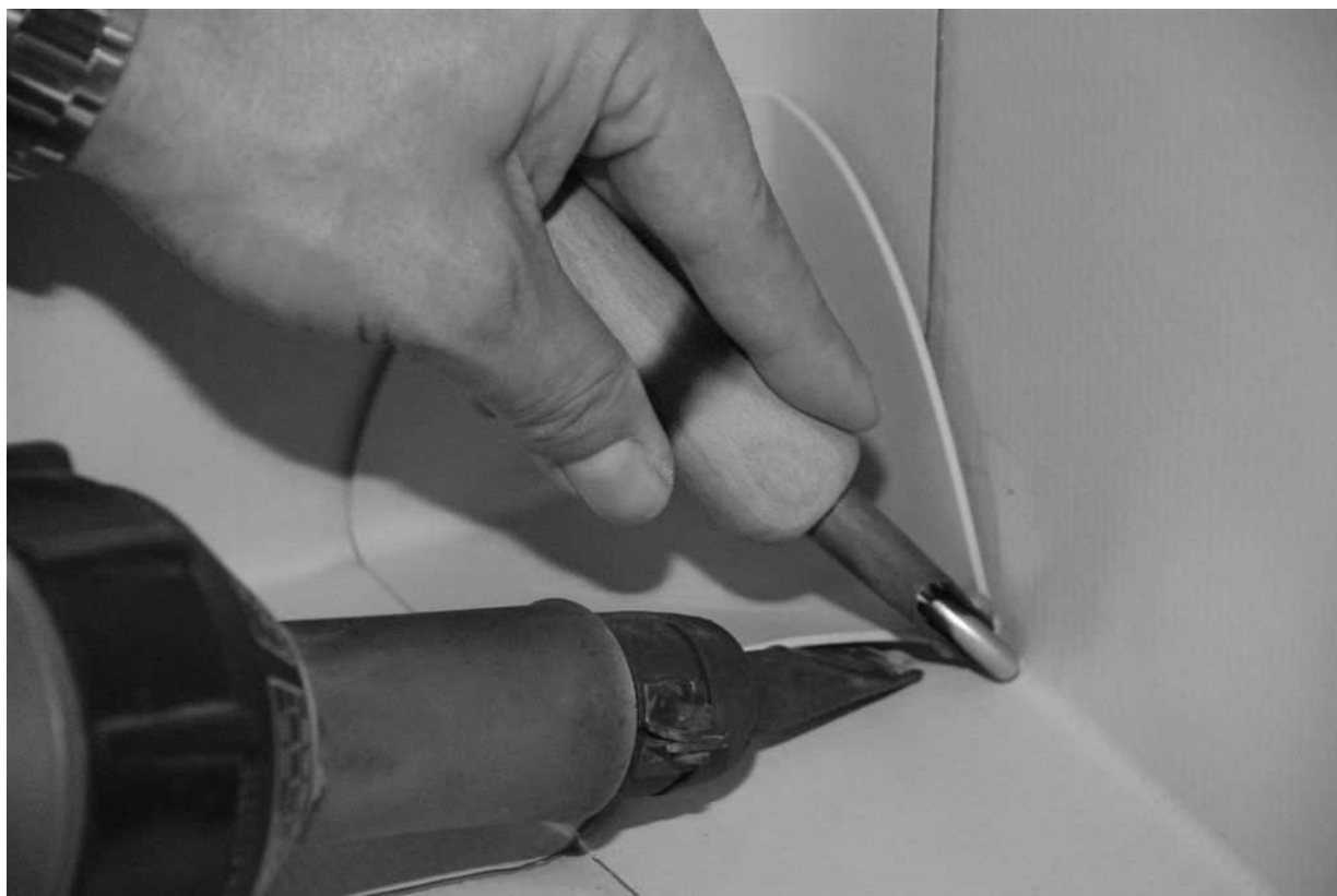
Obrázek 15.: Postup opracování hydroizolace v koutu
