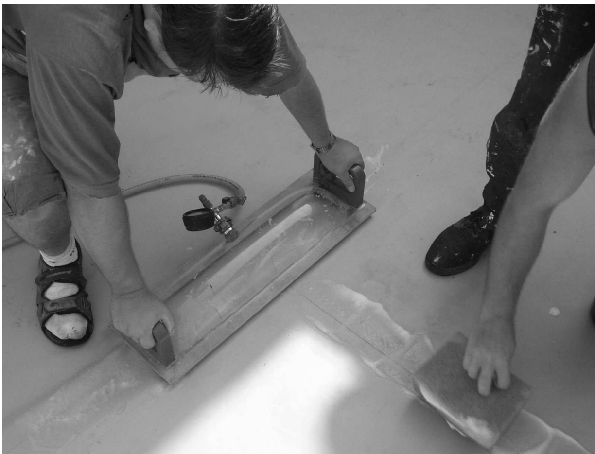
Obrázek 25.: Zkoušení těsnosti spojů vakuovou zkouškou
