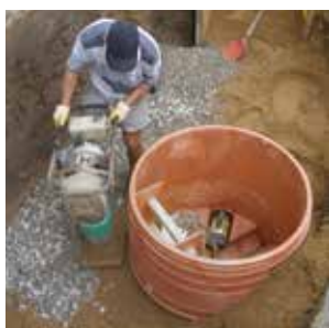
Hutnění zeminy Obr. 17
