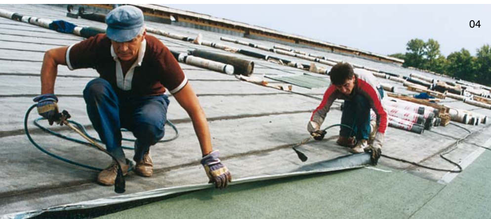
04 | plnoplošné natavování vrchní vrstvy pásu na střeš střediska společnosti DEKTRADE a.s. se spádem 17%
