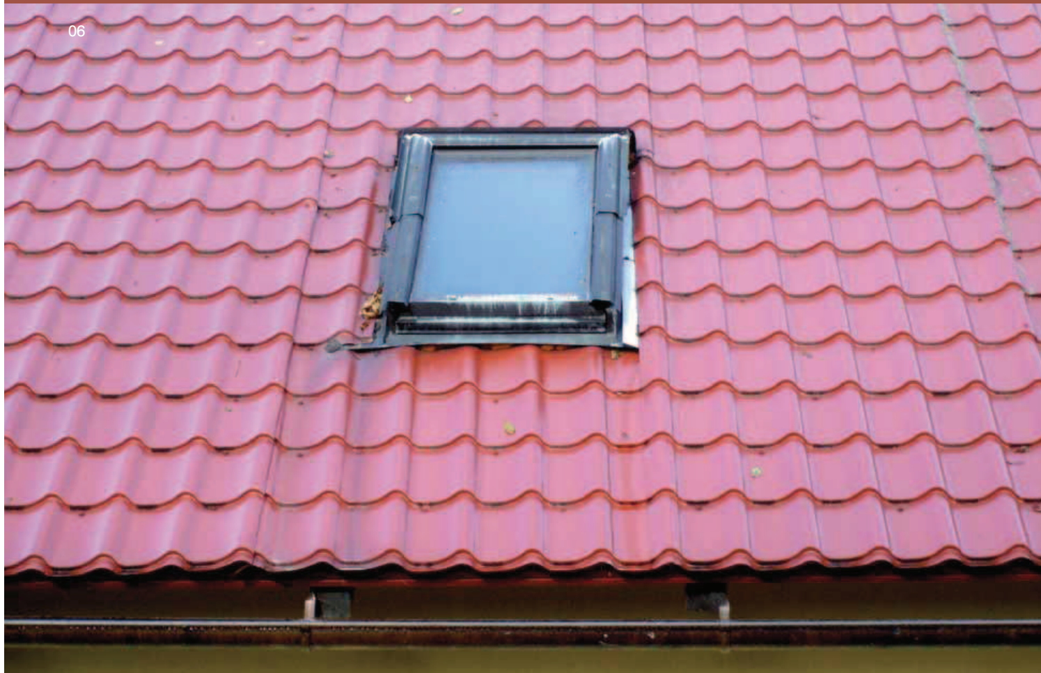
06| Nerovné umístění okna, boční lemování okna není pod krytinou, nepřipustné spodní rovné lemování navíc v levém dolním rohu bez vložení do vodorovného spoje tabulí.
