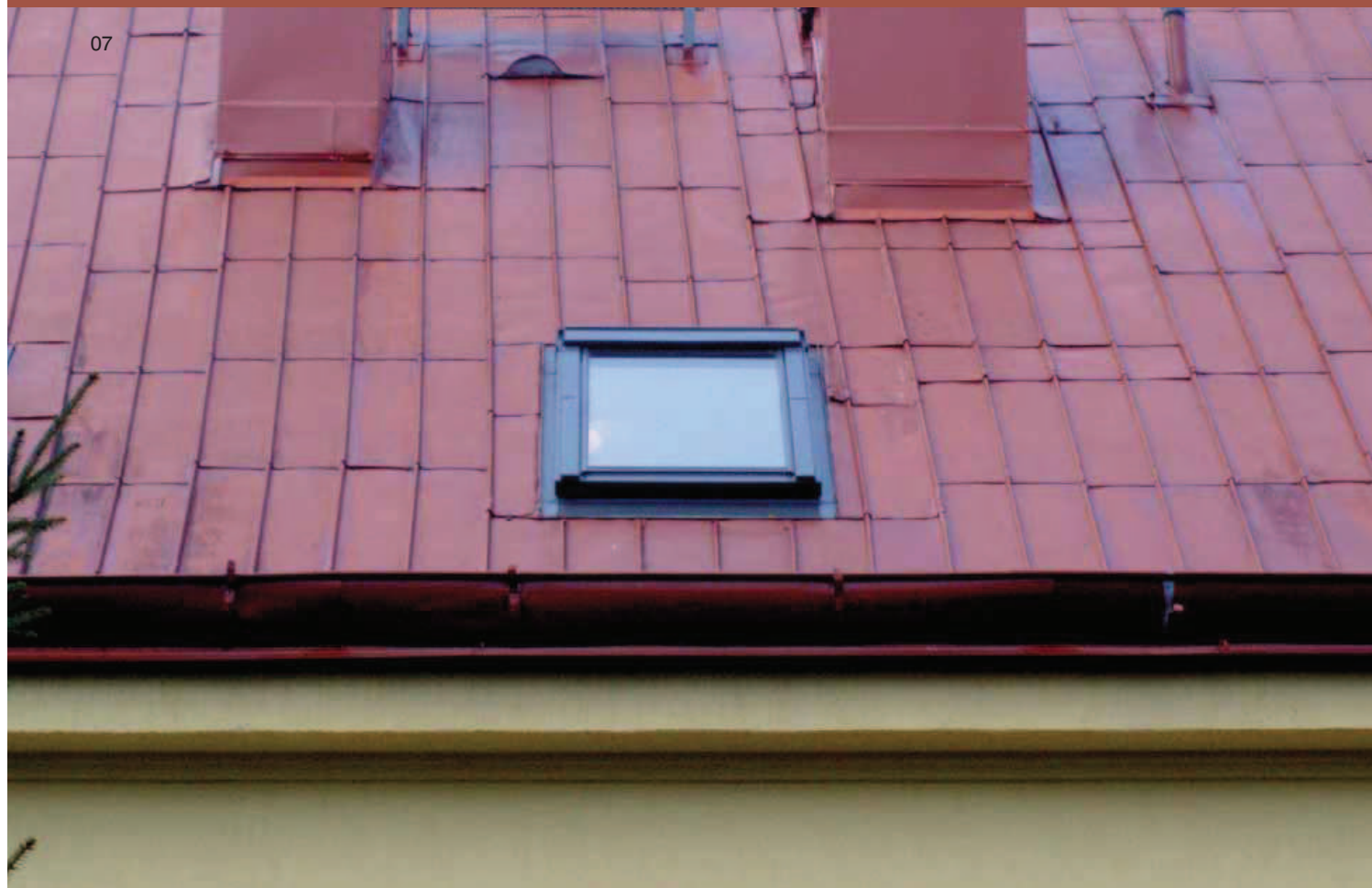
07 | Srovnané vlny na plechové tabuli a upravený okraj lemování 08 | Rovné lemování používané do hladké krytiny
