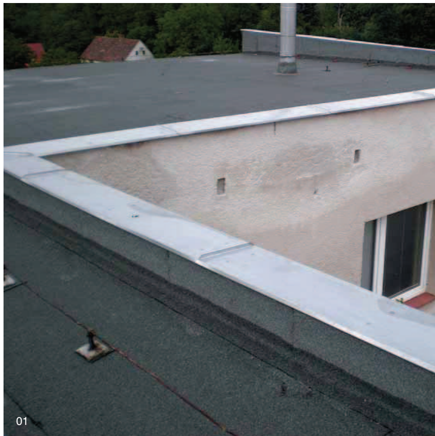
01 | Jednoplášťová střecha se spádovým násypem a kanálky z dutinových cihel. Na atice projevy vlhkosti akumulované v násypu.
