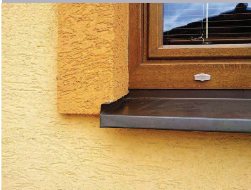
Správné napojení ohýbaného parapetu na zateplené ostění
