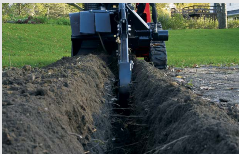
Vyhlazovač a nabírací šneky vynášejí zeminu z příkopu.
