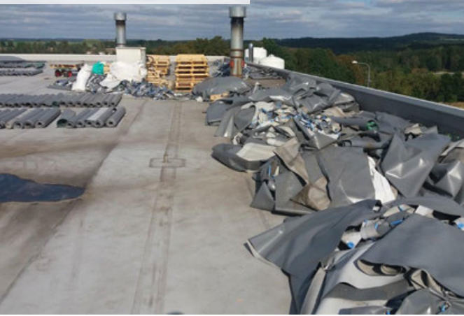
Pokládka a stabilizace nové hydroizolace z PVC-P fólie
