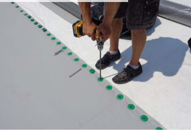
Pokládka a stabilizace nové hydroizolace z PVC-P fólie
