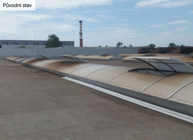
Odstraňování původní hydroizolace střechy
