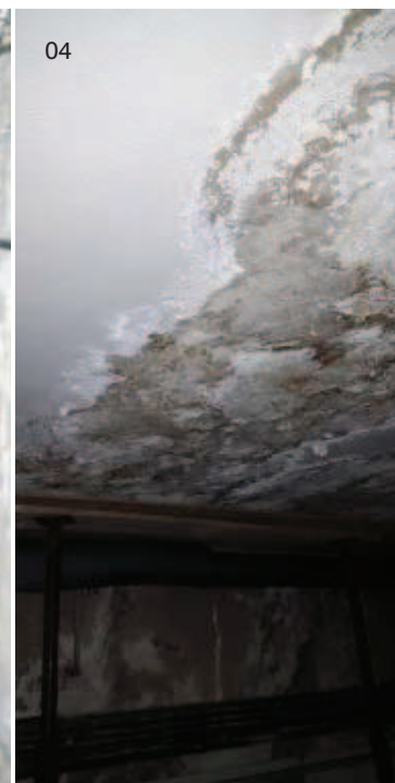
03| Interiér chodby s patrnými defekty – opadaná omítka a louže.
