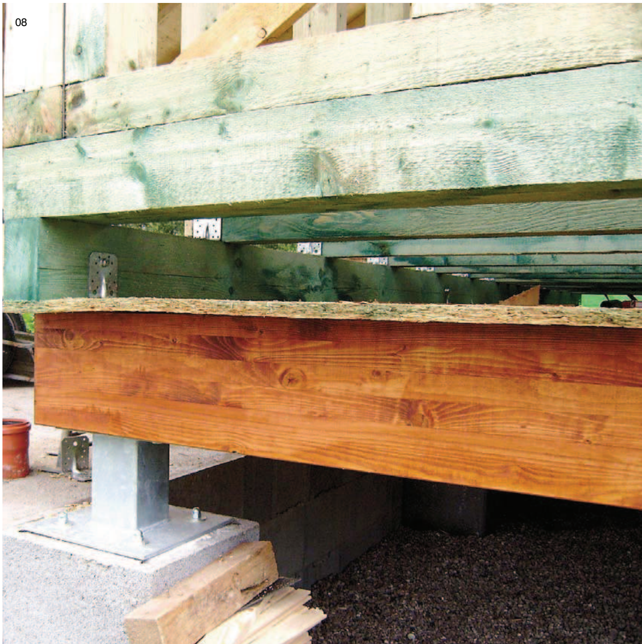
08| Detail podlahy založené na betonových pilířcích
