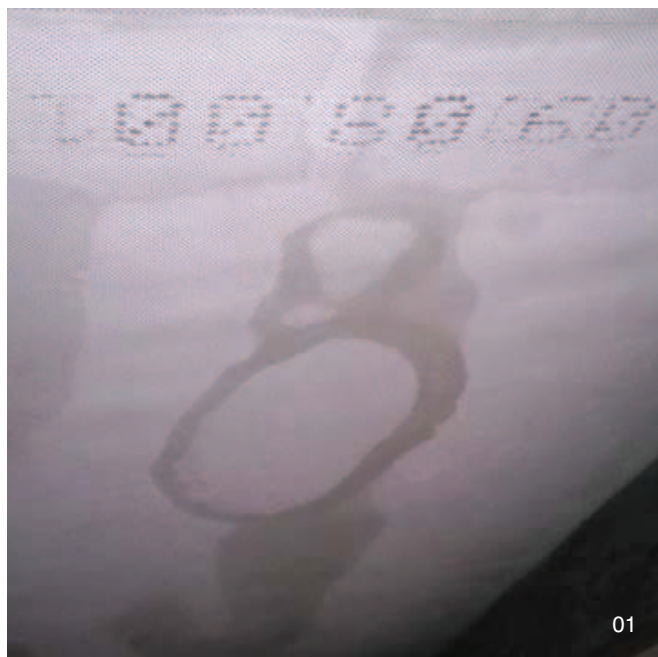
01 | Stopy po průsaku mikroporézní fólie
