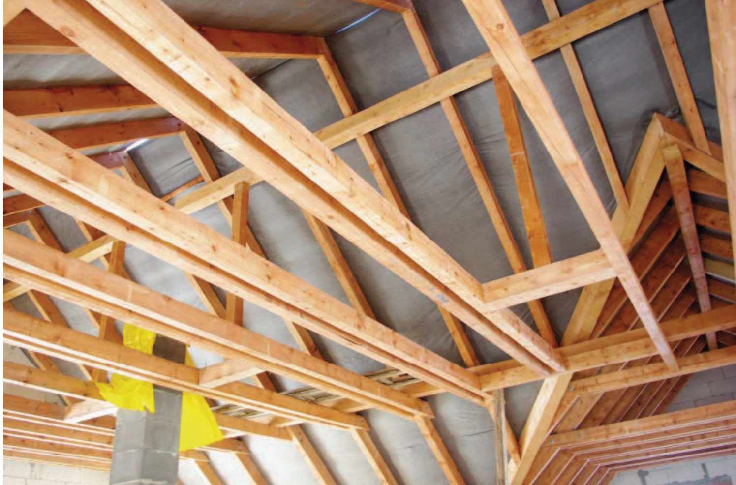
16| Vystavěný krov v objektu, kde nebyly vyžděny vnitřní stěny (patno z vrcholové vaznice boční střechy)
