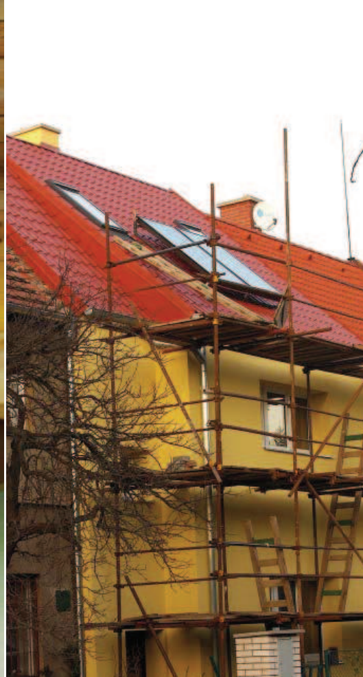
19| Osazení solárních systémů na staré krovy je vhodné z důvodů zadržování sněhu realizovat co nejvýše hřebeni. V tomto případě tomu tam nebylo.
