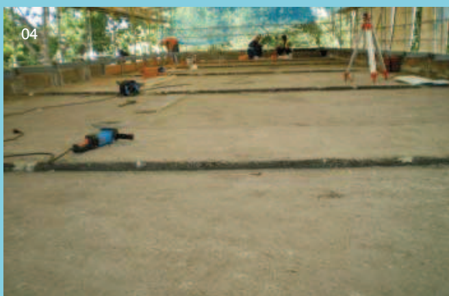
05 | Zaměření pro návrh vyrovnání
